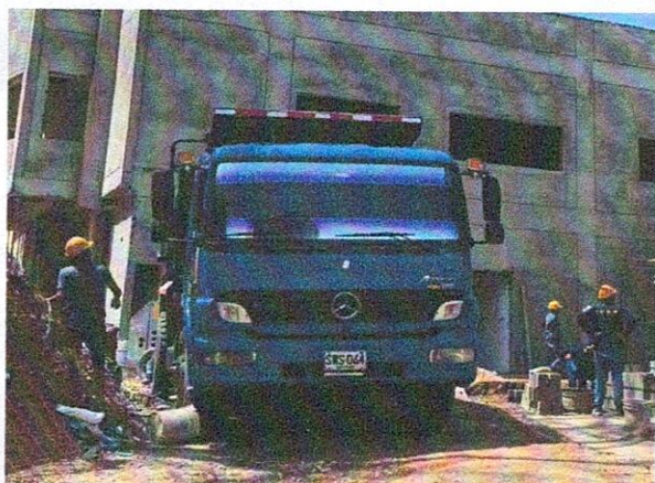
Foto No. 37 Vehículos en obra
