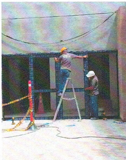
SE AVANZA CON LA INSTALACIÓN DE PUERTA VIDRIERA EN ACCESO A PATIO 2 DESDE BLOQUE ADMINISTRATIVO.
