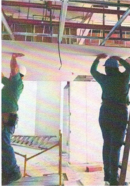
INSTALACIÓN DE PLACAS EN DRY WALL PARA CIELO FALSO EN PRIMER NIVEL DEL BLOQUE ADMINISTRATIVO.
