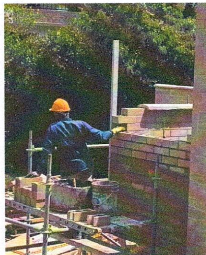
MAMPOSTERÍA EN BLOQUE TIPO CATALÁN EN ÁTICO DEL BLOQUE 1.
