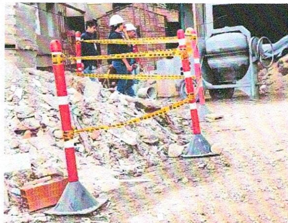
Foto No. 48 Señalización en obra
