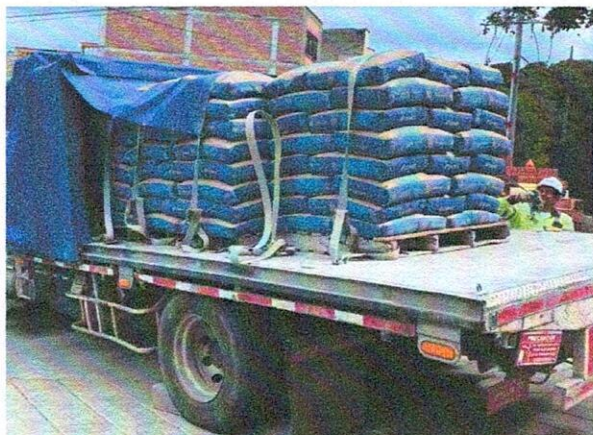
Foto No. 24 Recepción de materiales de construcción
