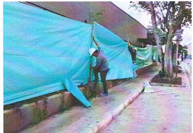
Foto No. 21 Mantenimiento cerramiento perimetral de la obra
