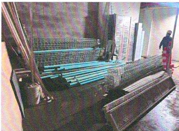
Foto No. 28 Acopio de materiales de construcción
