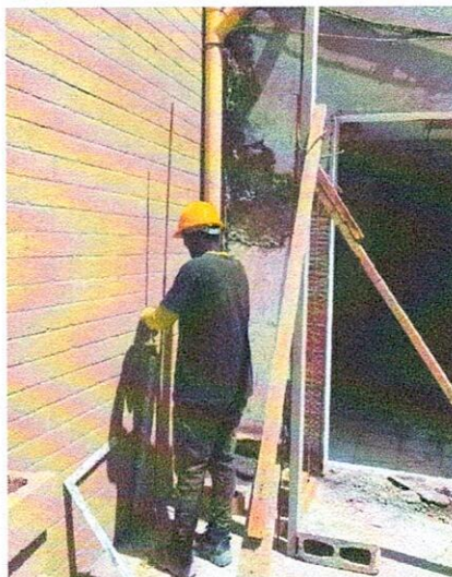
INSTALACIÓN DE ACERO DE REFUERZO PARA DOVELAS EN BUITRÓN EN PATIO 2.
