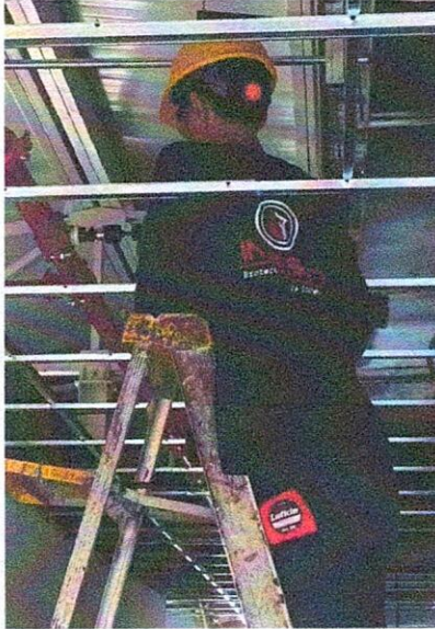
SE AVANZA CON INSTALACIÓN DE ACCESORIOS PARA EXTINCIÓN RCI EN EL BLOQUE 1.
