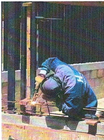
INSTALACIÓN DE CERRAMIENTO TUBULAR EN ZONA DE PARQUEADERO.
