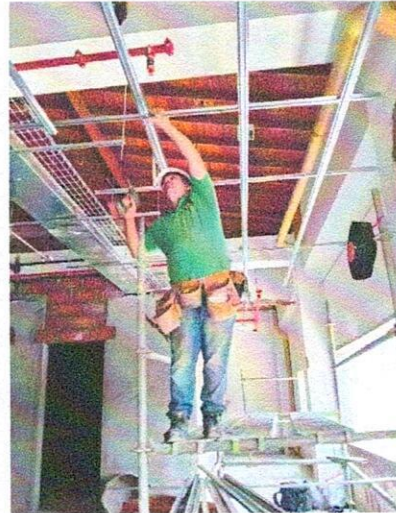
INSTALACIÓN DE ESTRUCTURA PARA CIELO FALSO EN EL SEGUNDO NIVEL DEL BLOQUE ADMINISTRATIVO.
