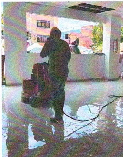
DESTRONQUE DE PISO EN SALA DE ESPERA CRECIMIENTO Y DESARROLLO.
