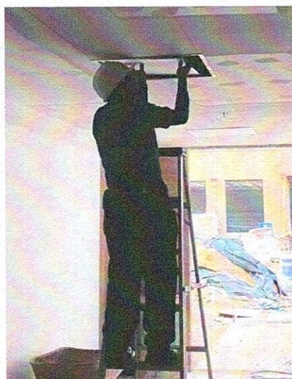
INSTALACIÓN DE ILUMINARIAS 60X60 CM EN EL PRIMER NIVEL DEL BLOQUE ADMINISTRATIVO.
