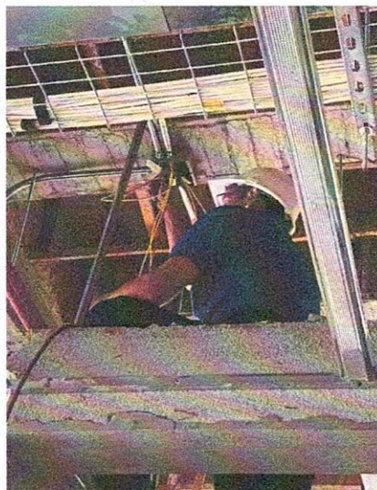
INSTALACIÓN DE CABLE N.12 PARA RED ELÉCTRICA EN LA SALA DE ESPERA CONSULTA EXTERNA.
