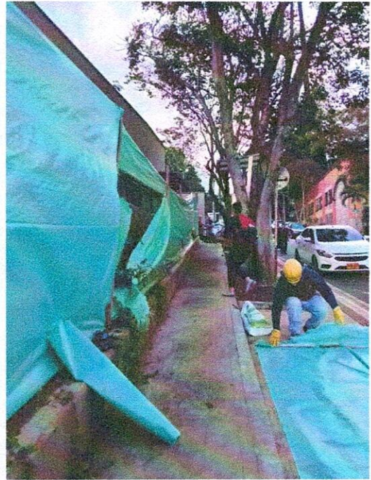
Foto No. 23 Mantenimiento cerramiento perimetral de la obra
