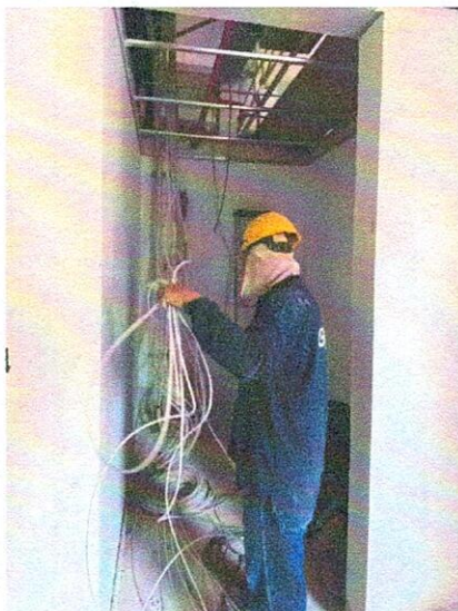
INSTALACIÓN DE CABLE UTP PARA VOZ Y DATOS EN CUARTO TÉCNICO ELÉCTRICO EN BLOQUE 1.
