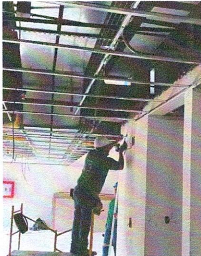
INSTALACIÓN DE ESTRUCTURA PARA CIELO FALSO EN EL BLOQUE 1.
