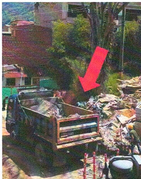
Foto No. 15 Evacuación de residuos de demolición
