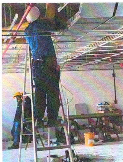
INSTALACIÓN DE CABLE N.12 PARA RED ELÉCTRICA EN LA SALA DE ESPERA CRECIMIENTO Y DESARROLLO.
