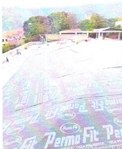
INSTALACIÓN PERMOFIT CUBIERTA DEL BLOQUE ADMINISTRATIVO
