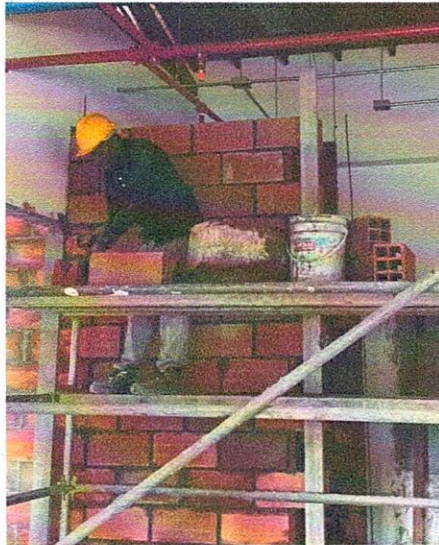
SE CONTINUA CON LA MAMPOSTERÍA EN LADRILLO SUCIO E=15 CM PARA DIVISIONES INTERNAS EN EL SEGUNDO NIVEL DEL BLOQUE ADMINISTRATIVO.
