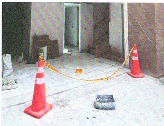
Foto No. 47 Señalización en obra
