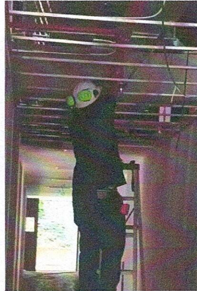
SE AVANZA CON INSTALACIÓN DE ACCESORIOS PARA EXTINCIÓN RCI EN EL BLOQUE 2.
