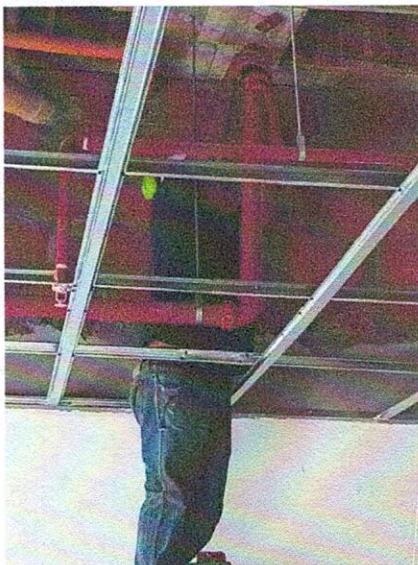
INSTALACIÓN DE TUBERÍA 2 ½" PARA EXTINCIÓN RCI EN SALA DE ESPERA CONSULTA EXTERNA.
