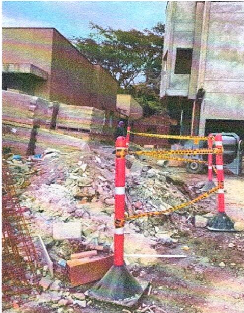
Foto No. 10 Acopio de residuos de demolición
