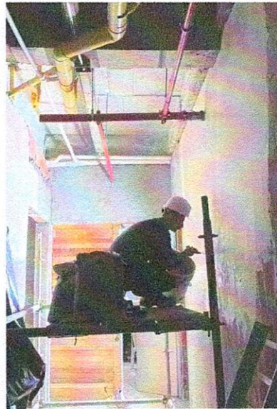
SE AVANZA CON LA APLICACIÓN DE ESTUCO EN EL SÓTANO.
