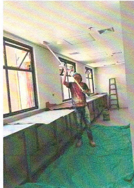
APLICACIÓN DE PINTURA TIPO 1 EN CIELO MODULOS DE ODONTOLÓGIA (BLOQUE 2).
