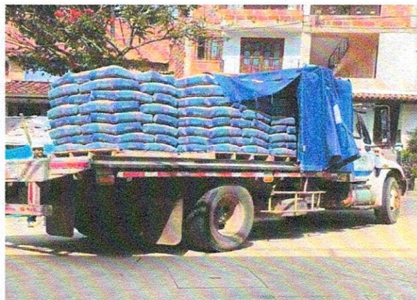
Foto No. 25 Recepción de materiales de construcción
