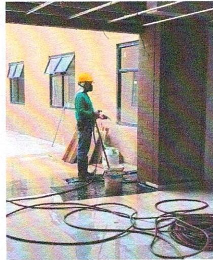
APLICACIÓN DE ÁCIDO NÍTRICO PARA LAVADA DE FACHADA INTERIOR EN BLOQUE DE FISIOTERAPIA.
