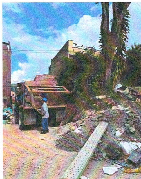
Foto No. 17 Evacuación de residuos de demolición
