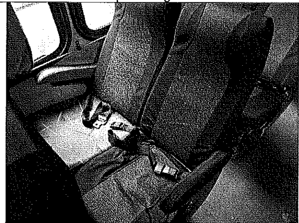
Inspección cinturones de seguridad
