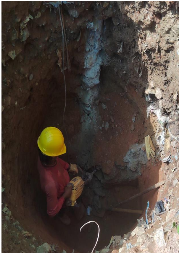
Ilustración 3. Demolición de extracto rocoso
