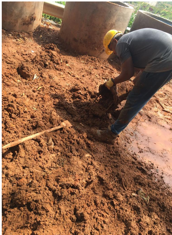
Ilustración 8. Material proveniente de excavaciones
