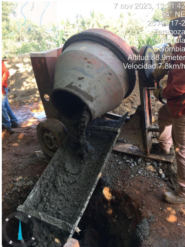
Ilustración 11. Concreto para pilas
