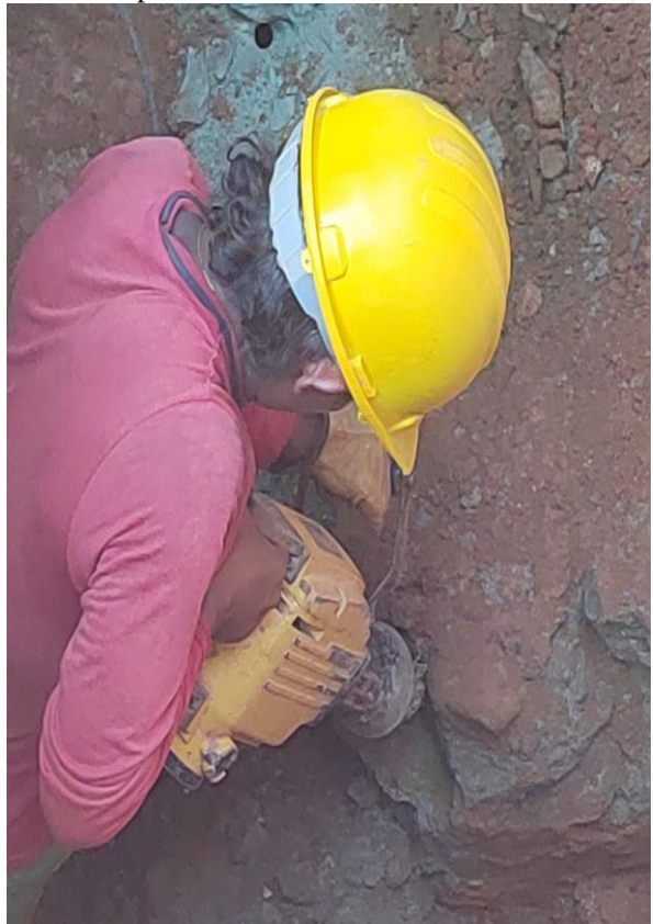
Ilustración 4. Exvación profunda en extracto rocoso
