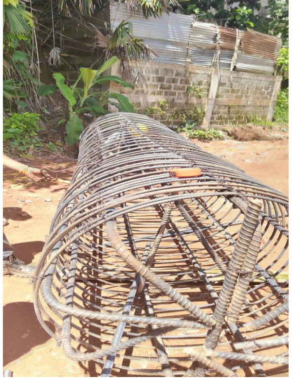
Ilustración 8. acero para pilas
