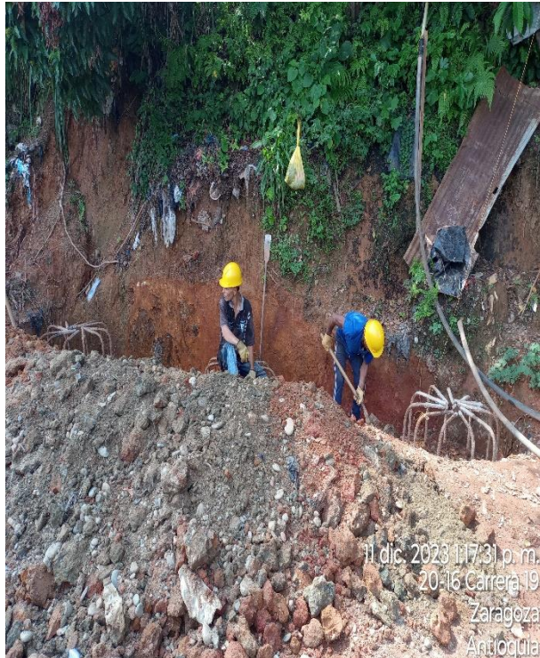
Ilustración 5. excavación para viga
