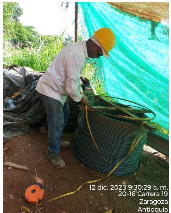
Ilustración 6. armado de acero
