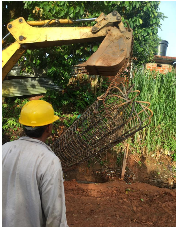
Ilustración 3. acero para pilas
