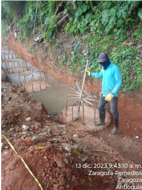
Ilustración 9. Solado para viga
