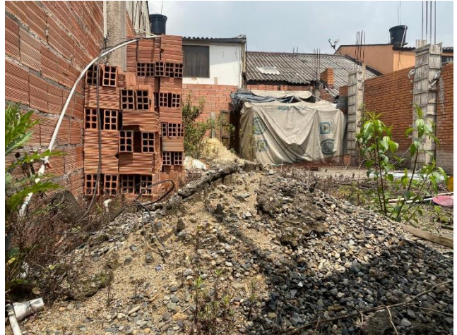
Vista al interior de la fachada sobre Diagonal 5A
