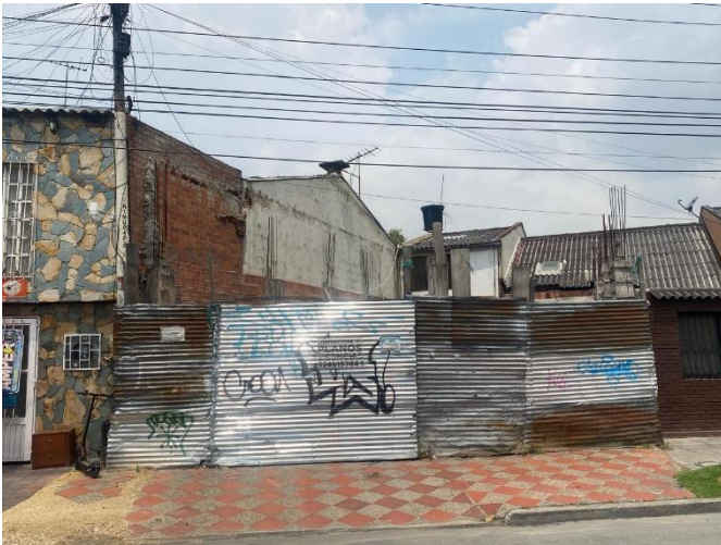
Fachada del inmueble sobre la Diagonal 5A
