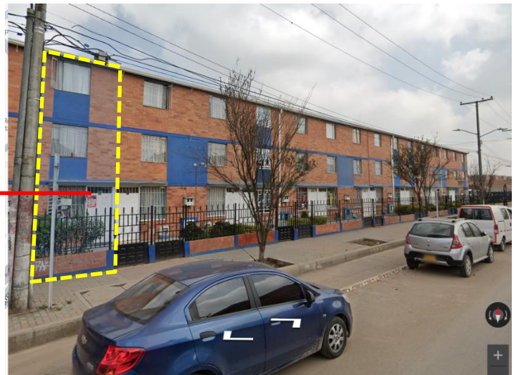
Ubicación casa 12 en fachada del conjunto sobre carrera 90A
