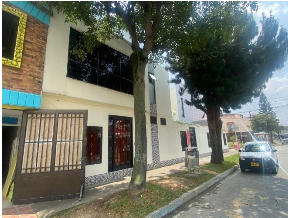
Fachada sobre la carrera 73C
