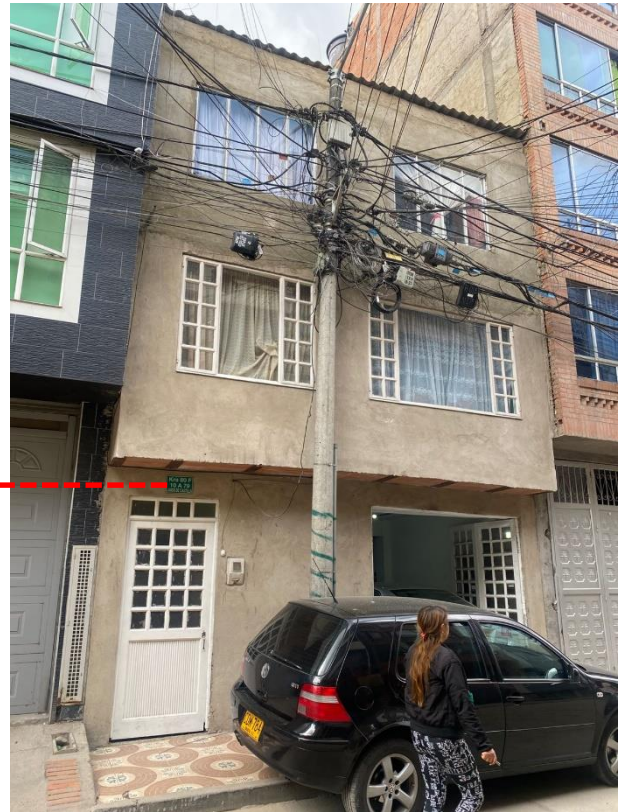
Fachada principal del inmueble objeto de la visita
