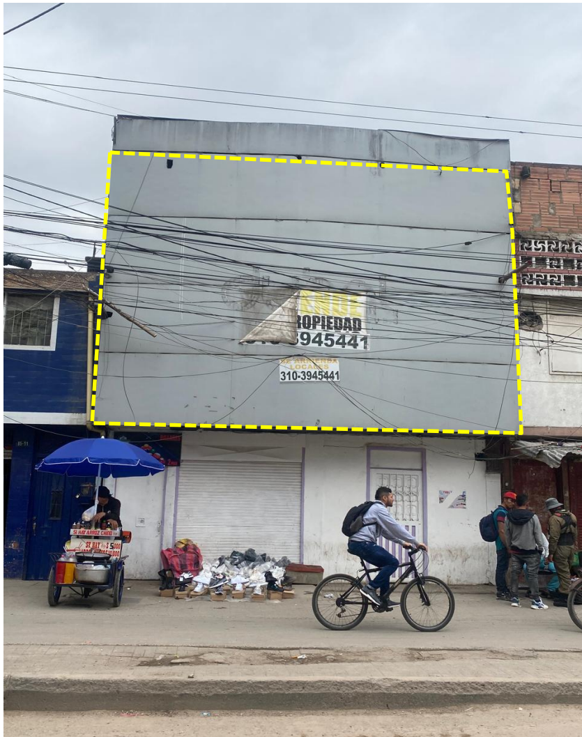
Fachada Principal y Localización del Local dentro del inmueble
