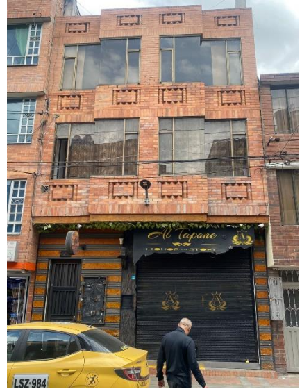
Ubicación en fachada principal
