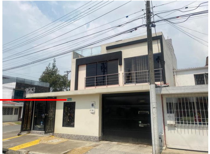
Fachada sobre la calle 3B
