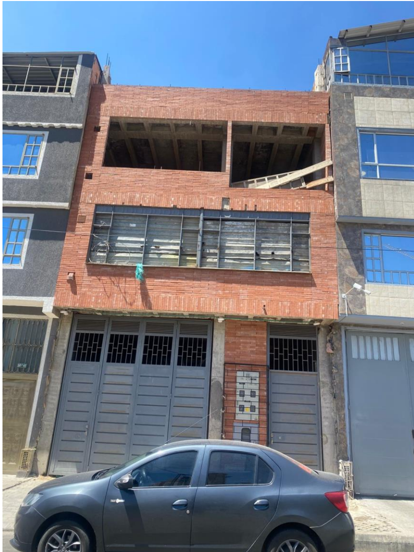
Fachada principal del inmueble objeto del expediente, imagen de la fecha de la visita feb-2025
