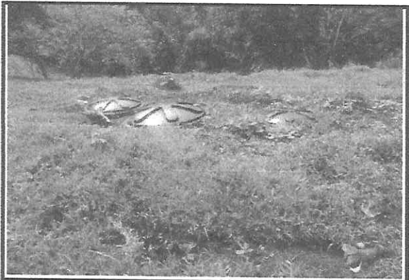
OBSERVACIONES: Instalación Sistema Septico BARRIO O SECTOR: Amolador MUNICIPIO: Supia CONTRATO: 21102024-1443 FECHA: ENE 31-2025
