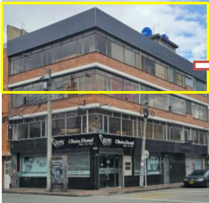
IMAGEN 2: REGISTRO FOTOGRÁFICO ACTUAL FACHADA PRINCIPAL - MAYO 17 DE 2024
