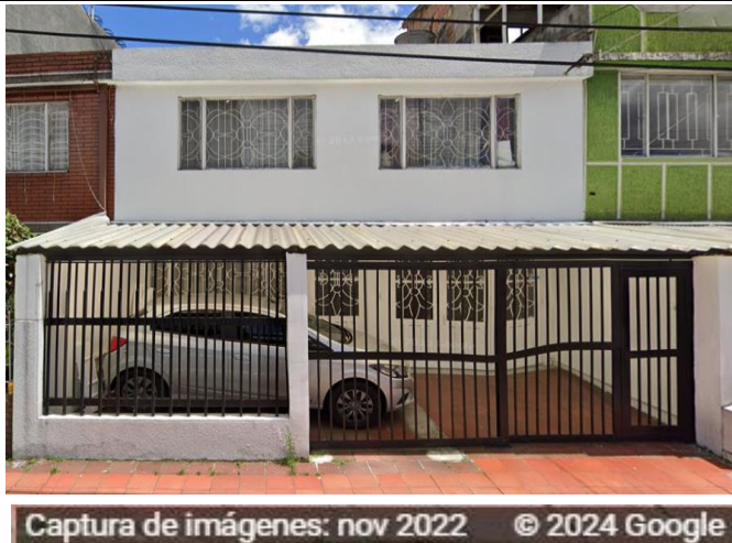
LOCALIZACION ACTUAL - [FUENTE google maps] NOV- 2022
