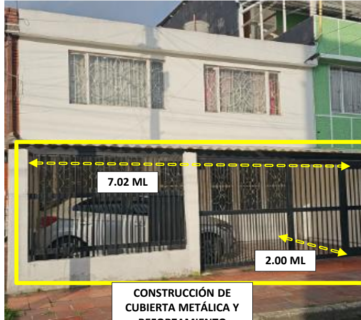
IMAGEN 2: REGISTRO FOTOGRÁFICO ACTUAL FACHADA PRINCIPAL PREDIOS 1 Y 2 - MAYO 15 DE 2024
