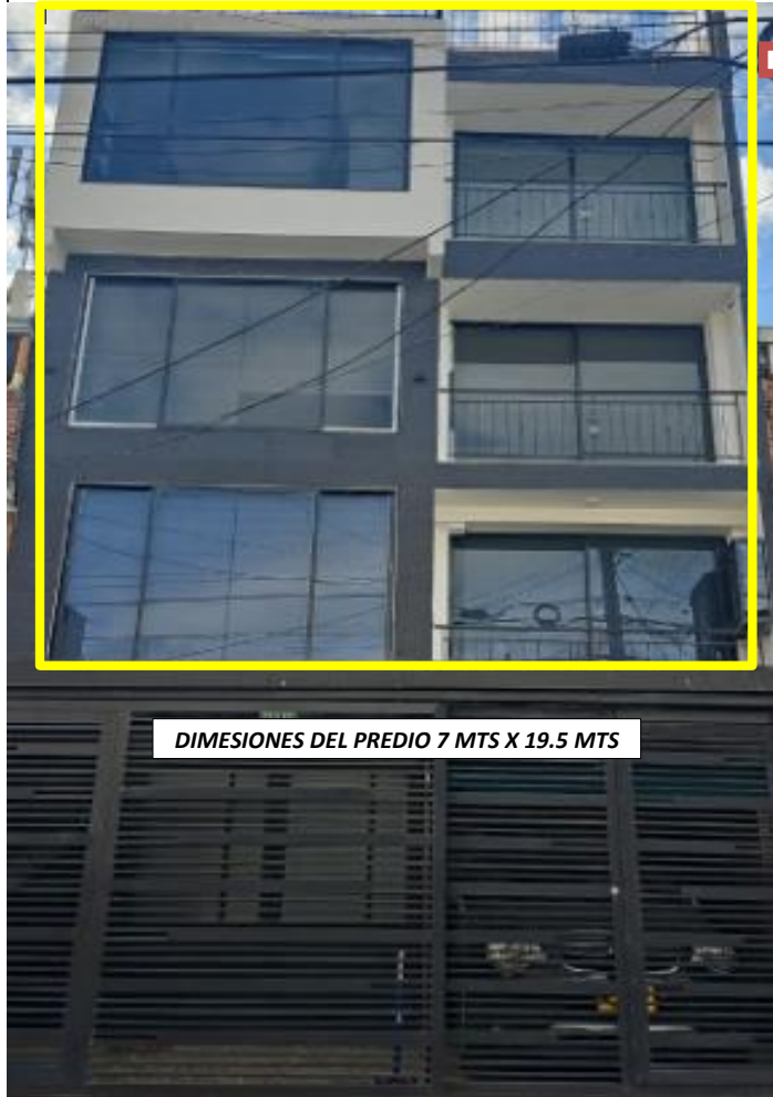
IMAGEN 2: REGISTRO FOTOGRÁFICO ACTUAL FACHADA PRINCIPAL - MAYO 16 DE 2024
