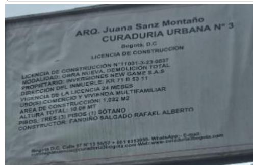
VALLA DE LICENCIA DE CONSTRUCCIÓN
