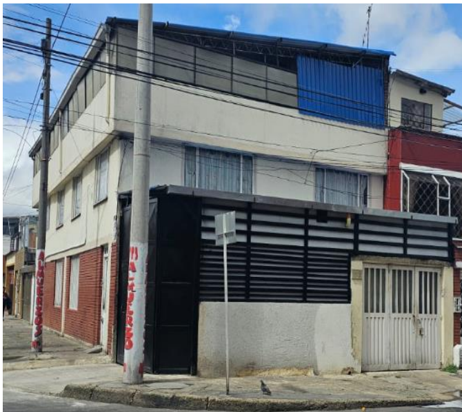
FOTO DE FACHADAS PRINCIPAL Y LATERAL JULIO 30 DE 2024
