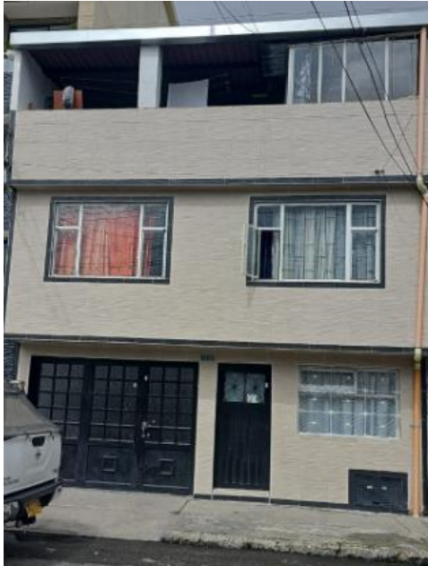
FOTO FACHADA PRINCIPAL ACTUAL JUNIO 24 DE 2024
