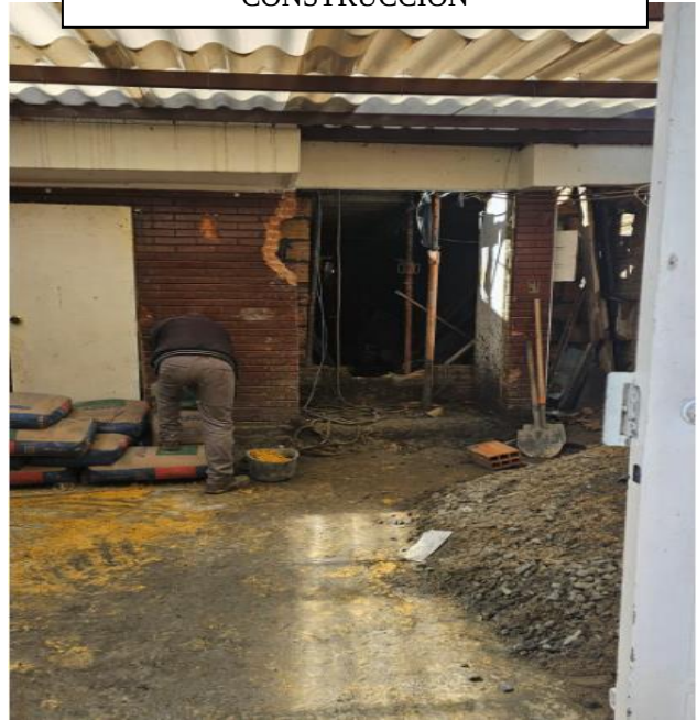
FOTO AL INTERIOR DEL PREDIO EN CONSTRUCCIÓN
