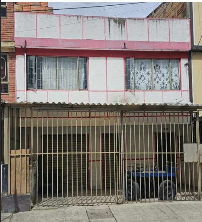
FOTO FACHADA PRINCIPAL 24-JUN-2024
