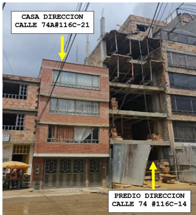
FOTO FACHADA PRINCIPAL ACTUAL JUNIO 24 DE 2024
