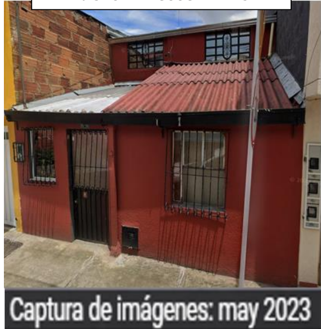
FOTO FACHADA PRINCIPAL MAYO 2023 FUENTE GOOGLE MAPS
