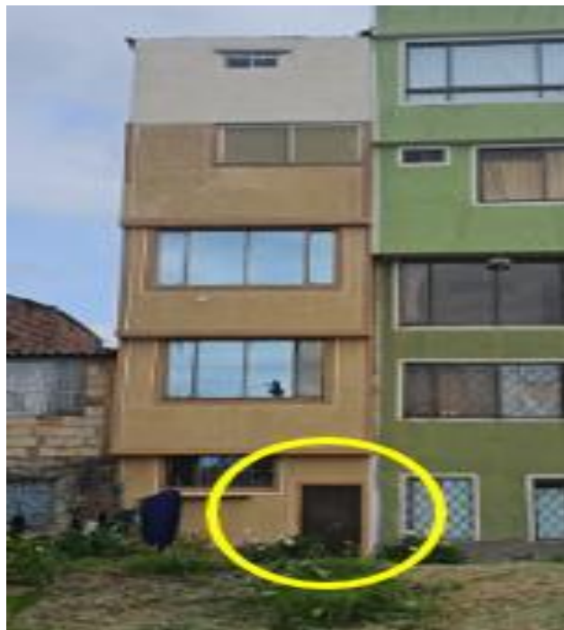
FOTO FACHADA POSTERIOR ACTUAL JULIO 17 DE 2024 (CALLE 66B #126-20)
