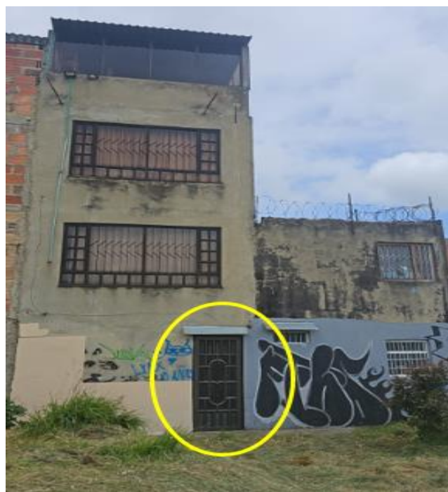
FOTO FACHADA POSTERIOR ACTUAL JULIO 17 DE 2024 (CALLE 66B #126-54)
