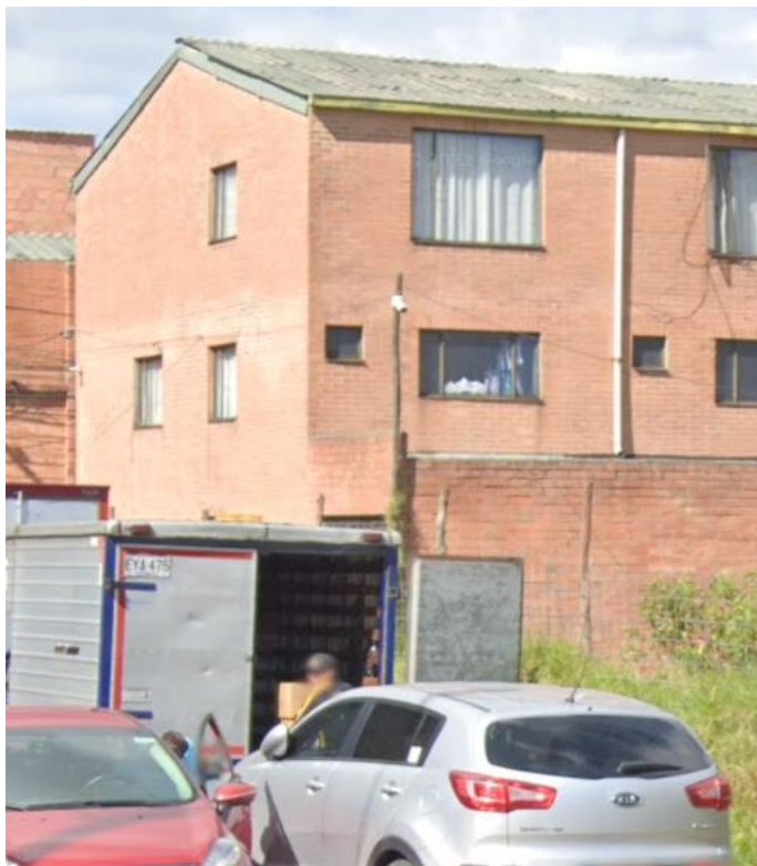
FOTO FACHADA POSTERIOR MAYO DE 2023 (FUENTE GOOGLE MAPS)
