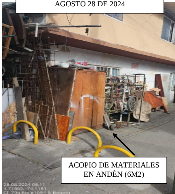
FOTO ACTUAL FACHADA LATERAL AGOSTO 28 DE 2024
