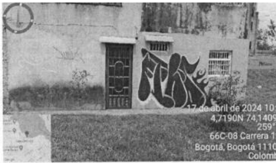
Fotografía No 2 – Coordenadas N 4,7190° W 74,1409° Registro de puerta en la dirección Carrera 125 #66c-08.
