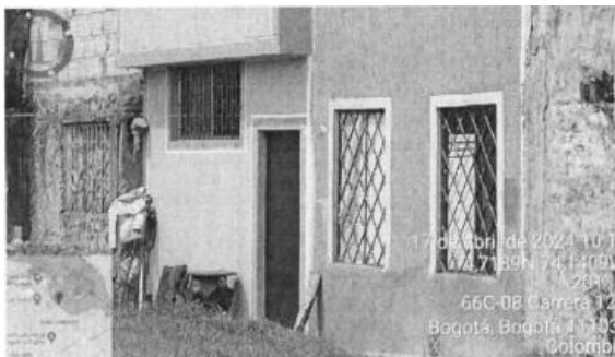
Fotografía No 1 – Coordenadas N 4,7189° W 74,1409° Registro de puerta en la dirección Carrera 125 #66c-08.
