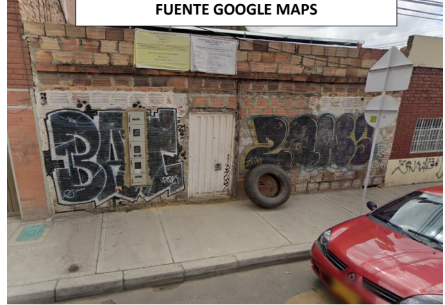
FOTO FACHADA PRINCIPAL MAYO 2024 FUENTE GOOGLE MAPS
