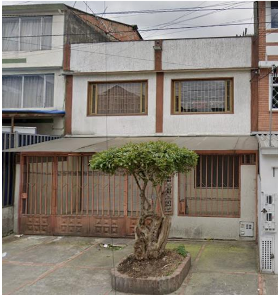
FOTO FACHADA PRINCIPAL JUNIO 2023 (FUENTE GOOGLE MAPS)
