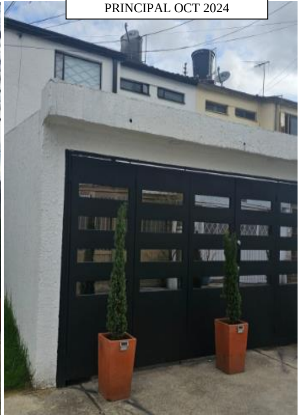
FOTO ACTUAL FACHADA PRINCIPAL OCT 2024
