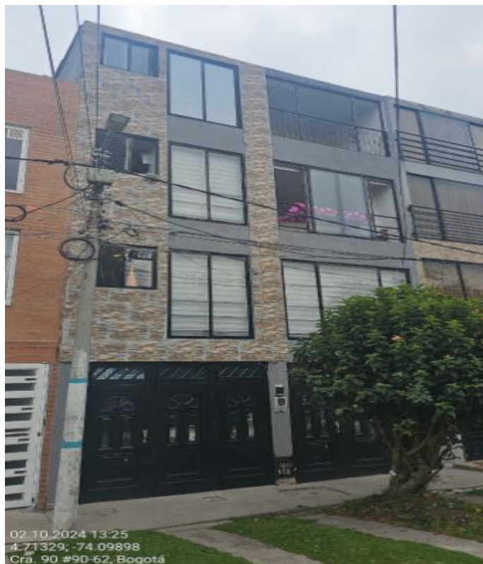
FOTO FACHADA PRINCIPAL OCTUBRE 20234
