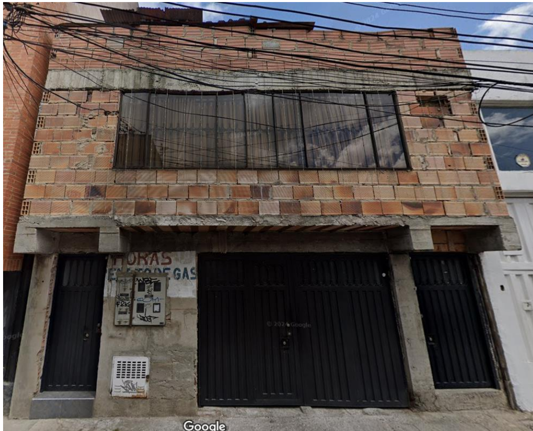
FOTO FACHADA PRINCIPAL MAYO 2023 (FUENTE GOOGLE MAPS)
