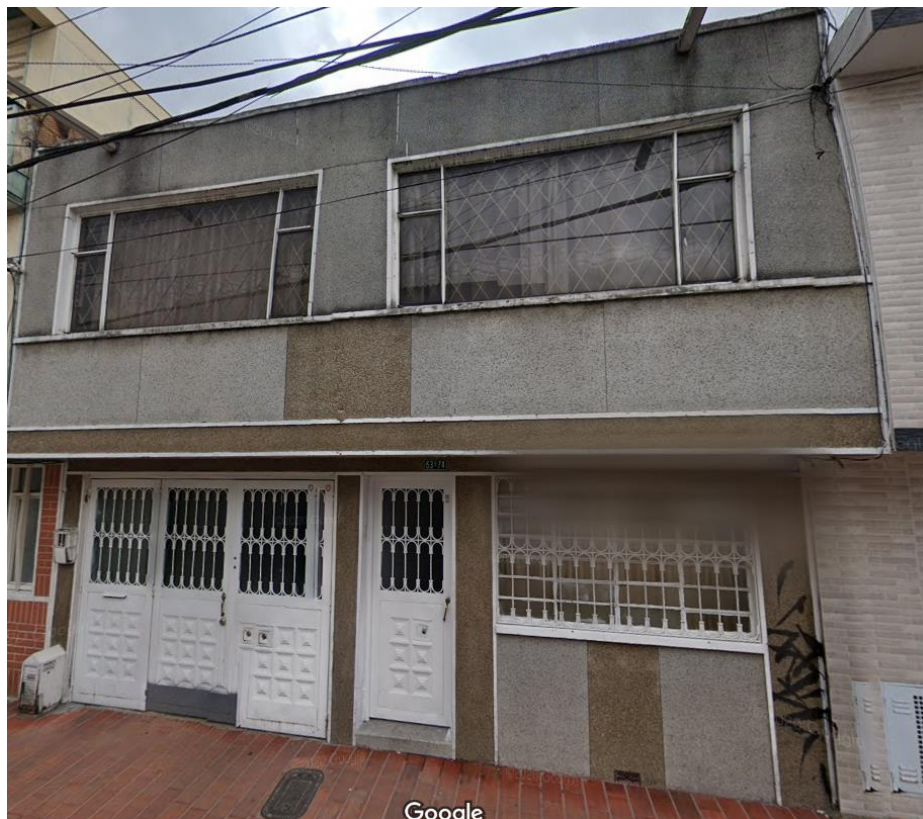
FOTO FACHADA PRINCIPAL MARZO 2020 (FUENTE GOOGLE MAPS)
