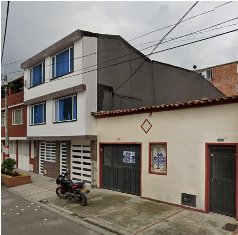
FOTO FACHADA PRINCIPAL SEP 2022 (FUENTE GOOGLE MAPS)
