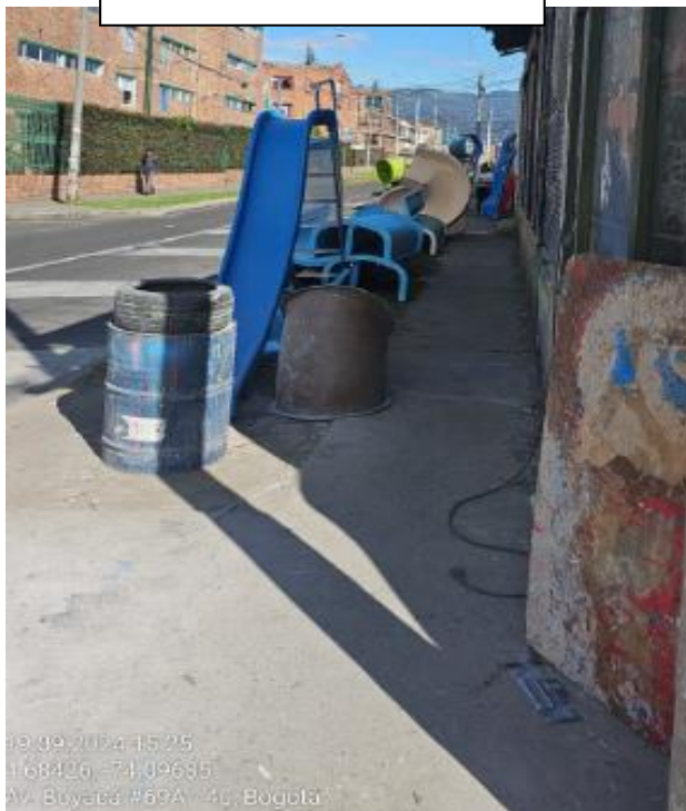
FOTO FACHADA LATERAL SEPTIEMBRE 19 -2024
