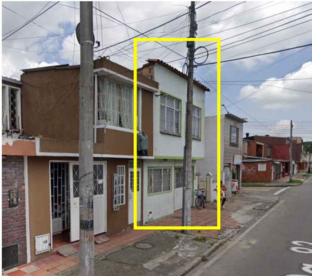
FOTO FACHADA PRINCIPAL MAYO 2023 (FUENTE GOOGLE MAPS)
