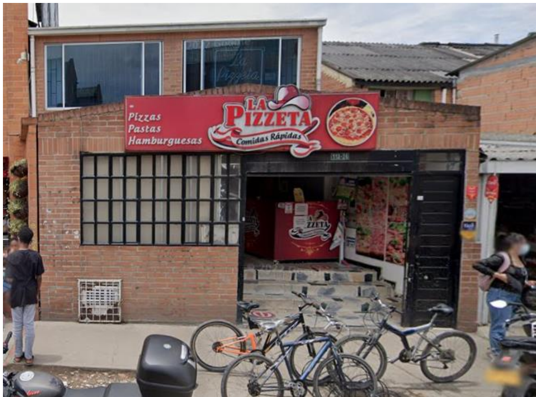
FOTO FACHADA PRINCIPAL ABRIL DE 2021 (FUENTE GOOGLE MAPS)
