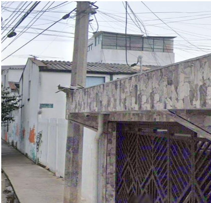
FOTO FACHADA PRINCIPAL MAYO 2023 (FUENTE GOOGLE MAPS)
