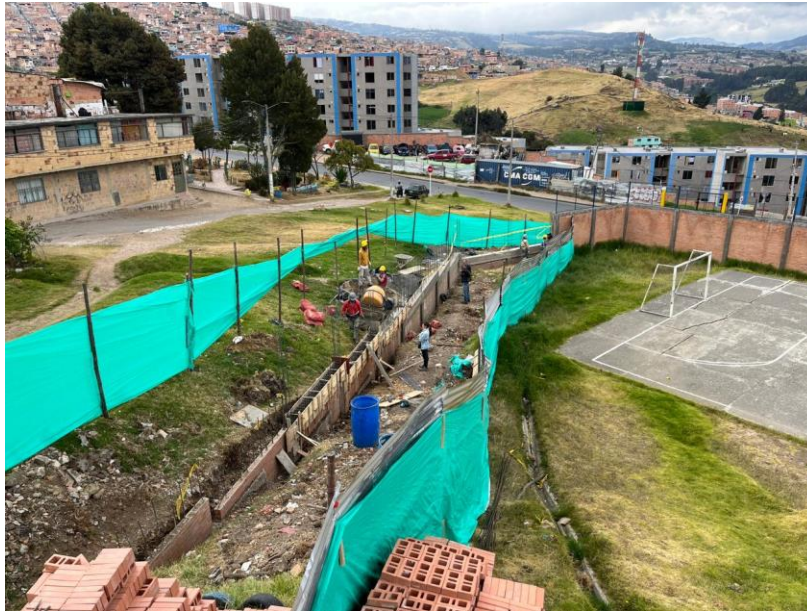
Foto 5. Trabajos sobre el muro – Mampostería.
