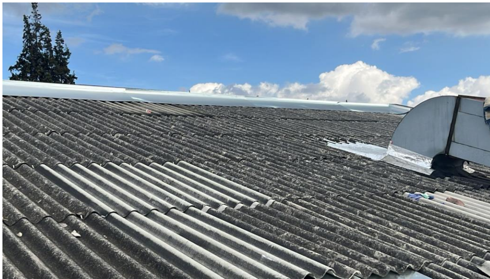
Foto 3. Instalación de flanches 05-02-25.
