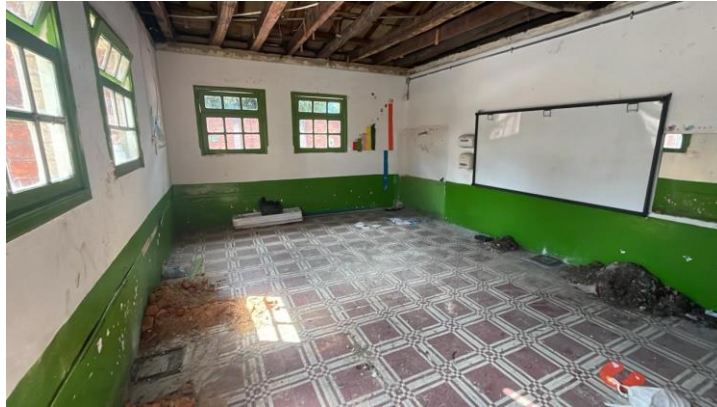
Foto 11. Excavación de tubería.
