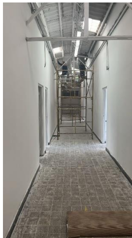
Foto 18. Actividades de pinturas en muros.
