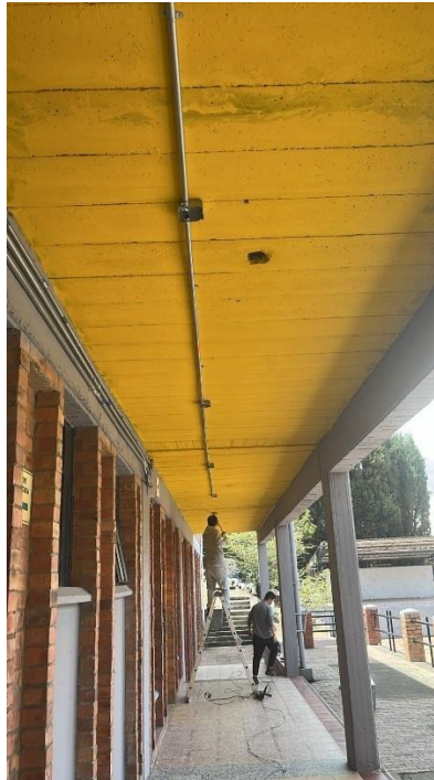
Foto 4. Instalación de puntos eléctricos área de bachillerato (07-02-25)
