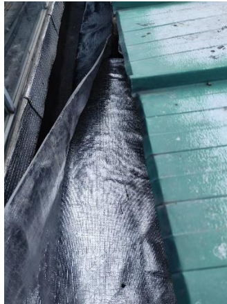
Foto 2. Instalación del Manto en canales.
