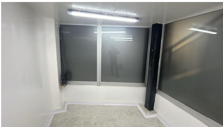
Foto 8. Evidencia de los trabajos de pintura finalizados e instalación de sandblasting en ventanas.
