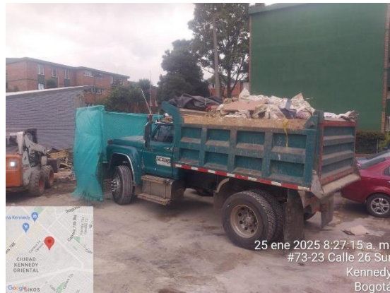
Foto 20. Retiro de material.
