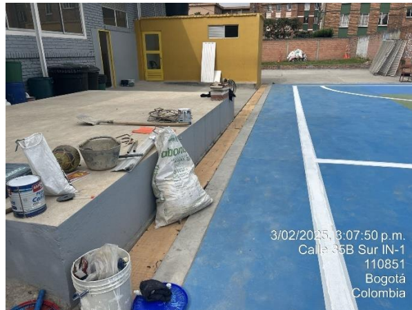
Foto 19. Protección del cárcamo.
