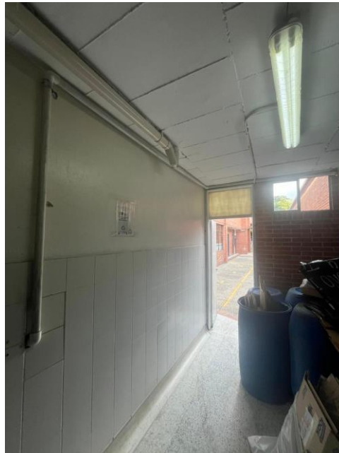
Foto 6. Evidencia de la instalación de la tubería de ventilación (07-02-25).
