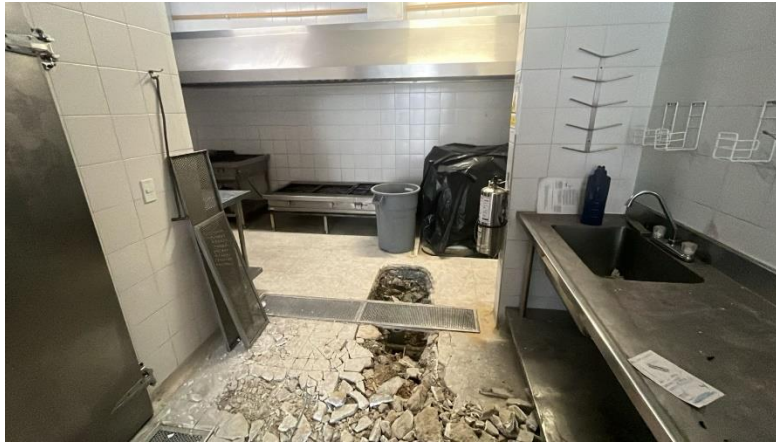
Foto 7. Demoliciones realizadas a corte del 05-02-25.
