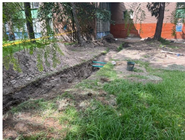
Foto 10. Excavación de tubería.
