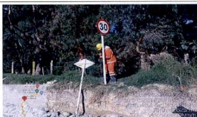
Foto 7. Instalación de señalización PMT.
