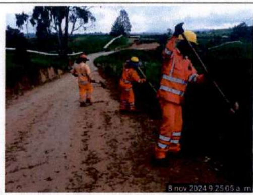
Foto 14. . Verificación de Epp
