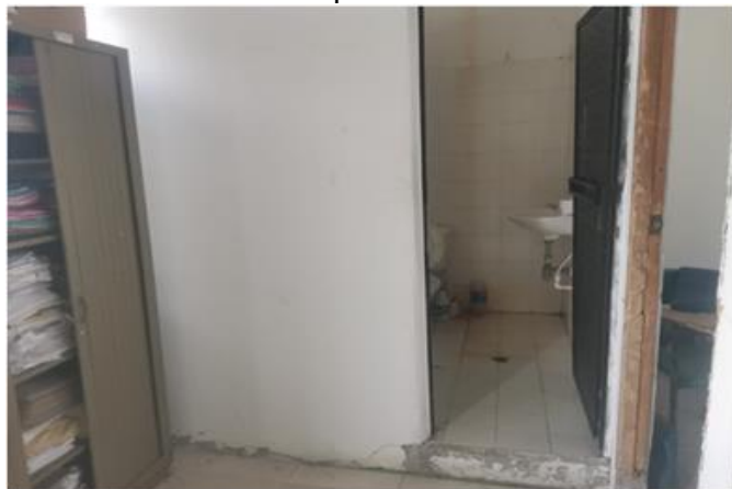
Ilustración 1. Demolición de piso de baño
