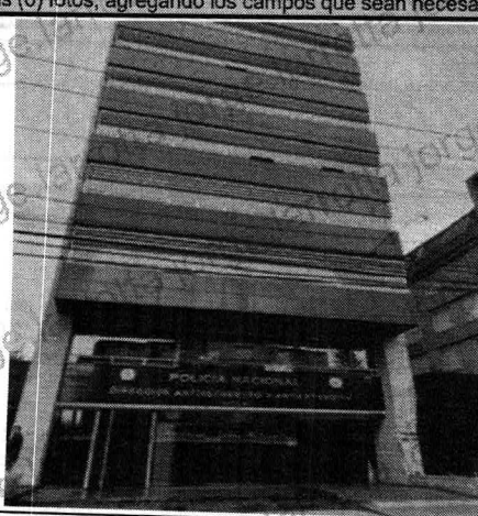
VISTA GENERAL - FACHADA
