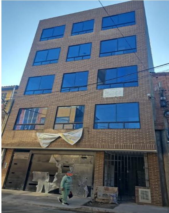
FOTO ACTUAL FACHADA LATERAL OCT 2024
