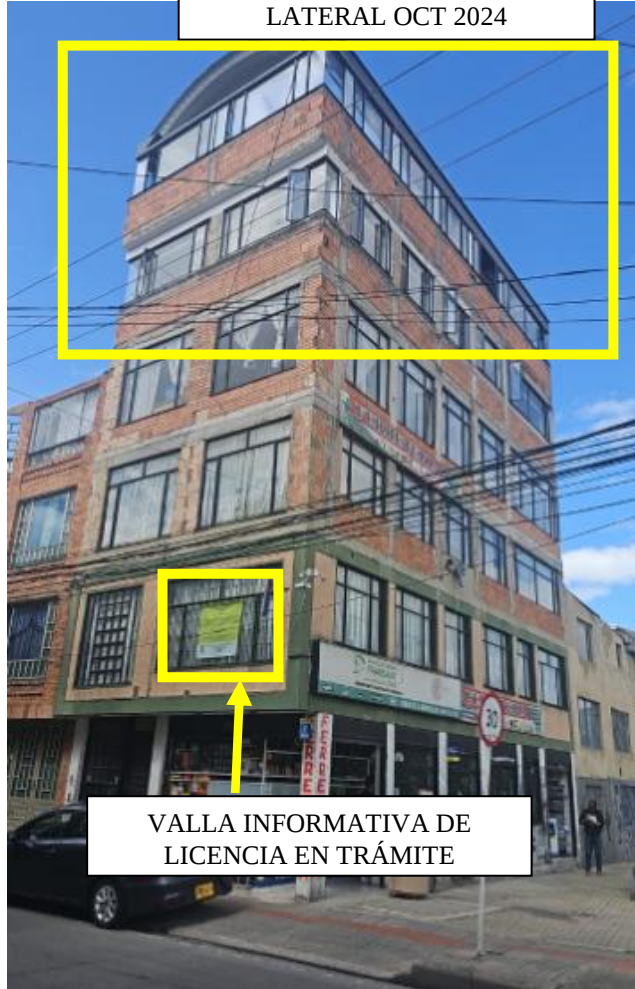
FOTO ACTUAL FACHADA LATERAL OCT 2024
