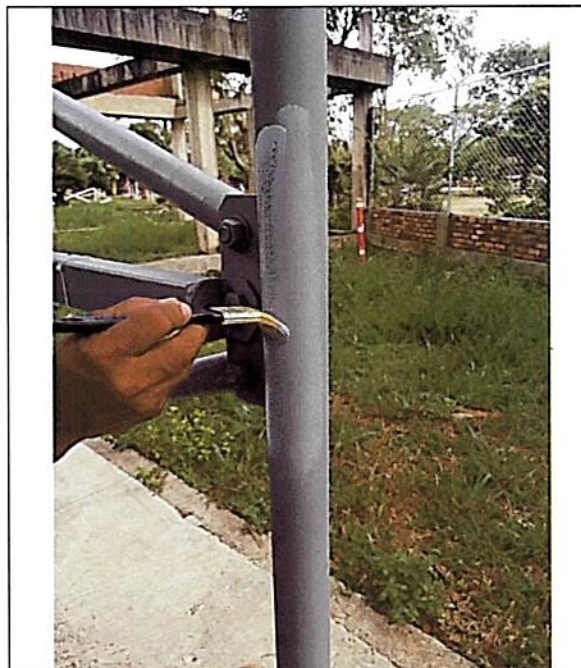
Lijado y pintura estructura torre
