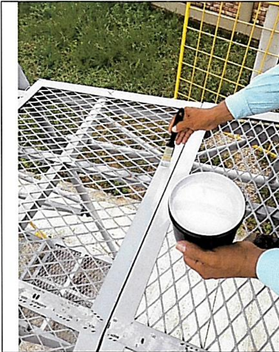
Lijado y pintura estructura torre
