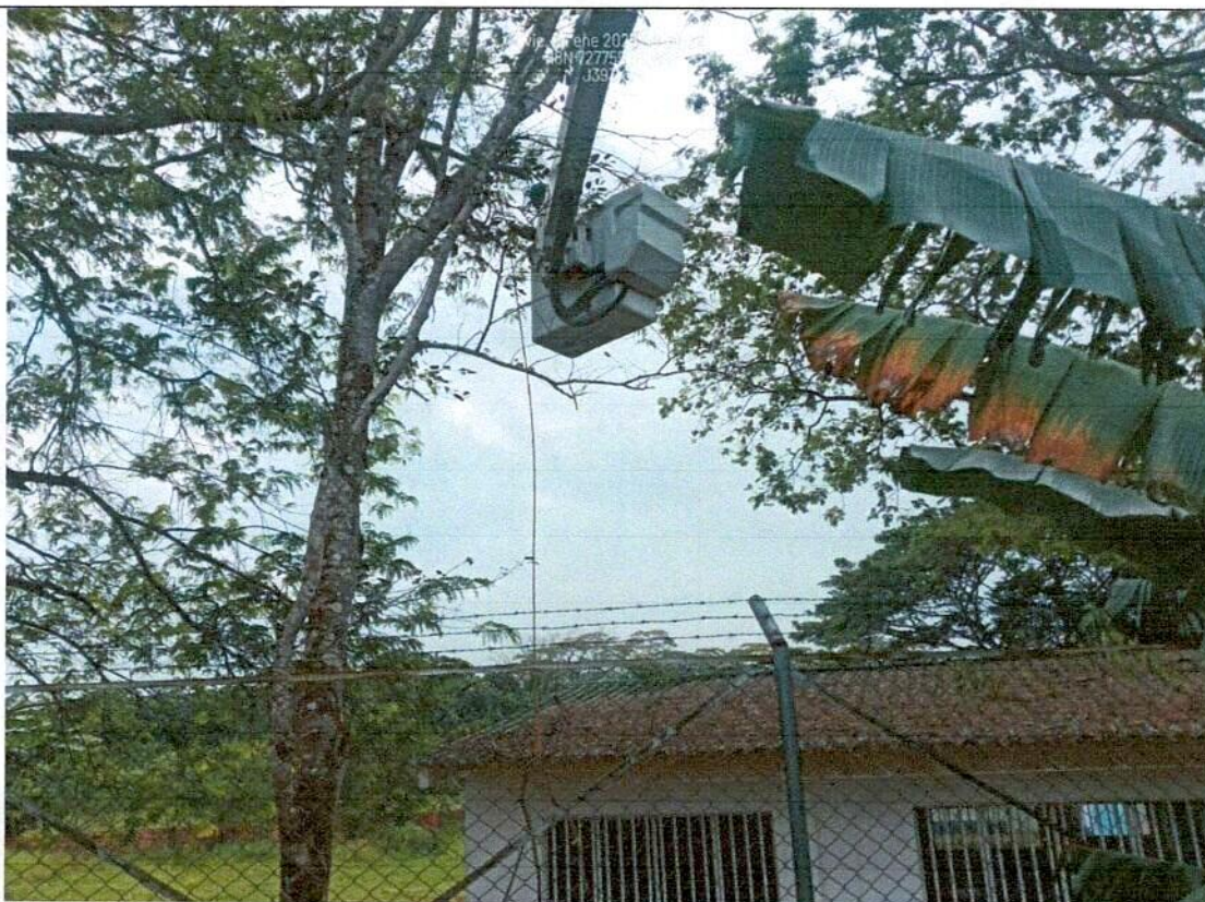
30-12-2024 MANTENIMIENTO ALUMBRADO PÚBLICO VEREDAS EL FICAL, CAIMAN BAJO Y ALTO
