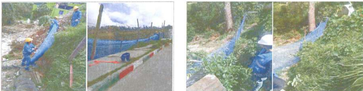
Instalación de lona como cerramiento provisional en los predios que se están interviniendo.
