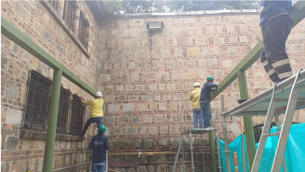
Soldadura vigas longitudinales
