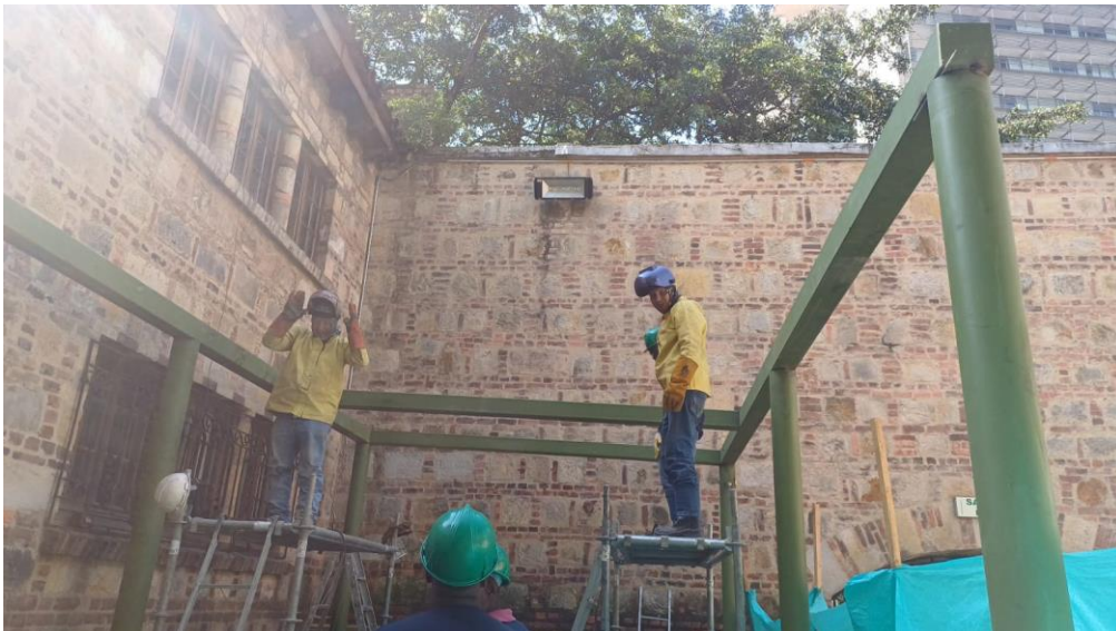
Montaje Vigas Transversales
