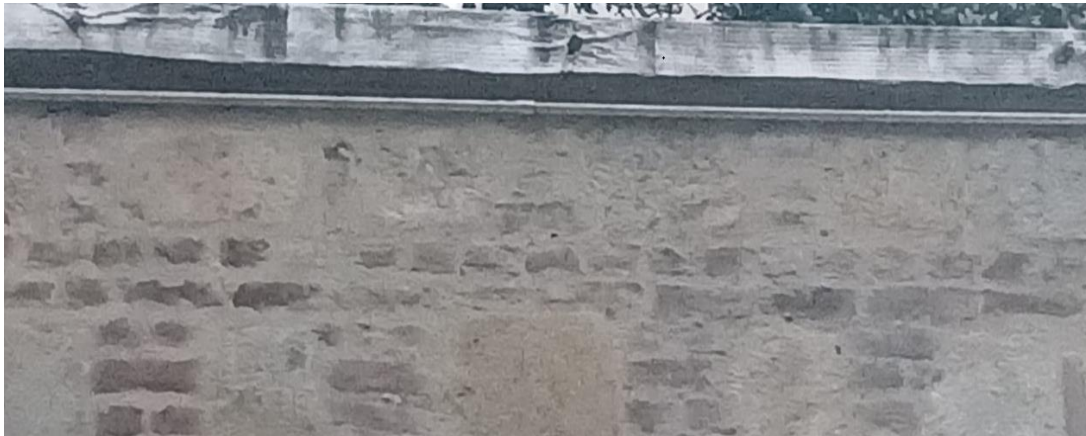
Tubería IMC bajo cornisa
