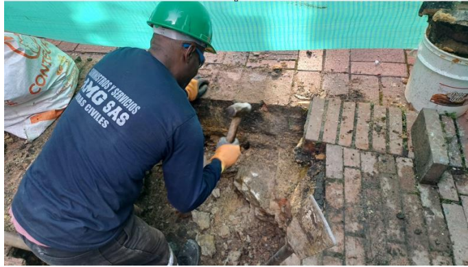
Demolición Contrapiso
