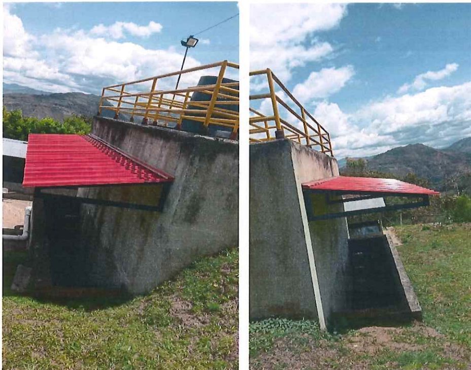
FOTOGRAFIA 6 Y 7: CUBIERTAS CAJAS DE VALVULAS DE TOMA DE MUESTRAS DE LOS LODOS
