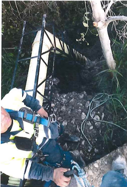
FOTOGRAFIA 17 Y 18: CERCHA METALICA PARA SOPORTE DE TUBERIA DE DESCARGA DEL EFLUENTE DE LA PTAR.
