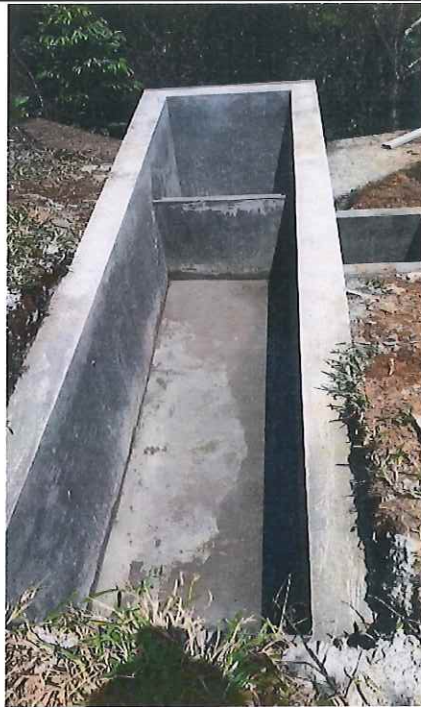
FOTOGRAFIA 19 Y 20: CAJILLA FINAL DE RECIBO DEL EFLUENTE. FACILITA MEDICION DE CAUDALES.
