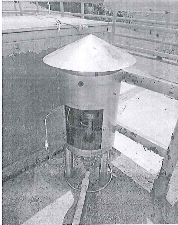
FOTOGRAFIA 14: QUEMADOR DE GASES EN ACERO INOXIDABLE 304.
