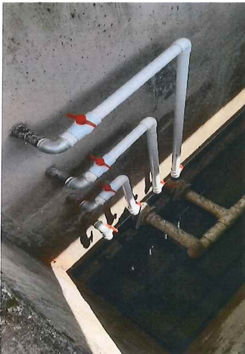
FOTOGRAFIA 10 Y 11: TOMAS DE MUESTRAS DE LODOS CONSTRUIDAS PARA LOS 4 TANQUES.
