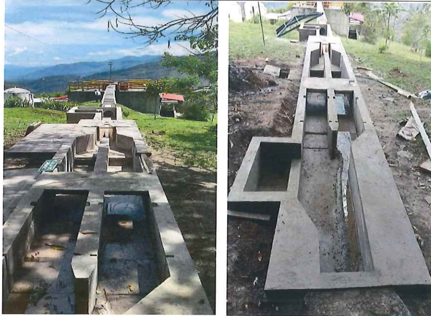
FOTOGRAFIA 12 Y 13: UNIDADES DE PRETRATAMIENTO RESANADAS Y PAÑETADAS EN SU TOTALIDAD
