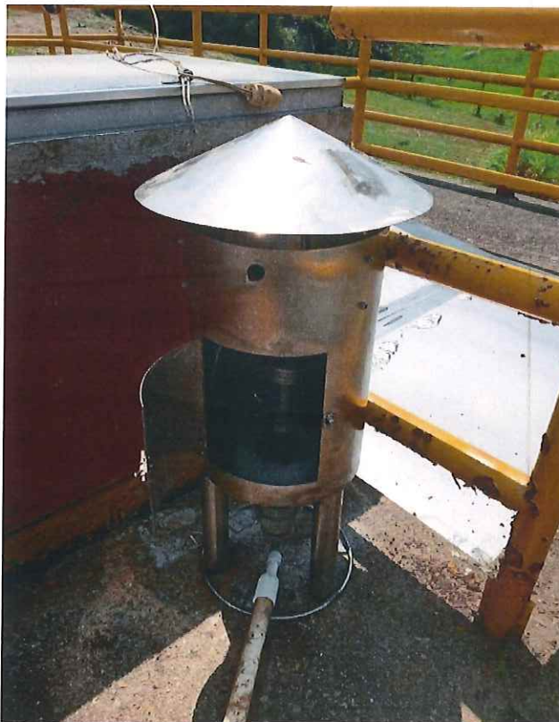
FOTOGRAFIA 14: QUEMADOR DE GASES EN ACERO INOXIDABLE 304.
