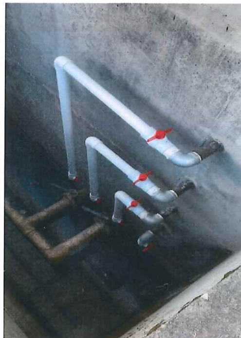
FOTOGRAFIA 10 Y 11: TOMAS DE MUESTRAS DE LODOS CONSTRUIDAS PARA LOS 4 TANQUES.
