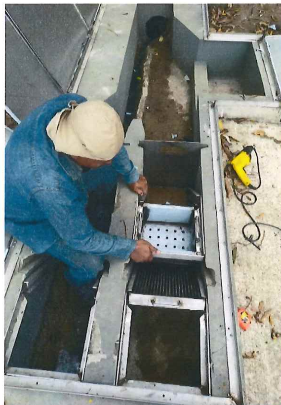
FOTOGRAFIA 1 Y 2: PROCESO DE CONSTRUCCION E INTALACION REJAS DE CRIBADO
