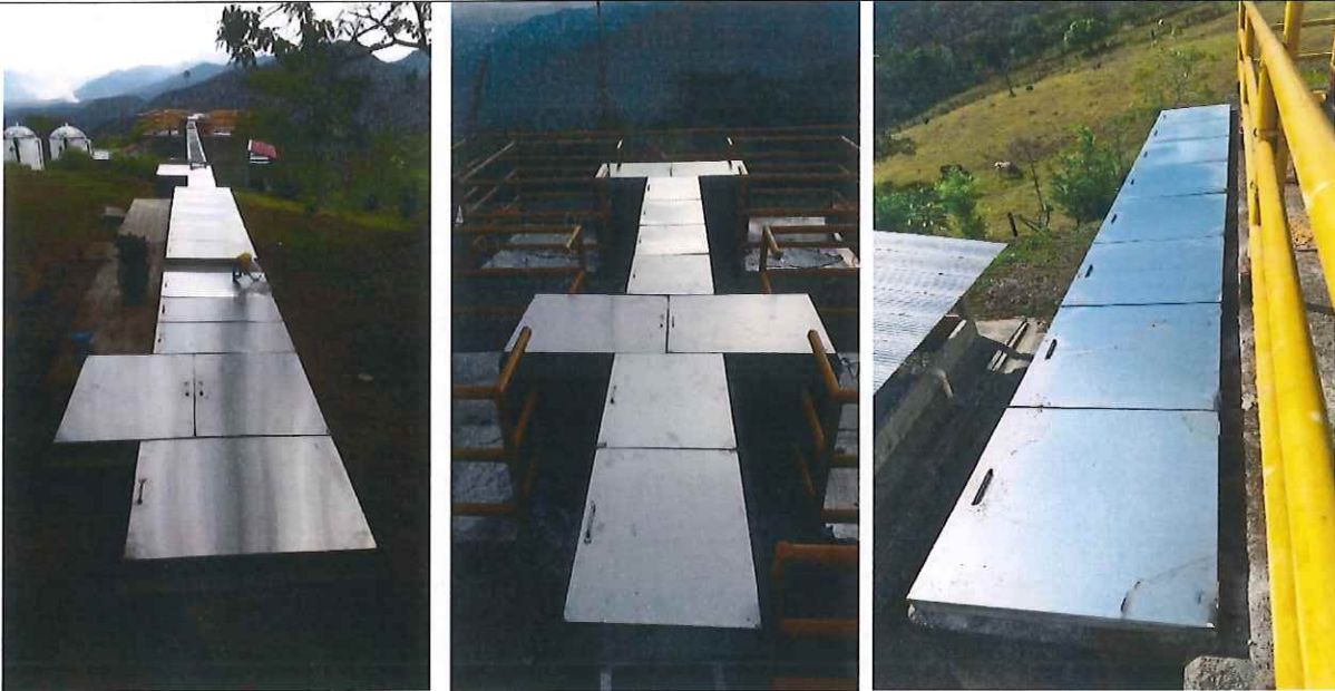
FOTOGRAFIA 3, 4 y 5: TAPAS EN ACERO INOXIDABLE CALIBRE 18 Y ESTRUCTURA PERIMETRA EN ANGULO DE 11/2"X1/8" REFERENCIA 304.
