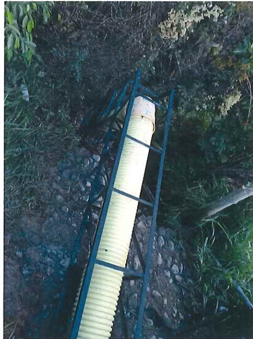
FOTOGRAFIA 21 Y 22: TUBERIA CORRUGADA SELLO HERMETICO DE 315 MILÍMETROS. DESCARGA DEL EFLUENTE DE LA PTAR.
