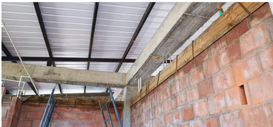
Imagen 2. Fundición viga corona Bloque 1
