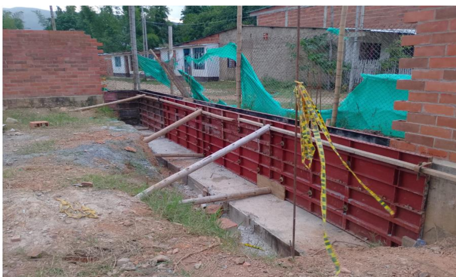
Imagen 12. Fundición Muro de Contención acceso cra 5a
