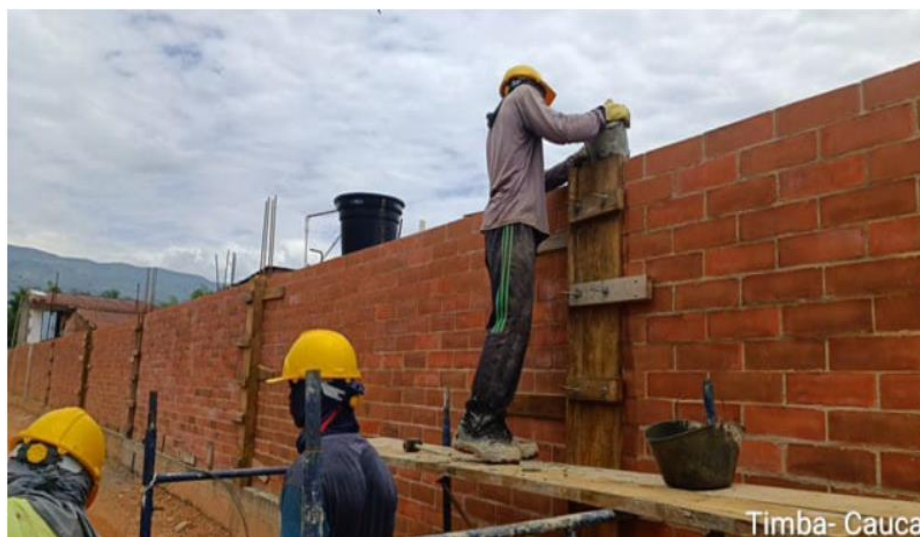
Imagen 11. Fundición Columnetas perimetrales
