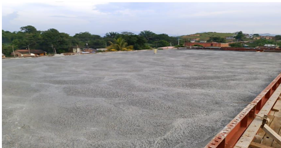
Imagen 3. Fundición de Losas Técnicas Bloque 2
