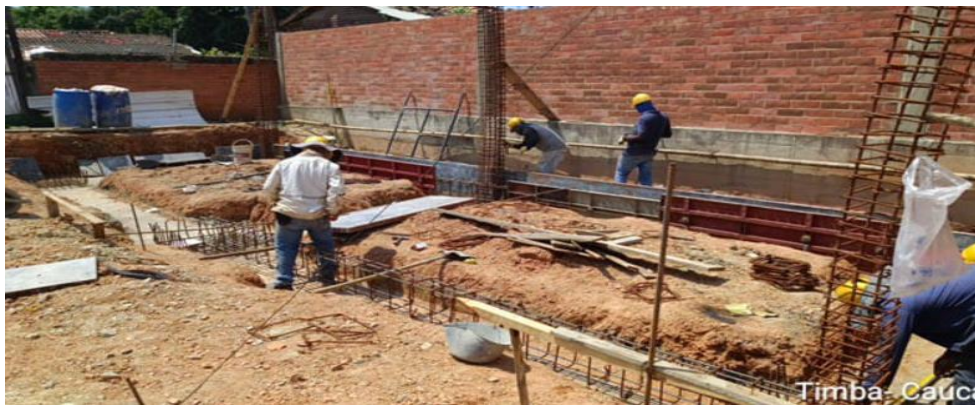
Imagen 9. Excavaciones, solado cimentación de bloque 5
