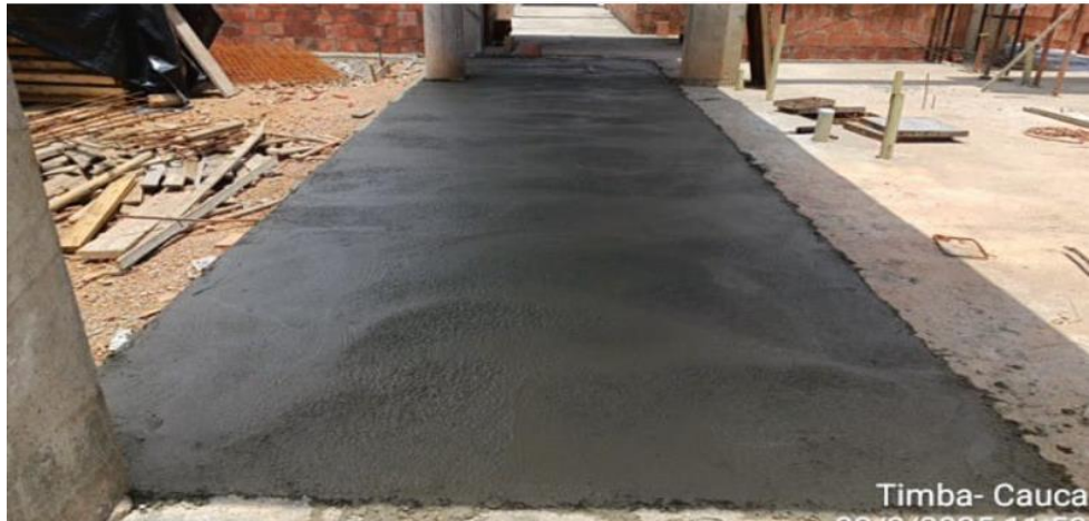
Imagen 8. Fundición Contrapiso Bloque 4
