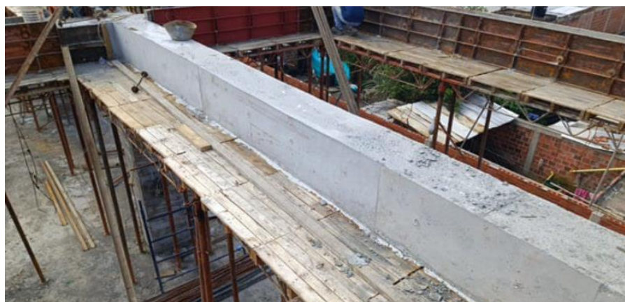
Imagen 4. Fundición de vigas aéreas del segundo piso en Bloque 2
