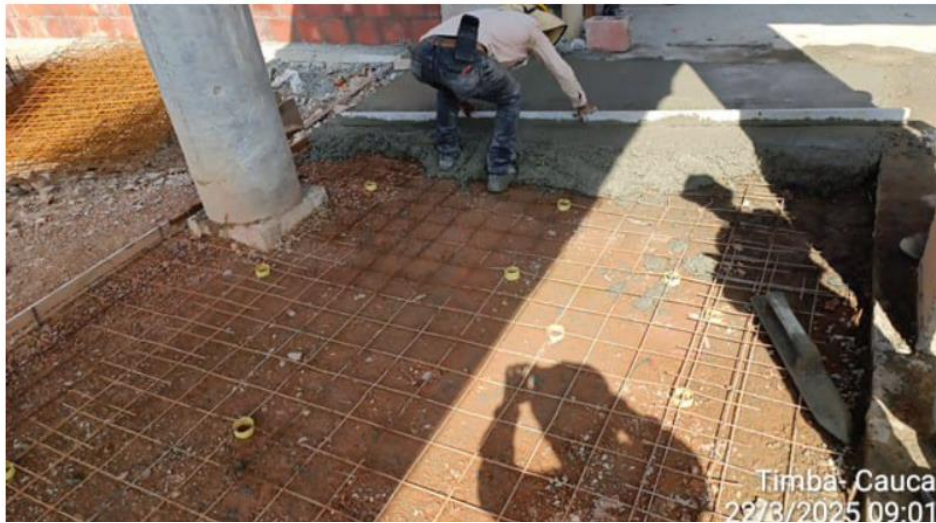
Imagen 5. Fundición de contrapiso Bloque 3
