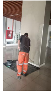
Arreglo Paredes Aguas Bogota
