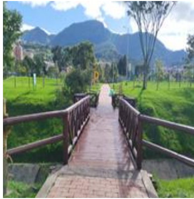
Mantenimiento puentes consorcio Guadalupe
