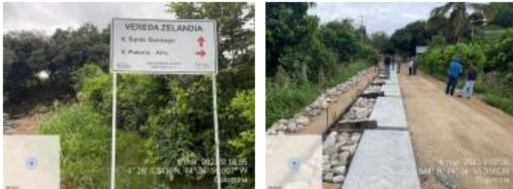
Recorrido de obra 06 de marzo de 2023 – Fuente propia Consorcio IKER 2022
