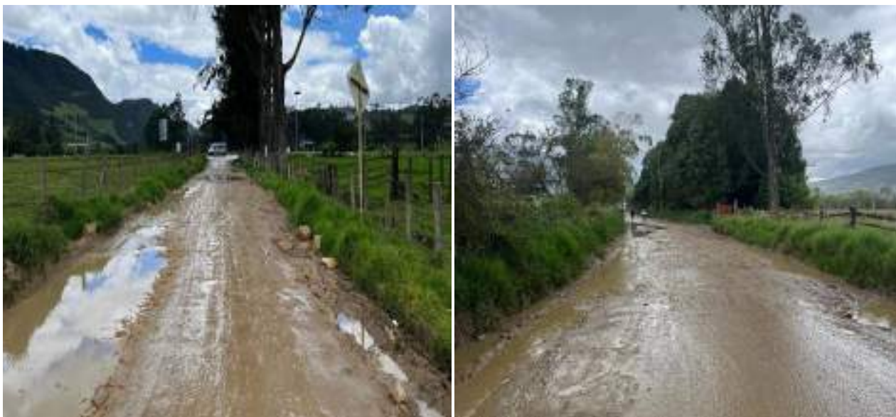
Fotografía 1 -Estado inicial de la obra Municipio La Calera.
