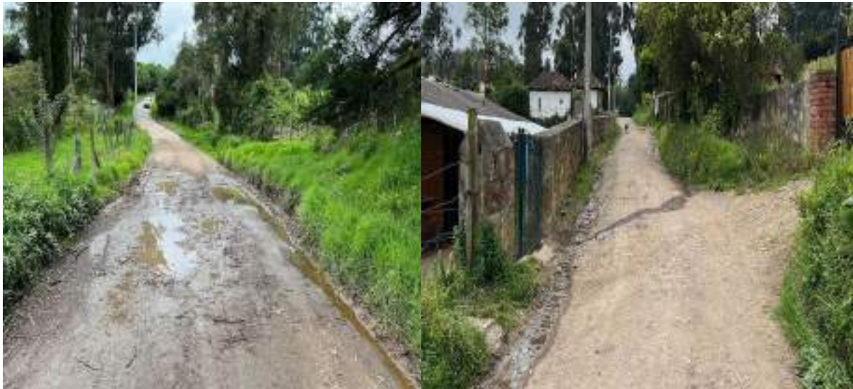
Fotografía 1 -Estado inicial de la obra Municipio Zipaquirá.
