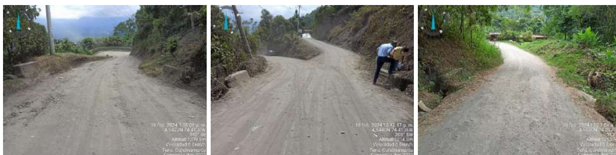
Fotografía 1-Estado inicial de la vía a intervenir con placa huella
