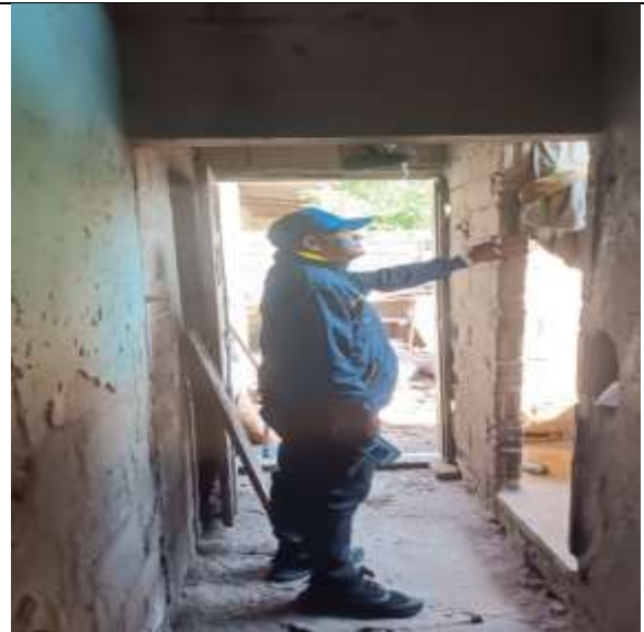
Brindé apoyo en la verificación técnica de emergencia sobre reparación y reconstrucción de edificaciones, materiales necesarios y estado de vivienda ubicada K 13 6A 10 del barrio La Chinita.
