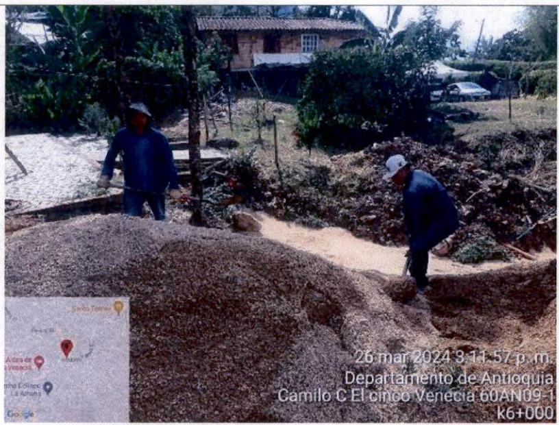
Punto 60AN09-1 El Cinco-Venecia K6+000, construcción de poceta de encole. relleno
