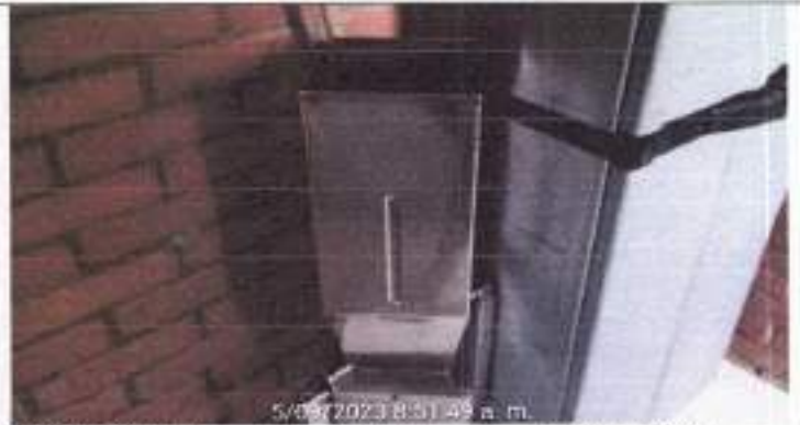
FOTOGRAFÍA No. 10 PREPARACIÓN, ENSAMBLE Y DISTRIBUCIÓN
