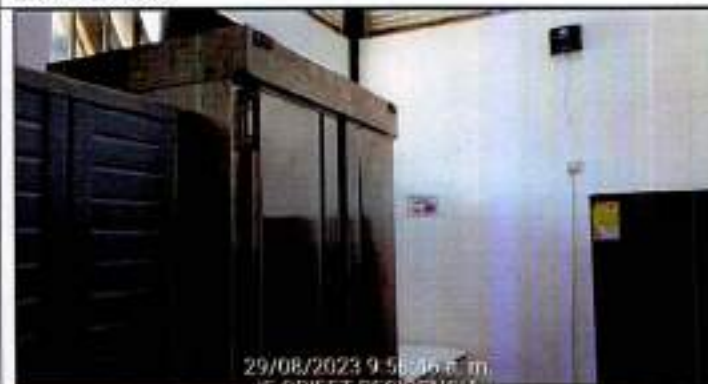
FOTOGRAFÍA No. 10 PREPARACIÓN, ENSAMBLE Y DISTRIBUCIÓN
