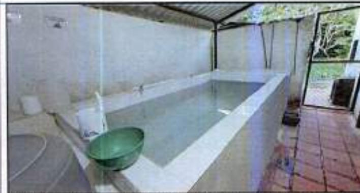
FOTOGRAFÍA No. 4 ABASTESIMIENTO DE AGUA Y CONTROL DE PLAGAS
