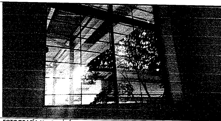
FOTOGRAFÍA No. 3 ÁREA DE PREPARACIÓN- VENTANAS
