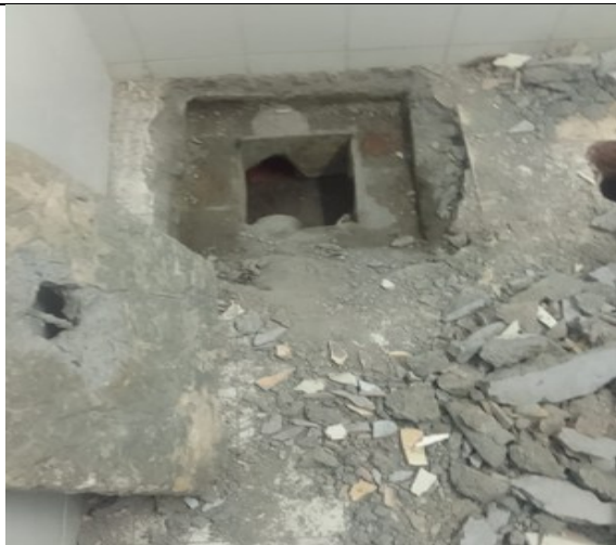
Foto N°1 DEMOLICION Y DESMONTE
