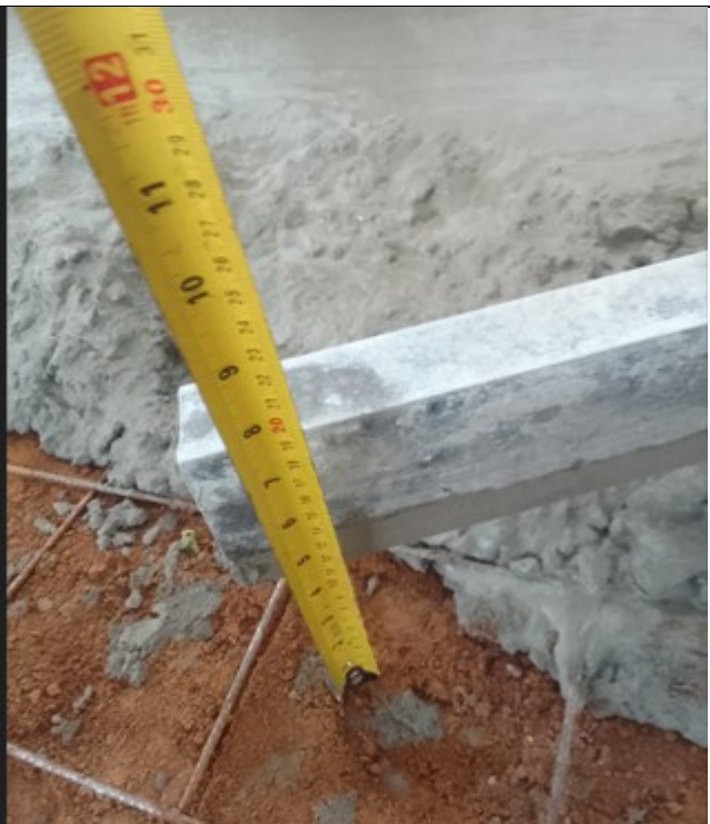
Foto N°6 ESPESOR DE LOSA INSTALADA
