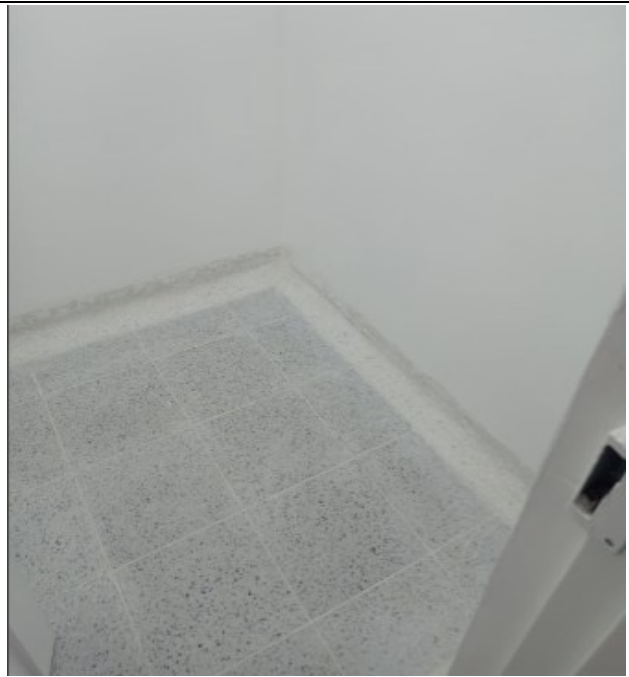
Foto N°4 LOSA Y MEDIACAÑA
