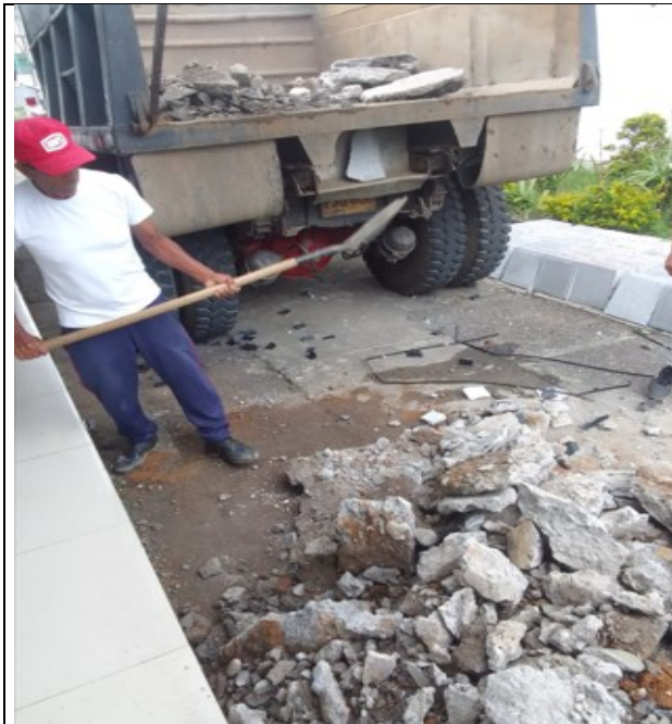
Foto N°7 RETIRO DE MATERIAL
