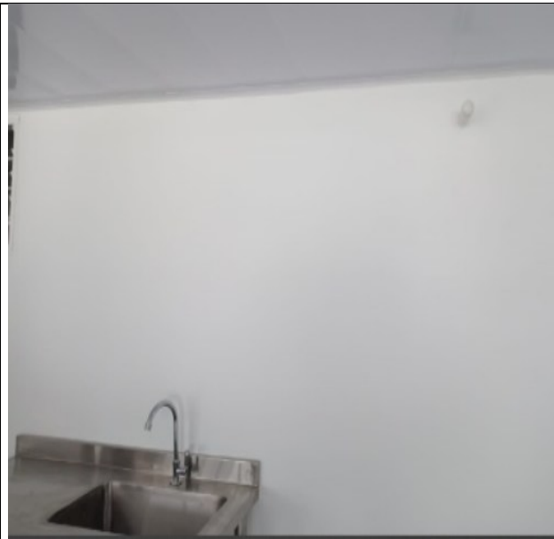
Foto N°10 REPOSICIÓN DE MURO
