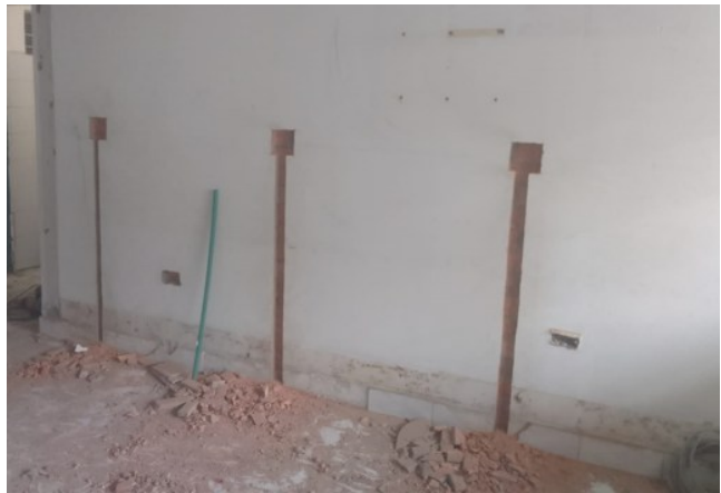
Foto N°2 DESMONTE REDES ELECTRICAS
