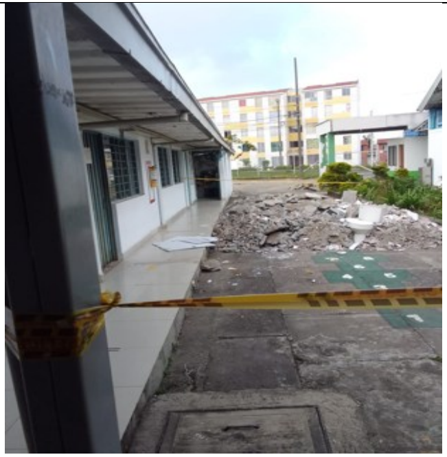
Foto N°8 RETIRO DE MATERIAL
