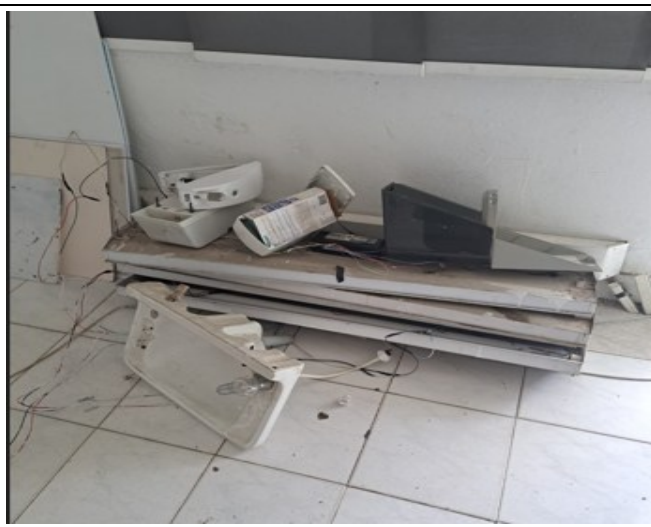
Foto N°10 RETIRO DE AIRE ACONDICIONADO
