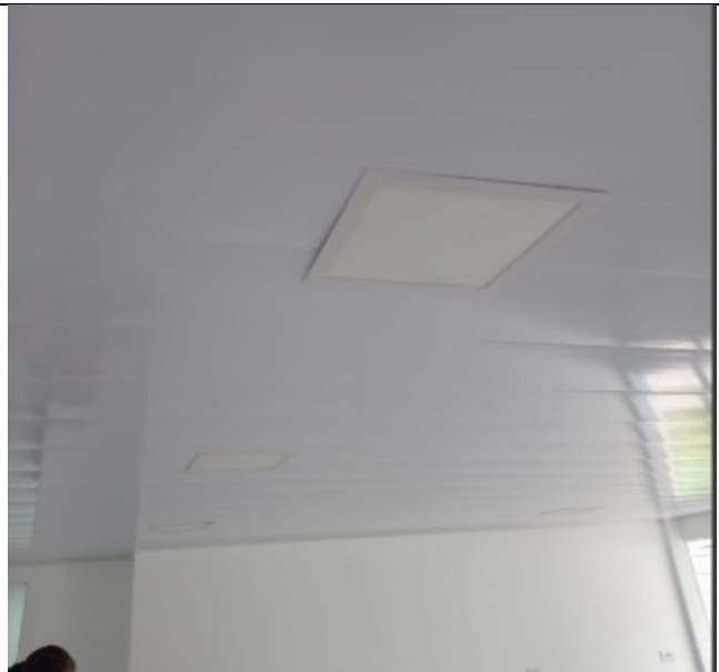
Foto N°10 LUCES LED INSTALADAS
