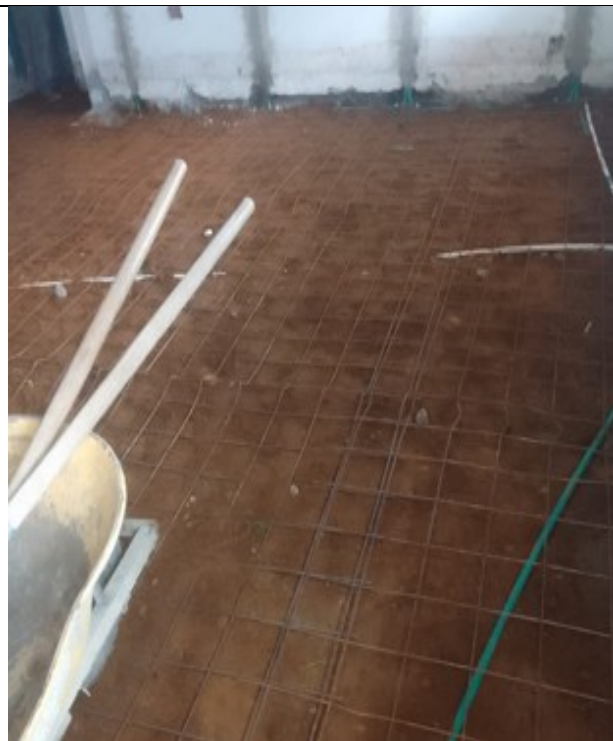
Foto N°5 MALLA PARA LOSA
