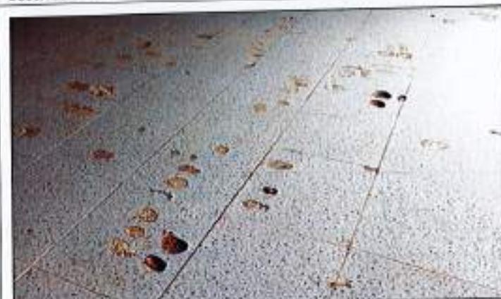
FOTOGRAFÍA No. 3 INSTALACIONES FÍSICAS E INFRAESTRUCTURA
