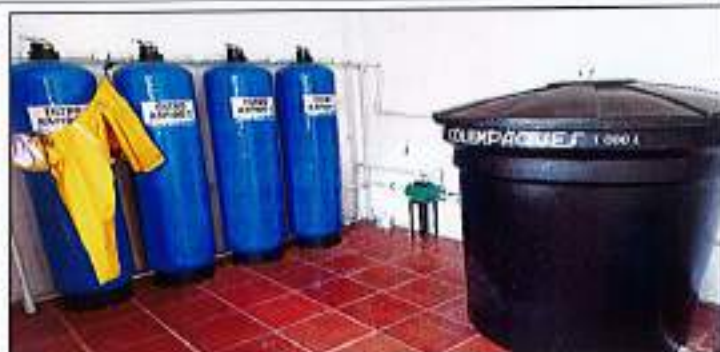
FOTOGRAFÍA No. 5 ABASTECIMIENTO DE AGUA
