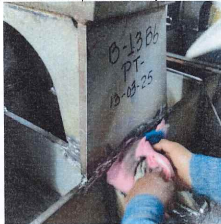
Imagen No. 18: Limpieza de soldaduras viga cajón de babor.
