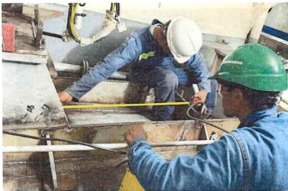
Imagen No. 17: Conformación de viga cajón para mesas de soporte 12, 13 y 14 de babor.
