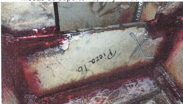
Imagen No. 19: Aplicación de tinta penetrante a soldaduras viga cajón de babor.
