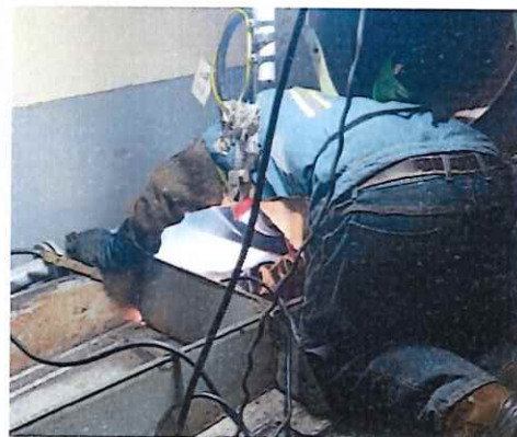
Imagen No. 14: Conformación de viga cajón para mesas de soporte 12, 13 y 14 de estribor.
