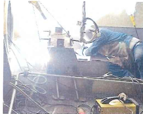
Imagen No. 10: Soldadura mesa de soporte No. 14 babor.
