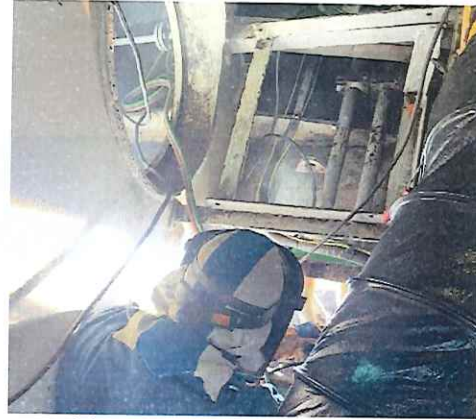
Imagen No. 20: Soldadura de refuerzos para viga cajón sobre estructura de mesa de soporte 15 estribor.
