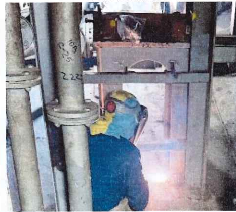
Imagen No. 8: Soldadura mesa de soporte No. 11 de babor.
