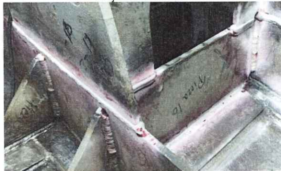
Imagen No. 20: Aplicación de tinta reveladora a soldaduras viga cajón de babor.
