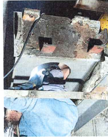
Imagen No. 6: Soldadura mesa de soporte No. 10 de estribor.
