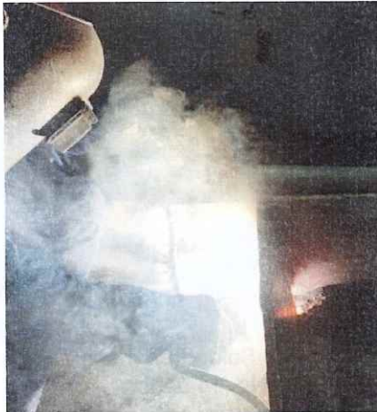
Imagen No. 15: Conformación de viga cajón para mesas de soporte 12, 13 y 14 de babor.
