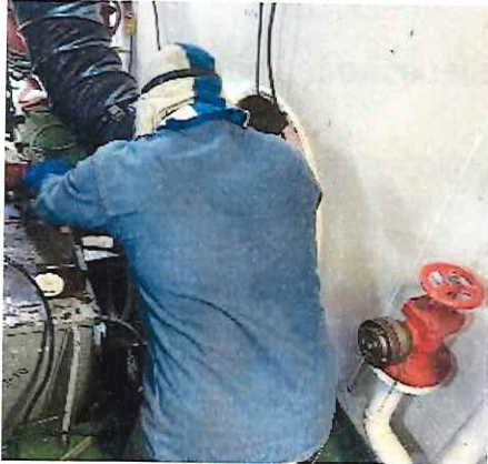
Imagen No. 19: Soldadura de refuerzos para viga cajón sobre estructura de mesa de soporte 15 babor.
