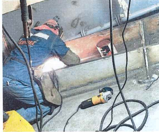
Imagen No. 16: Conformación de viga cajón para mesas de soporte 12, 13 y 14 de estribor.
