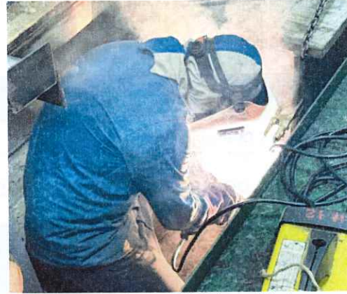
Imagen No. 4: Aplicación de soldadura para fijación de mesas de soporte nuevas.
