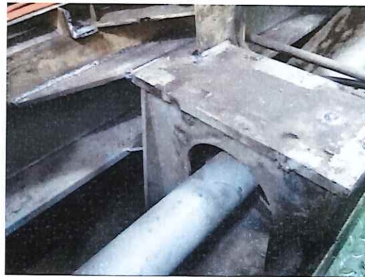
Imagen No. 12: Soldadura de refuerzo para viga cajón entre mesa de soporte No. 6 y mamparo 50 de estribor.
