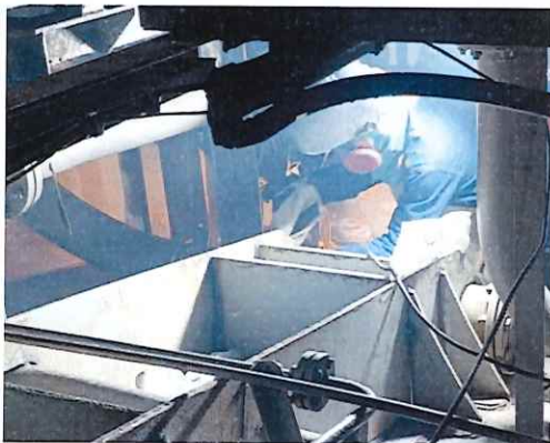
Imagen No. 13: Conformación de viga cajón para mesas de soporte 12, 13 y 14 de babor.
