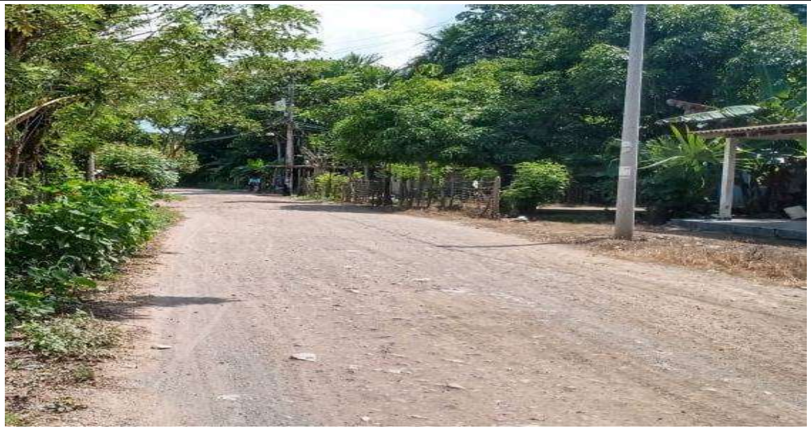
Vía en afirmado regular PR 0+000
