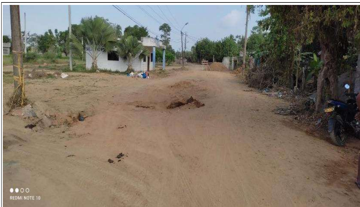
Vía en afirmado regular PR 0+000
