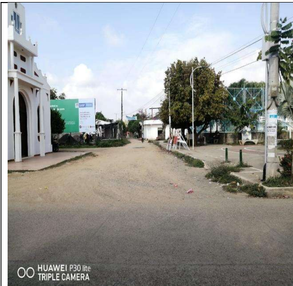
Vía en afirmado regular PR 0+000
