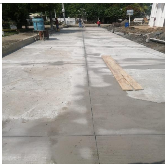
Concreto hidráulico MR38 PR 0+000 – PR 0+040
