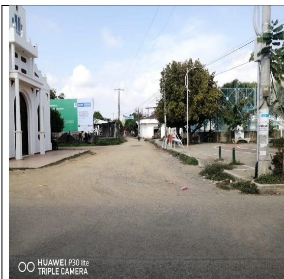
Vía en afirmado regular PR 0+000
