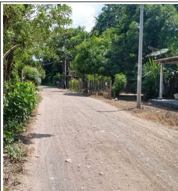
Vía en afirmado regular PR 0+000
