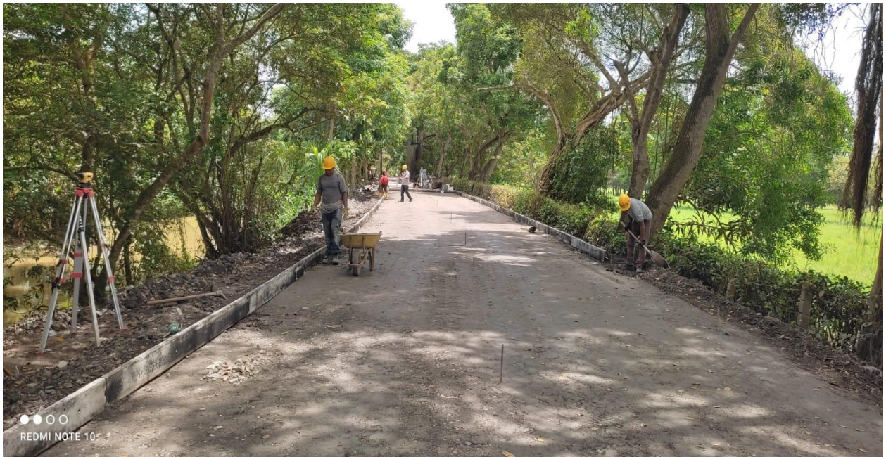
Instalación de rieles
