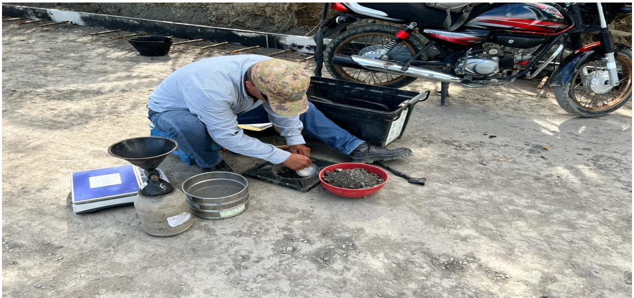
Toma de densidades en Sub base
