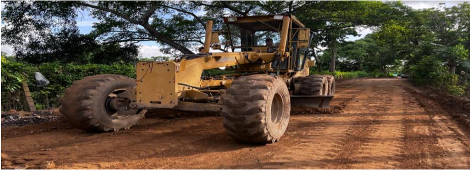
Vía San Antonio - Cedro, El contratista realiza cero en afirmado del (K2+580 al K2+090)
