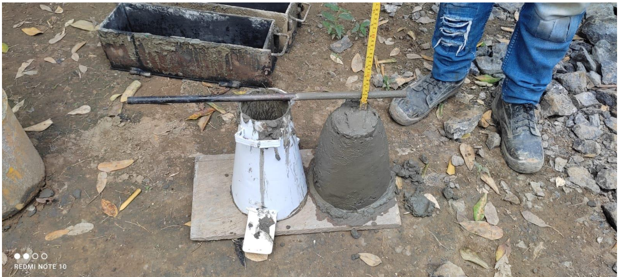
Toma de Slump para verificar el asentamiento del concreto
