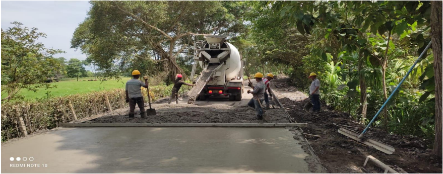
Vía San Antonio - Los cedros, El contratista instala pavimento del (K2+885 al K2+825)
