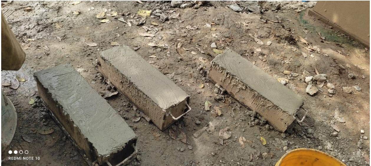
Toma de viguetas para efecto de calidad del concreto
