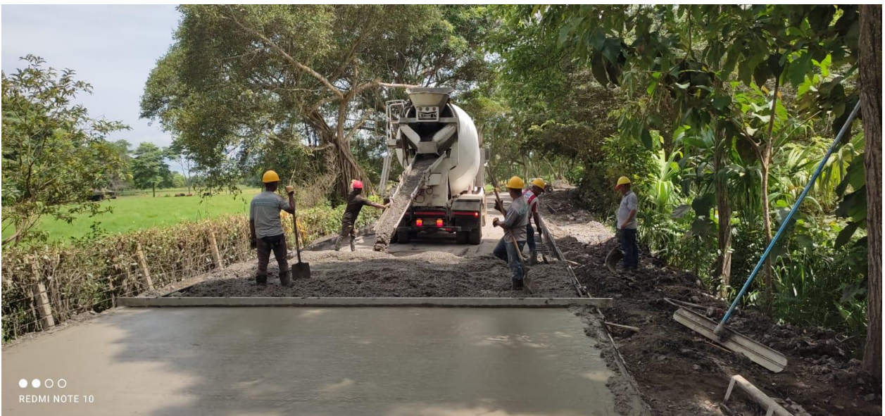
Instalación de concreto
