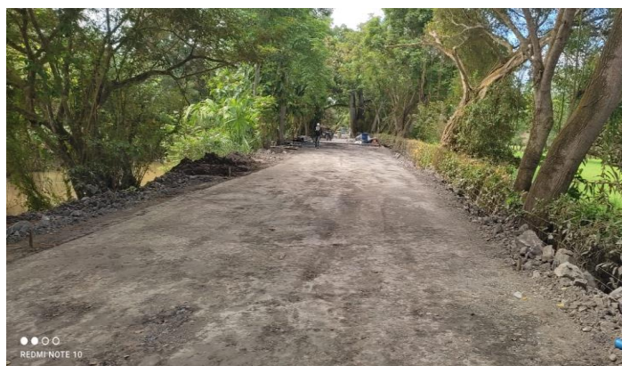
San Antonio – Cedro , vía con sub base, K2+680
