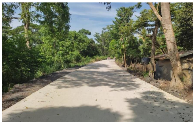
San Antonio – Cedro Instalación de rieles para fundida de concreto K2+770.
