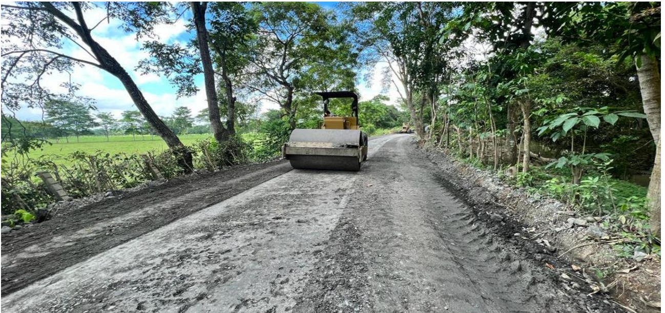
Compactación de sub Base
