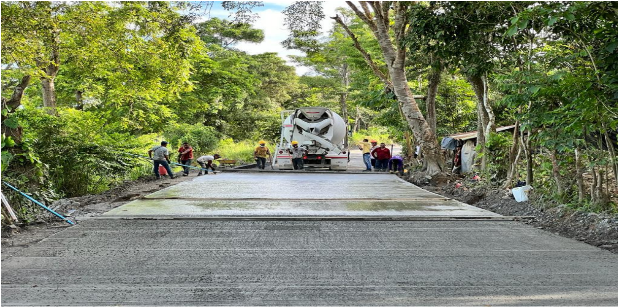
Instalación de concreto
