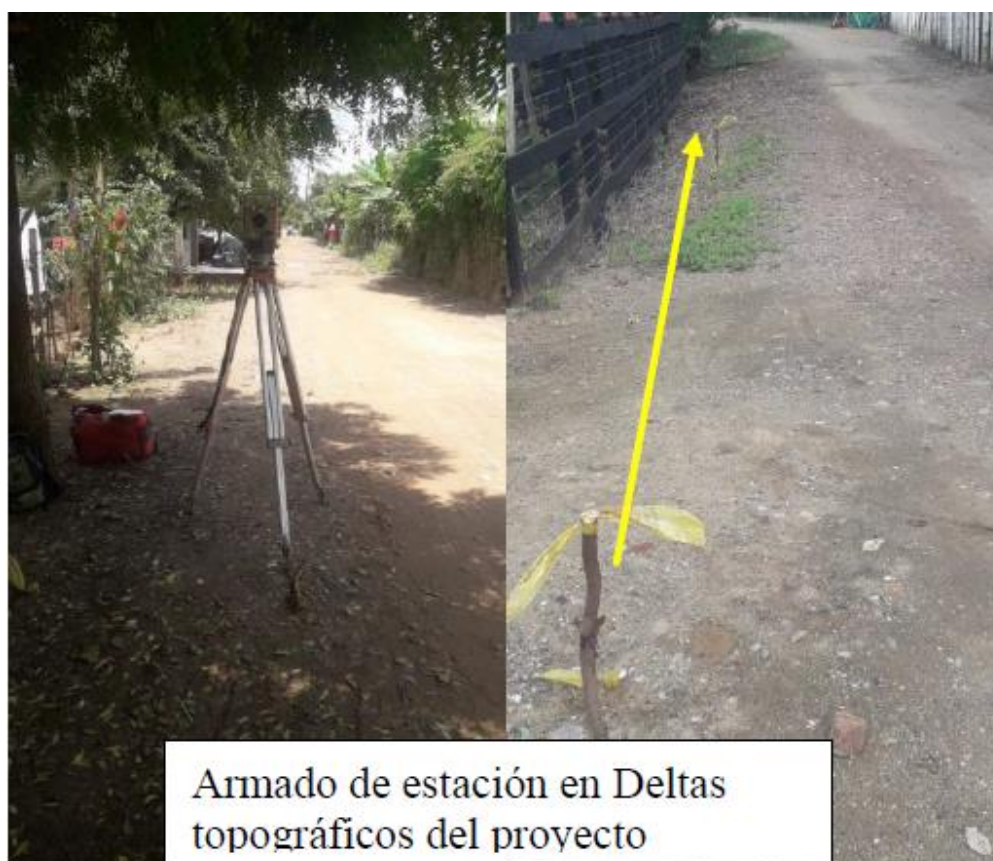
Foto 3. Levantamiento topográfico Inicial Chuchurubí.
