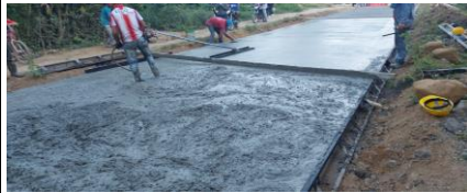
Vía San Antonio- El cepillo Instalación de Concreto para Pavimento K1+380 A K1+450
