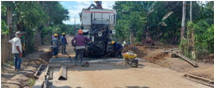
Vía San Antonio- El cepillo Instalación de Concreto para pavimento entre ka 1+250 a k1+300
