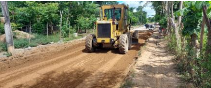
Vía San Antonio- El cepillo Instalación de Sub-base entre k1+200 a k1+300
