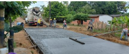
Vía San Antonio- El cepillo Instalación de Concreto para pavimento entre ka 1+130 a k1+250
