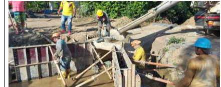
Vía San Antonio- El cepillo instalación de Concreto para Aletas de Bocuvert 1X1 k2+700
