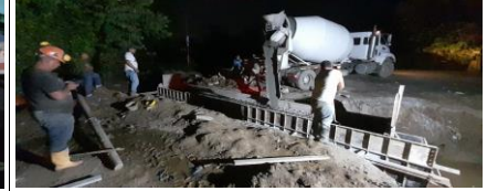
Vía San Antonio- El cepillo instalación de Concreto para Losa Superior Bocuvert 1X1 k2+700
