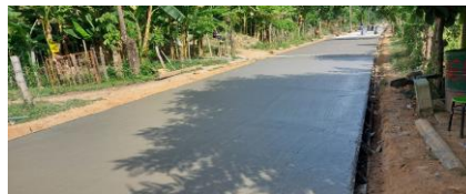
Vía San Antonio- El cepillo Instalación de Concreto para pavimento entre ka 1+130 a k1+250
