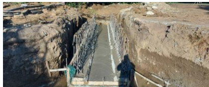
Vía San Antonio- El cepillo Instalación de Concreto para losa Inferior y acero de muros del Box de 1X1 k2+700
