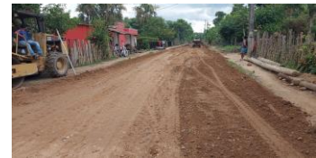
Vía San Antonio- El cepillo Conformación e Instalación de Material de Sub-base k1+350 a k1+450
