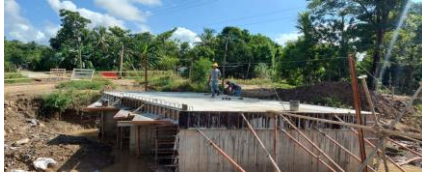
Vía San Antonio- El cepillo Instalación de Concreto para Pavimento k2+360 a k2+460
