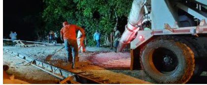
Vía San Antonio- El cepillo Instalación de Concreto para pavimento entre ka 1+300 a k1+380
