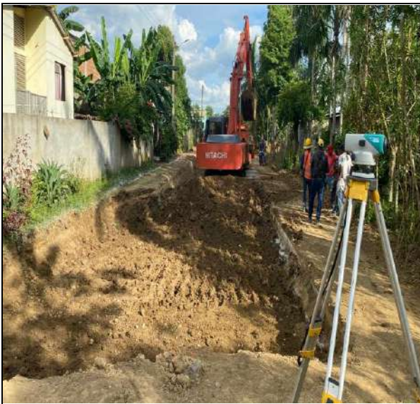
FOTO No. 13 Excavación mecánica entre absc K0+560 a la K0+640
