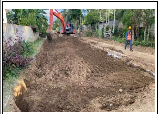
FOTO No. 18 Excavación mecánica entre absc K0+560 a la K0+640
