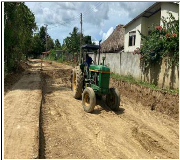
FOTO No. 7 Compactación entre absc K0+380 – K0+640
