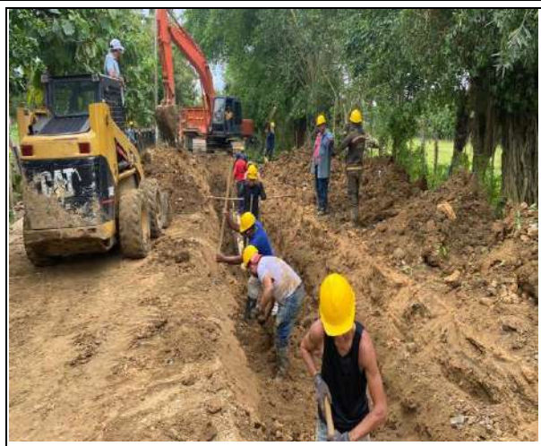
FOTO No. 23 Profundización de tubería de alcantarillado entre absc K0+640 a la K0+000
