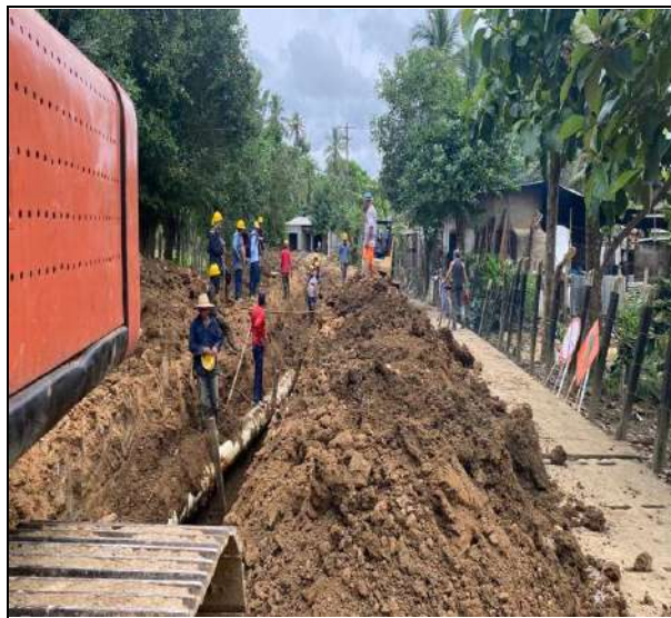
FOTO No. 21 Profundización de tubería de alcantarillado entre absc K0+640 a la K0+000
