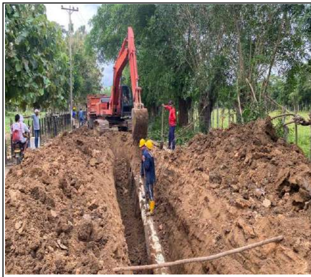
FOTO No. 22 Profundización de tubería de alcantarillado entre absc K0+640 a la K0+000
