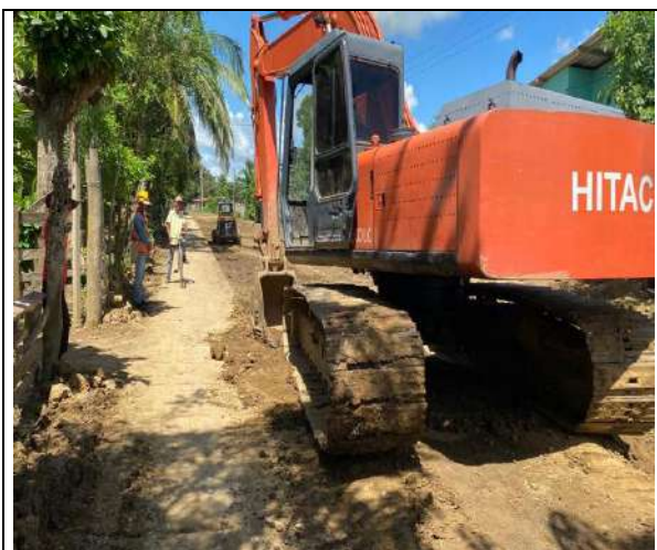
FOTO No. 13 Excavación mecánica entre absc K0+560 a la K0+640
