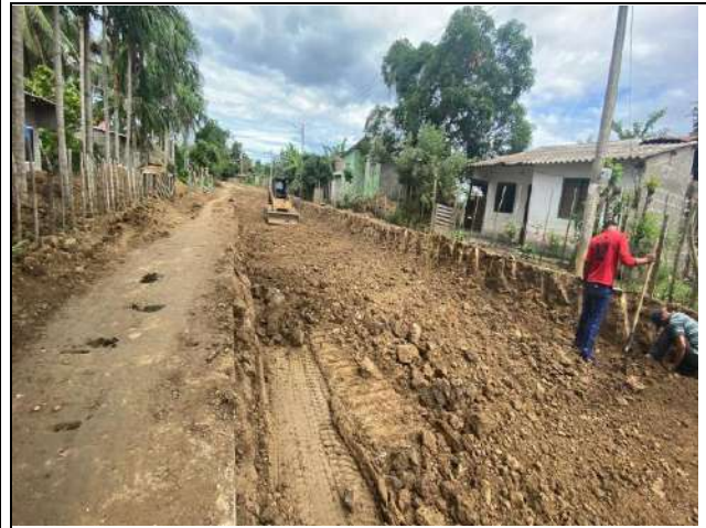
FOTO No. 2 Excavación mecánica entre absc K0+380 a la K0+480
