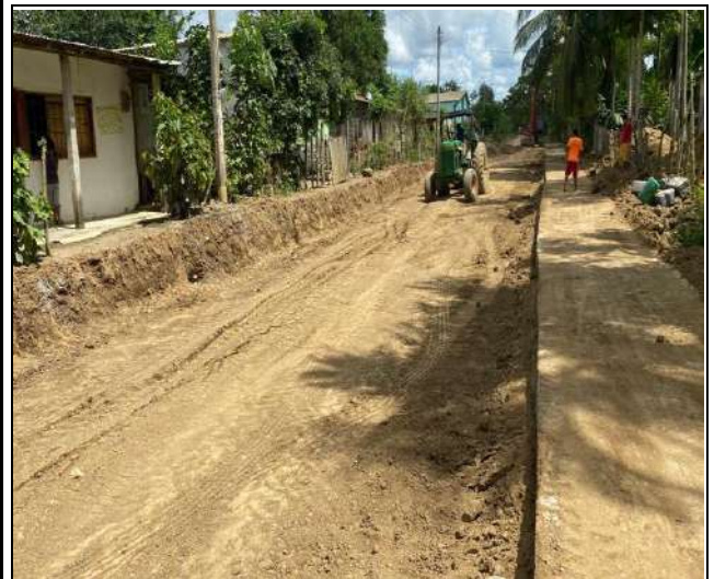
FOTO No. 6 Compactación entre absc K0+380 – K0+640
