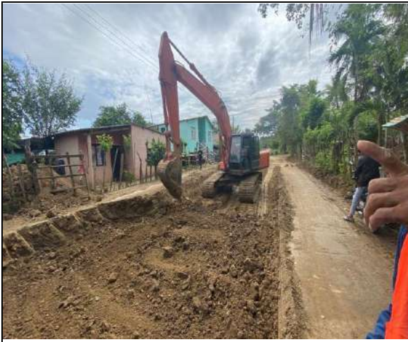
FOTO No. 1 Excavación mecánica entre absc K0+380 a la K0+480
