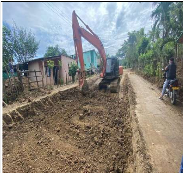
FOTO No. 3 Excavación mecánica entre absc K0+380 a la K0+480
