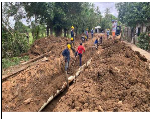
FOTO No. 24 Profundización de tubería de alcantarillado entre absc K0+640 a la K0+000
