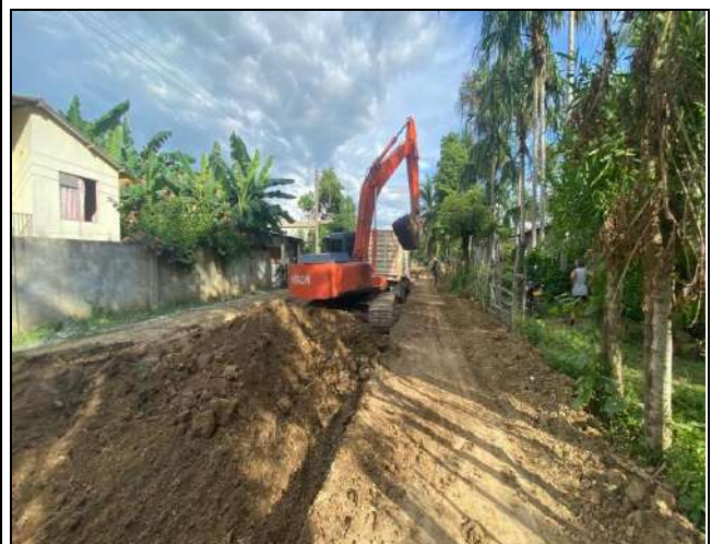
FOTO No. 14 Excavación mecánica entre absc K0+560 a la K0+640
