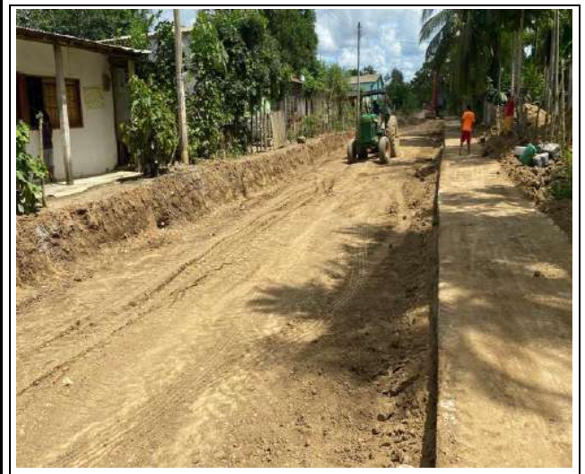
FOTO No. 8 Compactación entre absc K0+380 – K0+640
