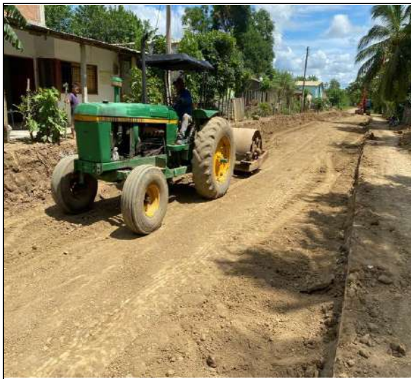
FOTO No. 5 Compactación entre absc K0+380 – K0+640
