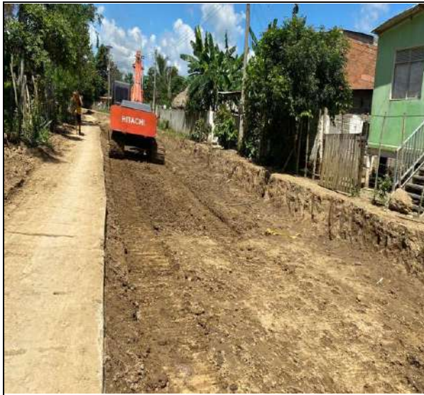
FOTO No. 17 Excavación mecánica entre absc K0+560 a la K0+640
