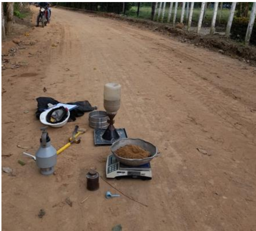
Foto 5. Densidades en campo afirmado PR 1+420 Chuchurubí.
