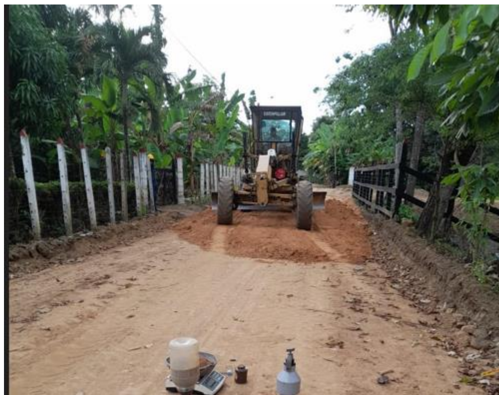
Foto 8. Instalación de subbase del PR1+450 al PR 1+330 Chuchurubí.
