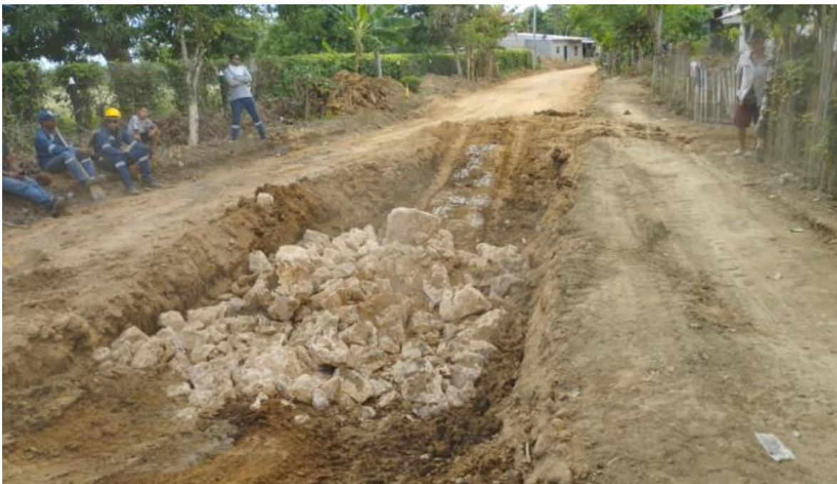
Foto 1. Corrección de fallo en la subrasante en el PR 1+300 Chuchurubí.
