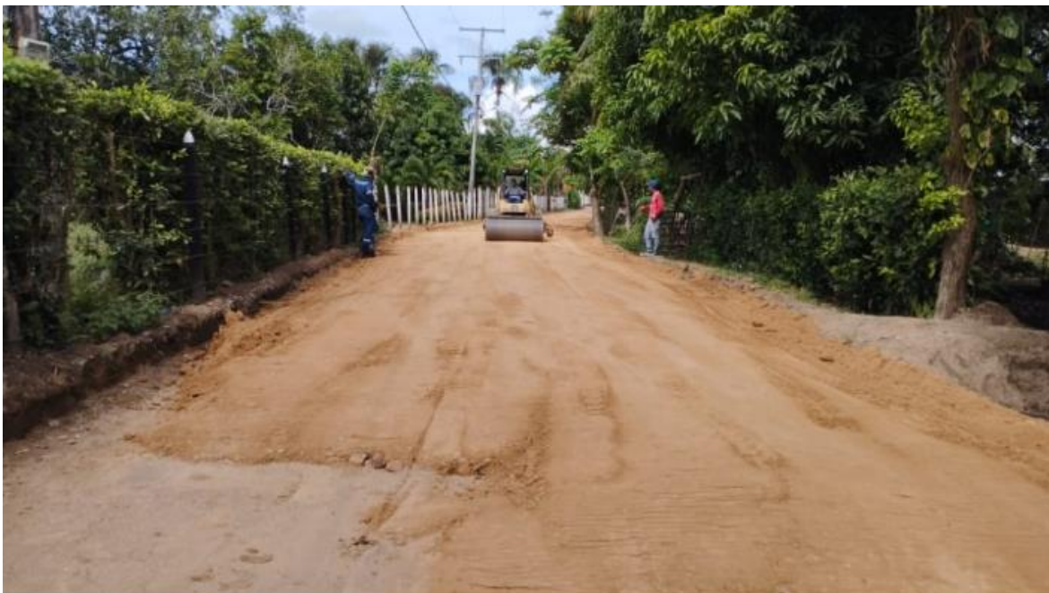
Foto 9. Instalación de subbase del PR1+450 al PR 1+330 Chuchurubí.
