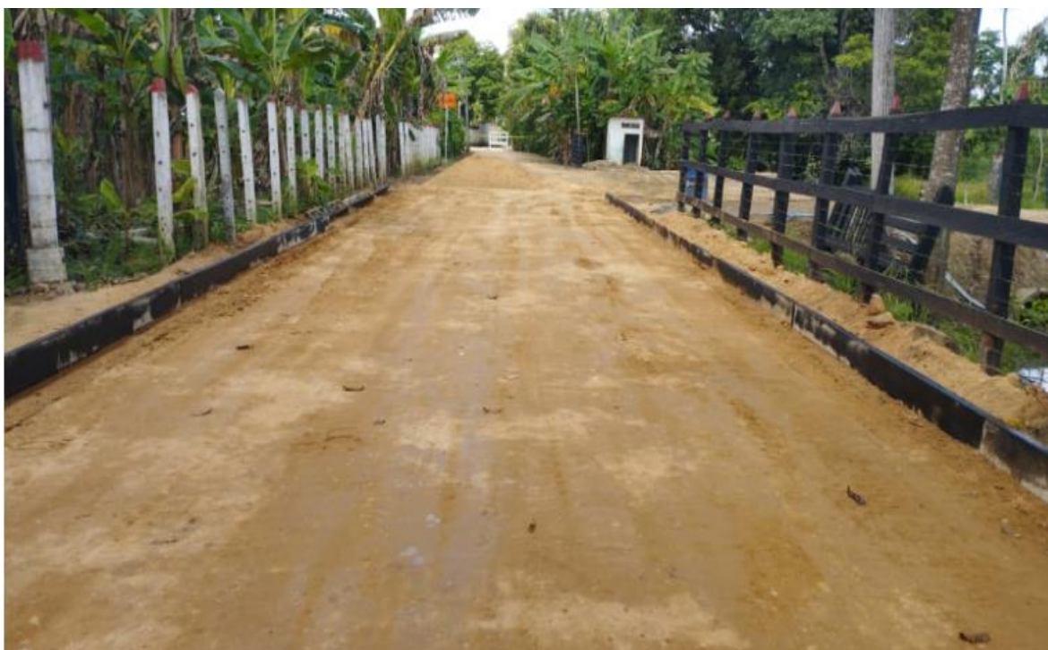
Foto 10. Instalación de rieles del PR1+450 al PR 1+390 Chuchurubí.
