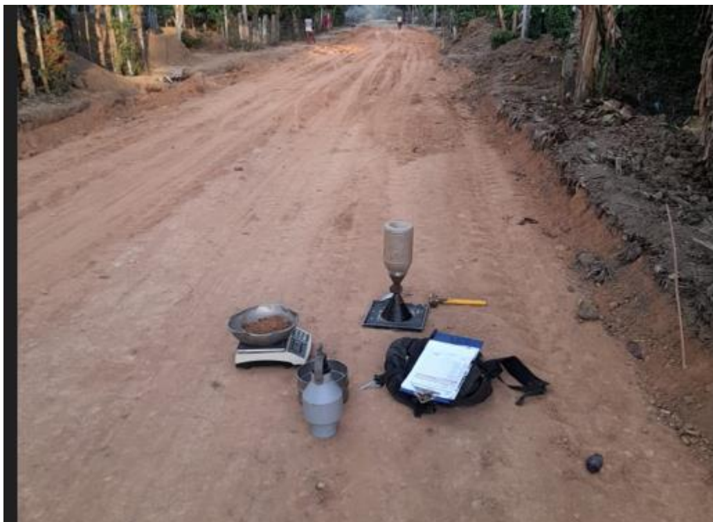
Foto 7. Densidades en campo Afirmado PR 1+240 Chuchurubí.
