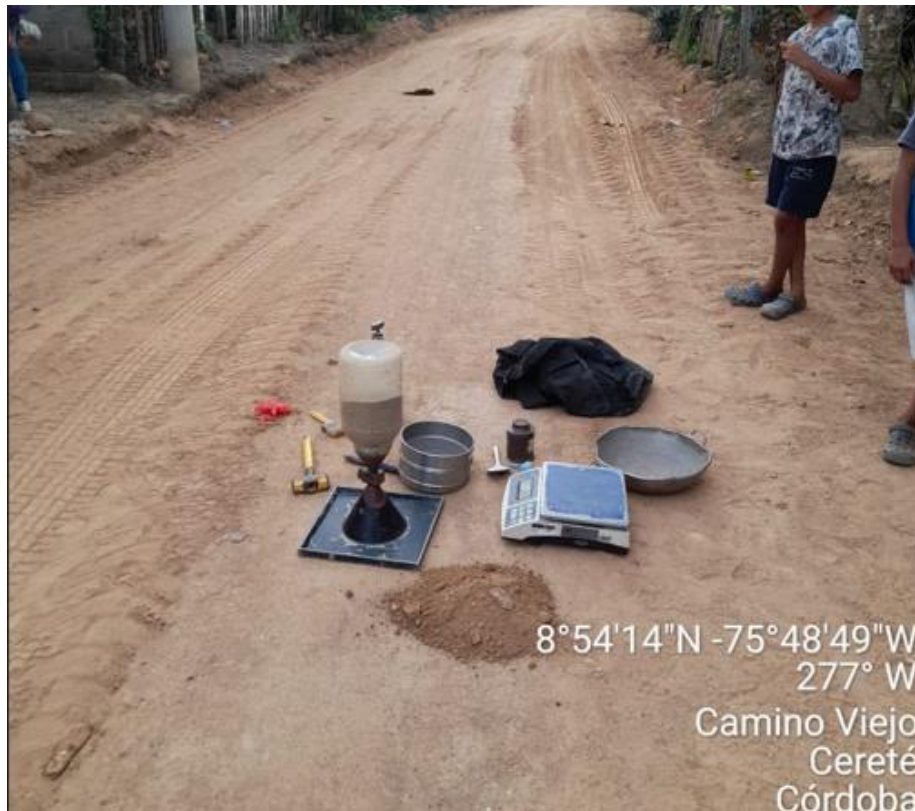
Foto 6. Densidades en campo afirmado PR 1+330 Chuchurubí.
