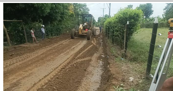
Foto 2. Instalación de afirmado sector chuchurubí PR 1+450 al Pr1+300
