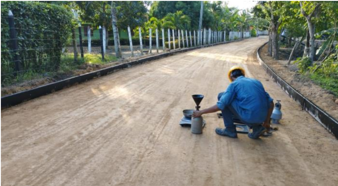
Foto 11. Densidades en campo Subbase PR 1+400 Chuchurubí.
