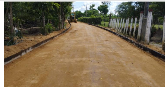
Foto 4. Instalación de subbase sector chuchurubí PR 1+450 al PR 1+390
