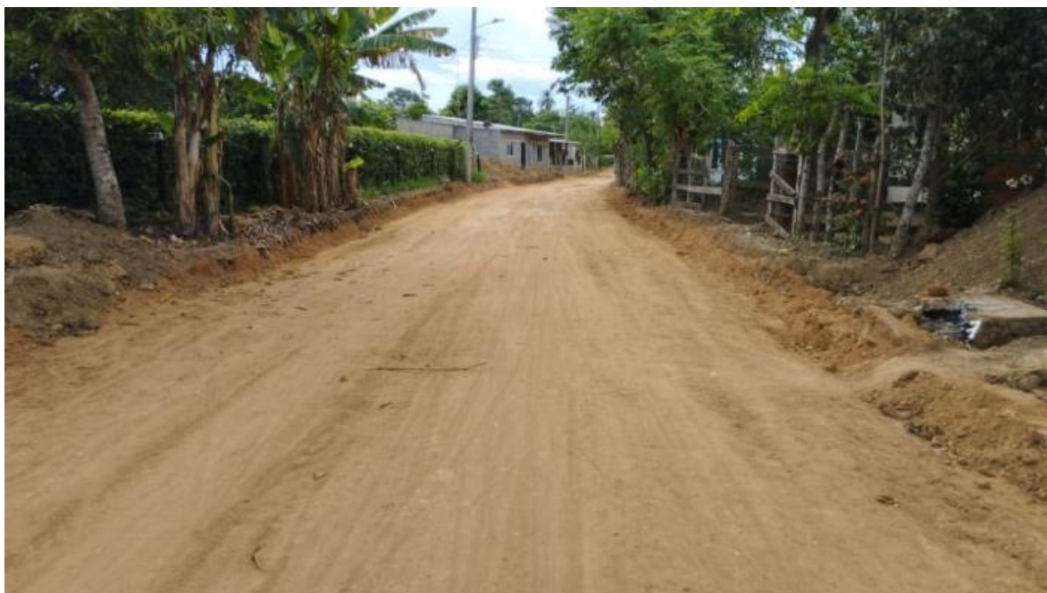
Foto 4. Instalación de afirmado del PR1+450 al PR1+300 Chuchurubí.
