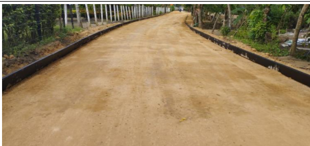
Foto 3. Instalación de subbase sector chuchurubí PR 1+450 al PR 1+390
