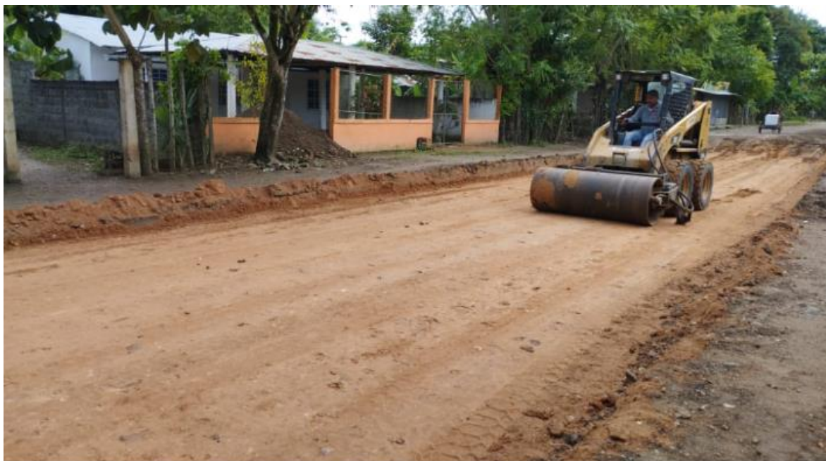
Foto 3. Instalación de afirmado del PR1+300 al PR1+160 Chuchurubí.
