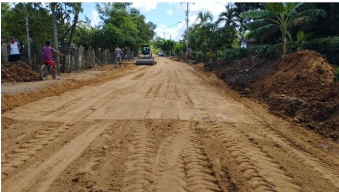
Foto 2. Instalación de afirmado del PR1+300 al PR1+160 Chuchurubí.
