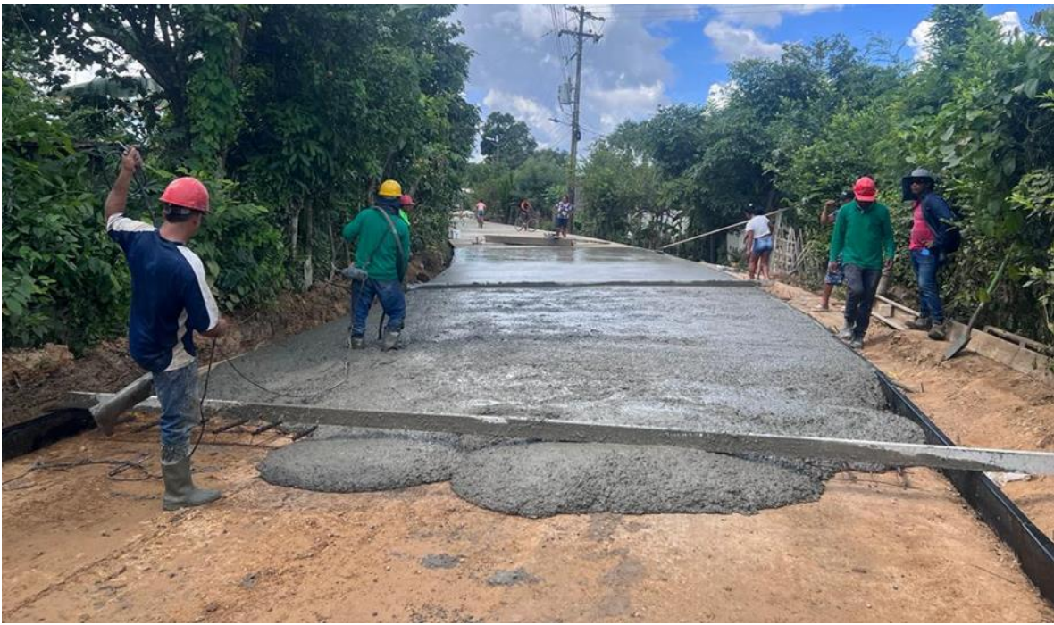
Instalación de concreto carril izquierdo
