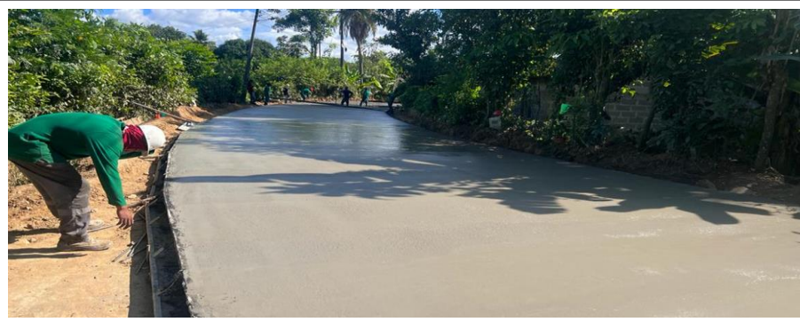
Vía San Antonio - Los cedros, El contratista instala concreto del (K0+130 AL K0+000)
