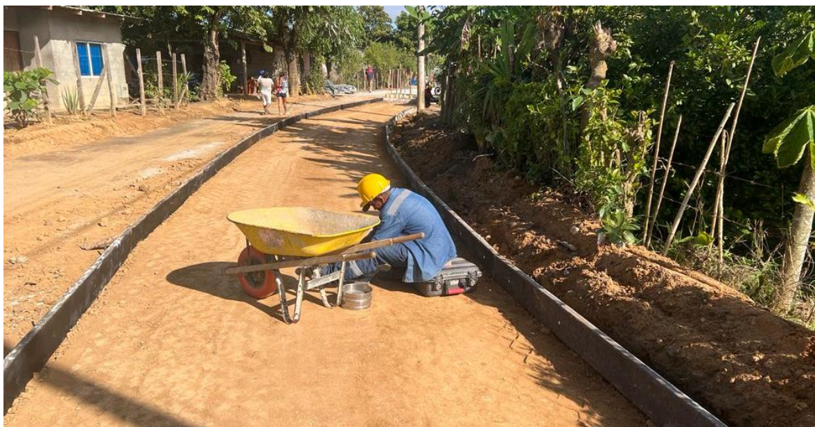
Toma de densidades en sub base
