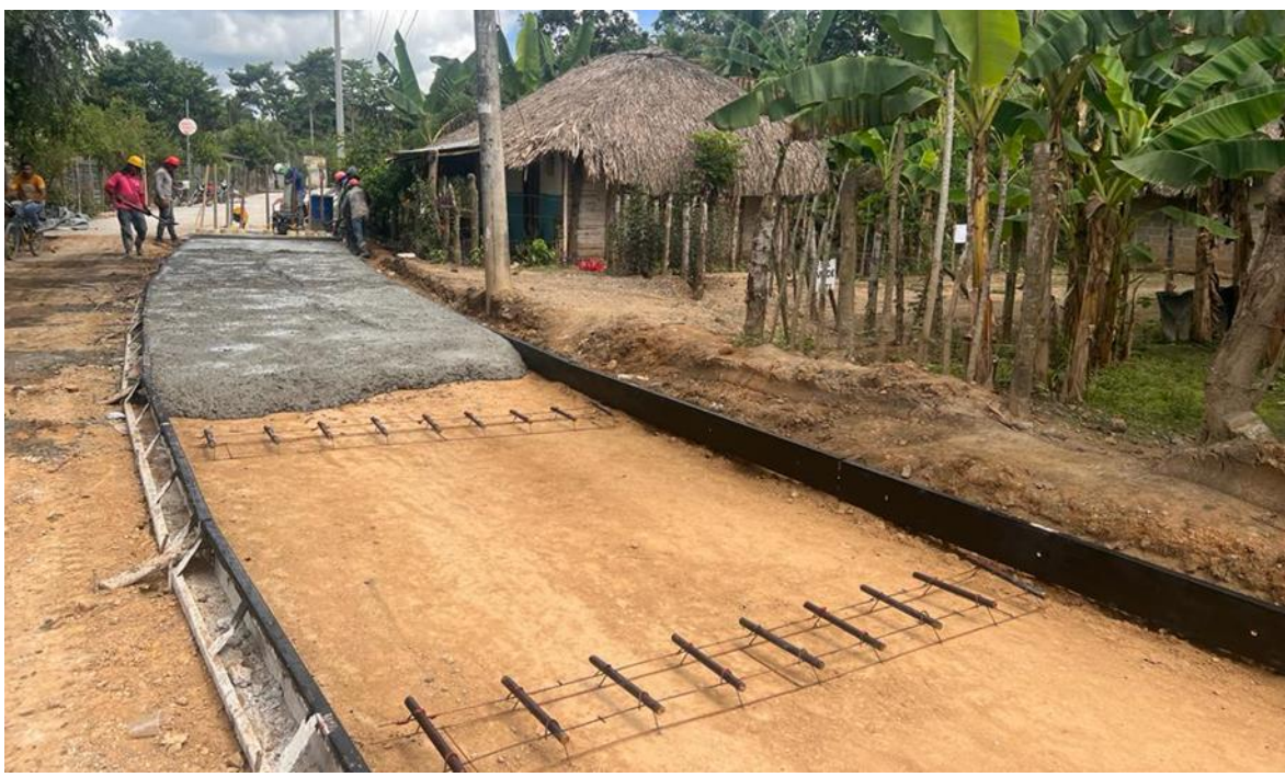
Instalación de hierro para fundida de pavimento
