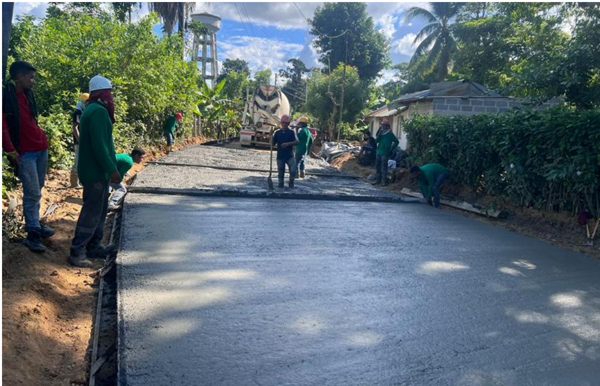
Instalación de concreto
