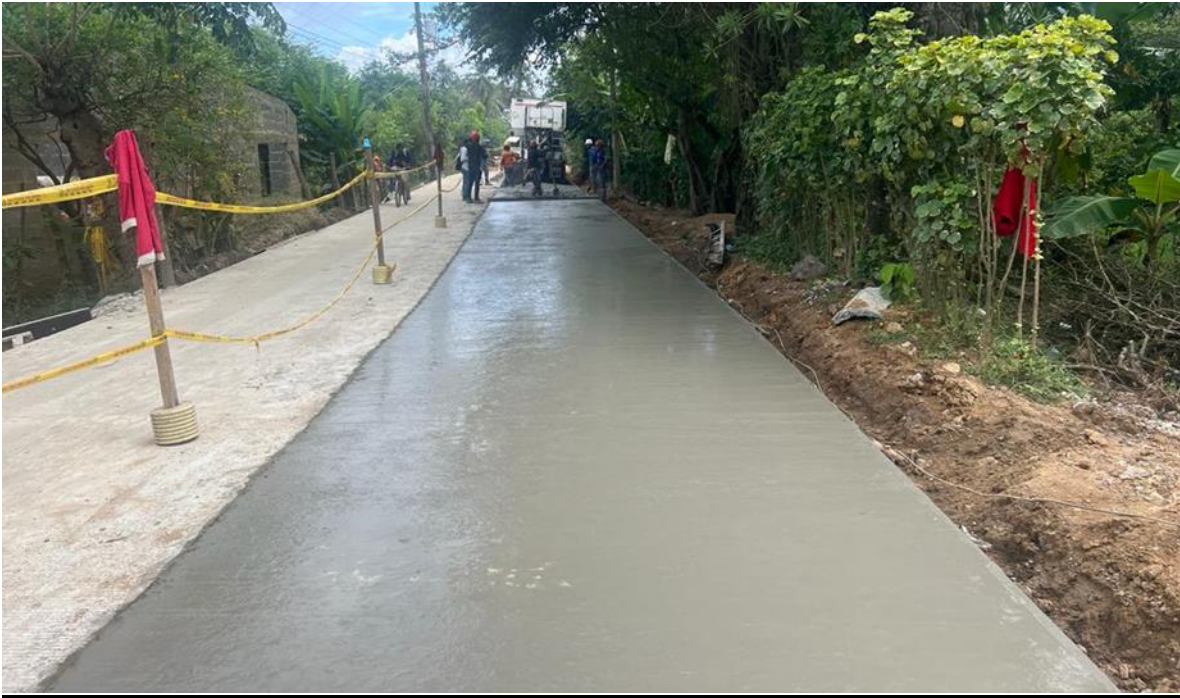
Instalación de concreto carril izquierdo
