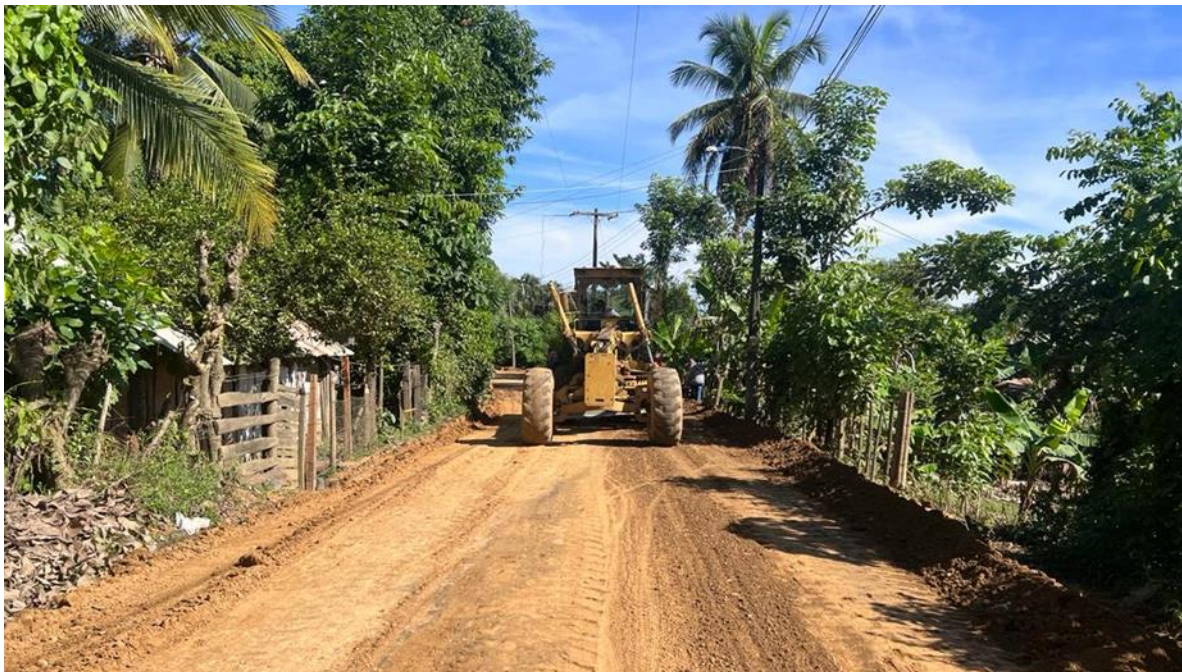
Instalación de Sub base
