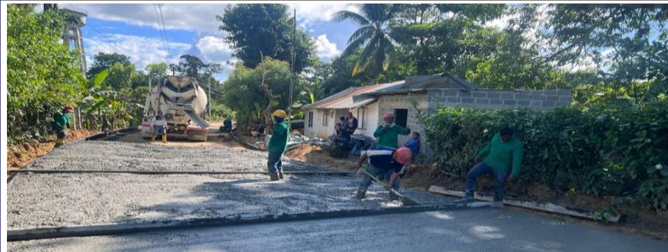
Vía San Antonio - Los cedros, El contratista instala concreto del (K0+130 AL K0+000)
