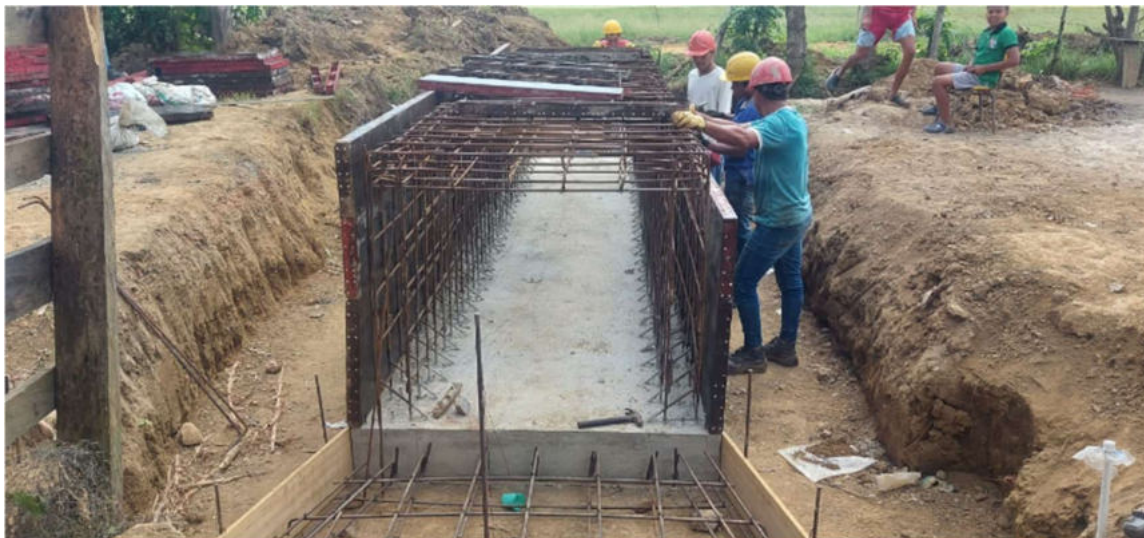
Foto 21. Armado de acero de muros, losa superior y placa descole Box PR 1+467 Media Tapa Martínez
