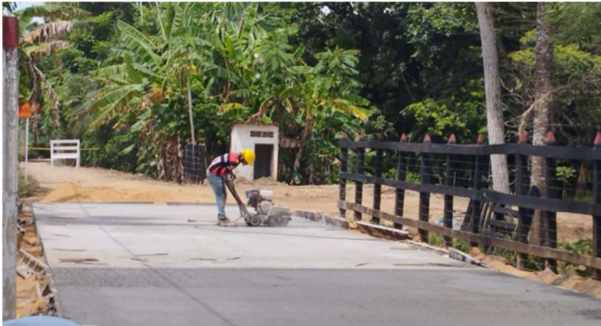
Foto 2. Corte de juntas del PR 1+450 al PR1+350 Chuchurubí.
