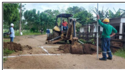
Foto1. Excavación del box culvert ubicado en el PR 0+923 del sector media tapa frente martínez.
