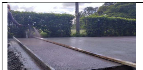
Foto 2. Instalación de concreto del PR 1+390 al PR 1+384
