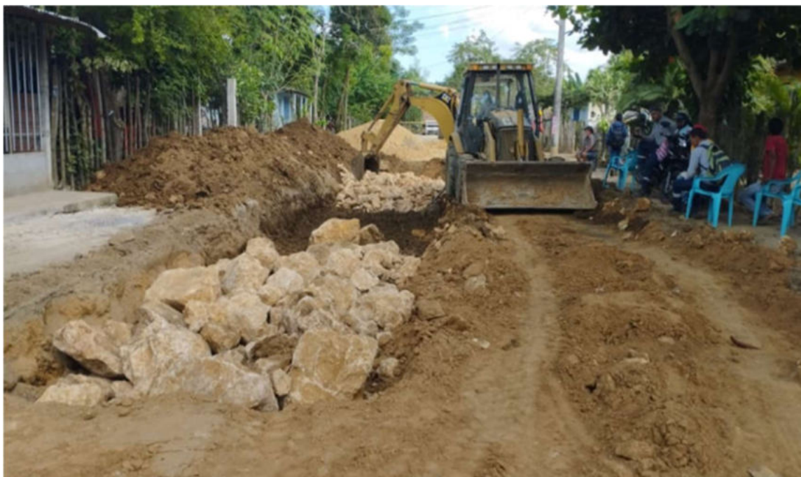
Foto 11. Mejoramiento con piedra rajón entre el PR 1+250 al PR 1+100 Chuchurubí.
