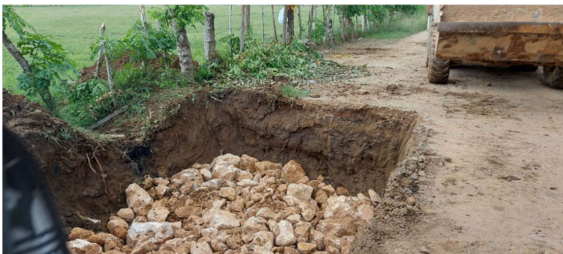
Foto 18. Excavación y mejoramiento Box PR 1+467 Media Tapa – Martínez
