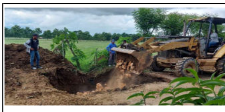
Foto 2. Excavación Box culvert del PR 1+466 del sector media tapa de Martínez
