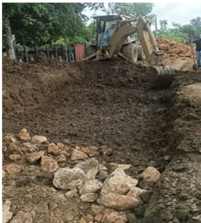
Foto 10. Mejoramiento con piedra rajón entre el PR 1+250 al PR 1+100 Chuchurubí.
