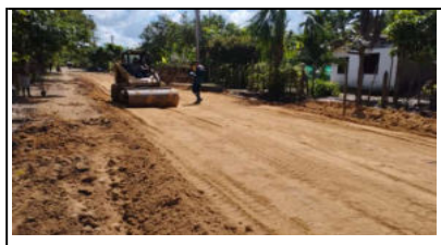
Foto 1. Instalación de afirmado del PR1+210 al PR1+160
