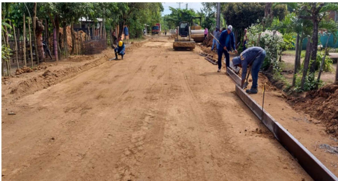
Foto 13. Instalación de subbase entre el PR 1+250 al PR 1+100 Chuchurubí.
