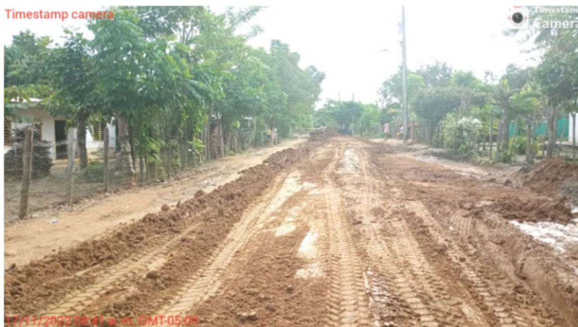
Foto 4. Excavaciones del PR 1+350 al PR 1+250
