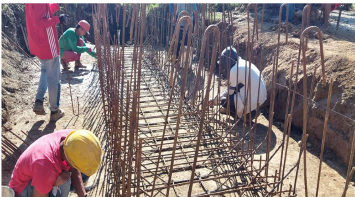
Foto 20. Amarre de acero Placa de fondo y muros Box PR 1+467 Media Tapa – Martínez
