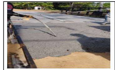
Foto 3. Instalación de concreto del PR 1+450 al PR 1+390
