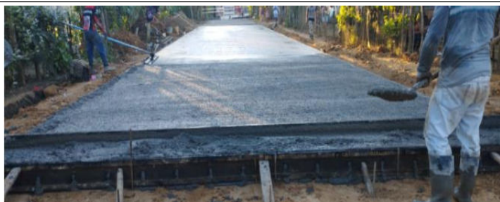
Foto 3. Instalación de concreto hidráulico para pavimento del PR 1+315 al PR 1+190 en chuchurubí.
