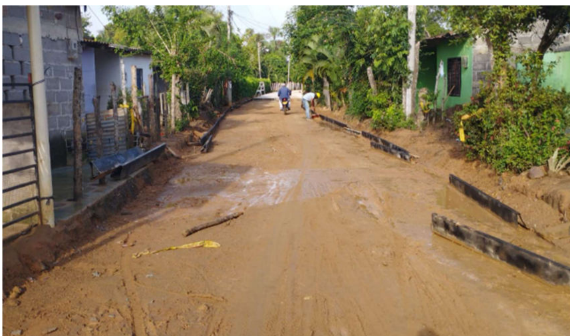
Foto 16. Daños por lluvias en Chuchurubí.
