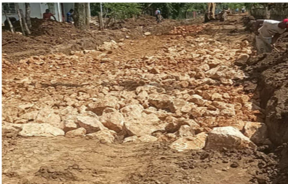
Foto 12. Mejoramiento con piedra rajón entre el PR 1+250 al PR 1+100 Chuchurubí.
