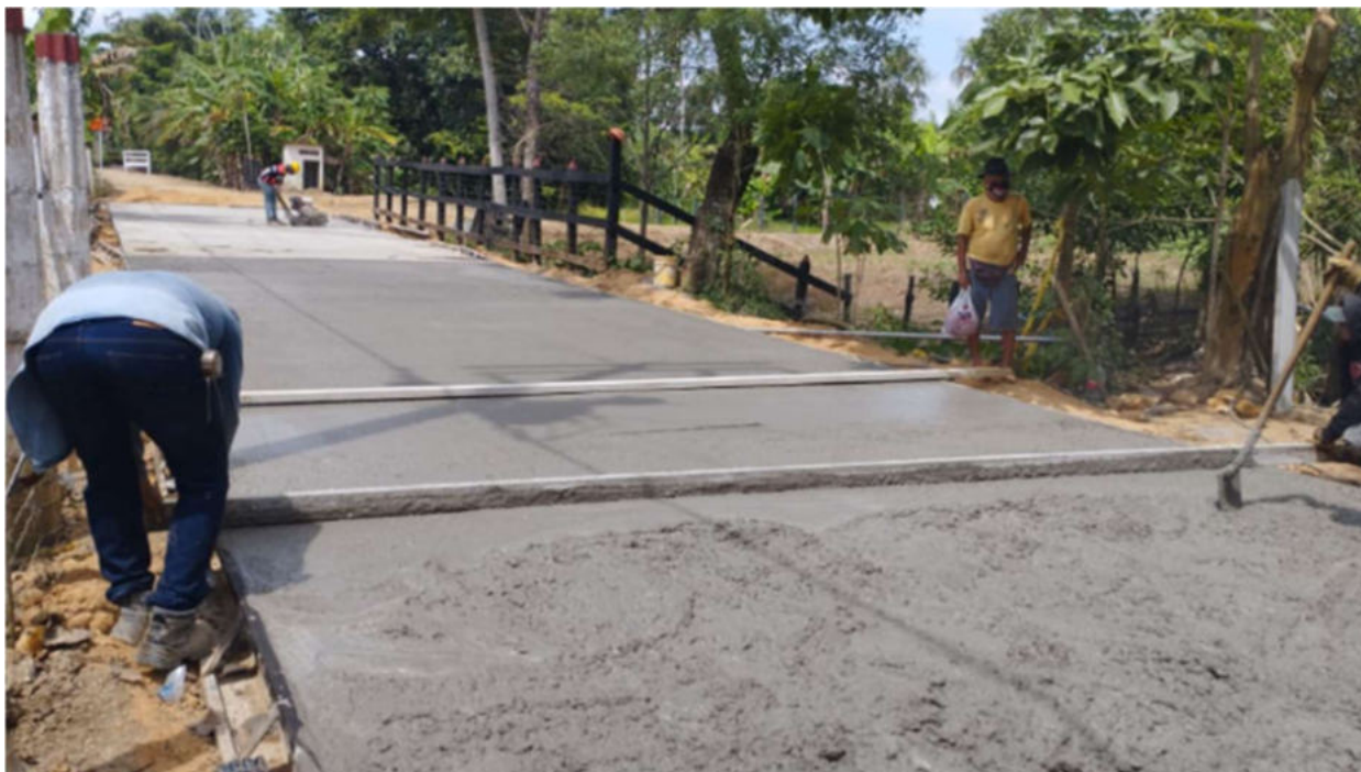
Foto 1. Instalación de pavimento del PR 1+450 al PR 1+350 Chuchurubí.
