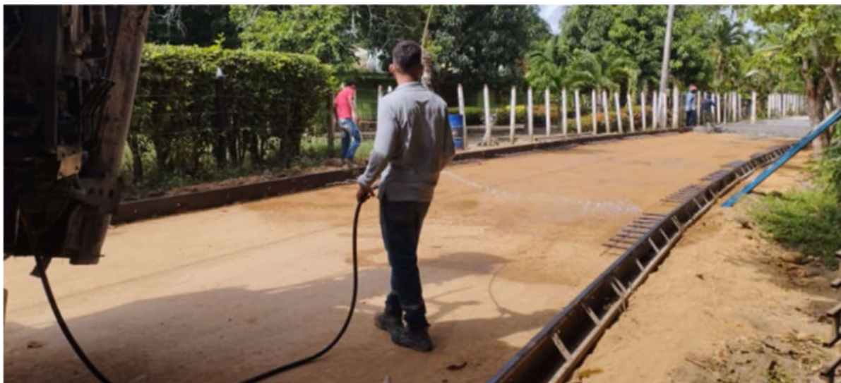
Foto 3. Instalación de pavimento del PR1+450 al PR 1+350 Chuchurubí.
