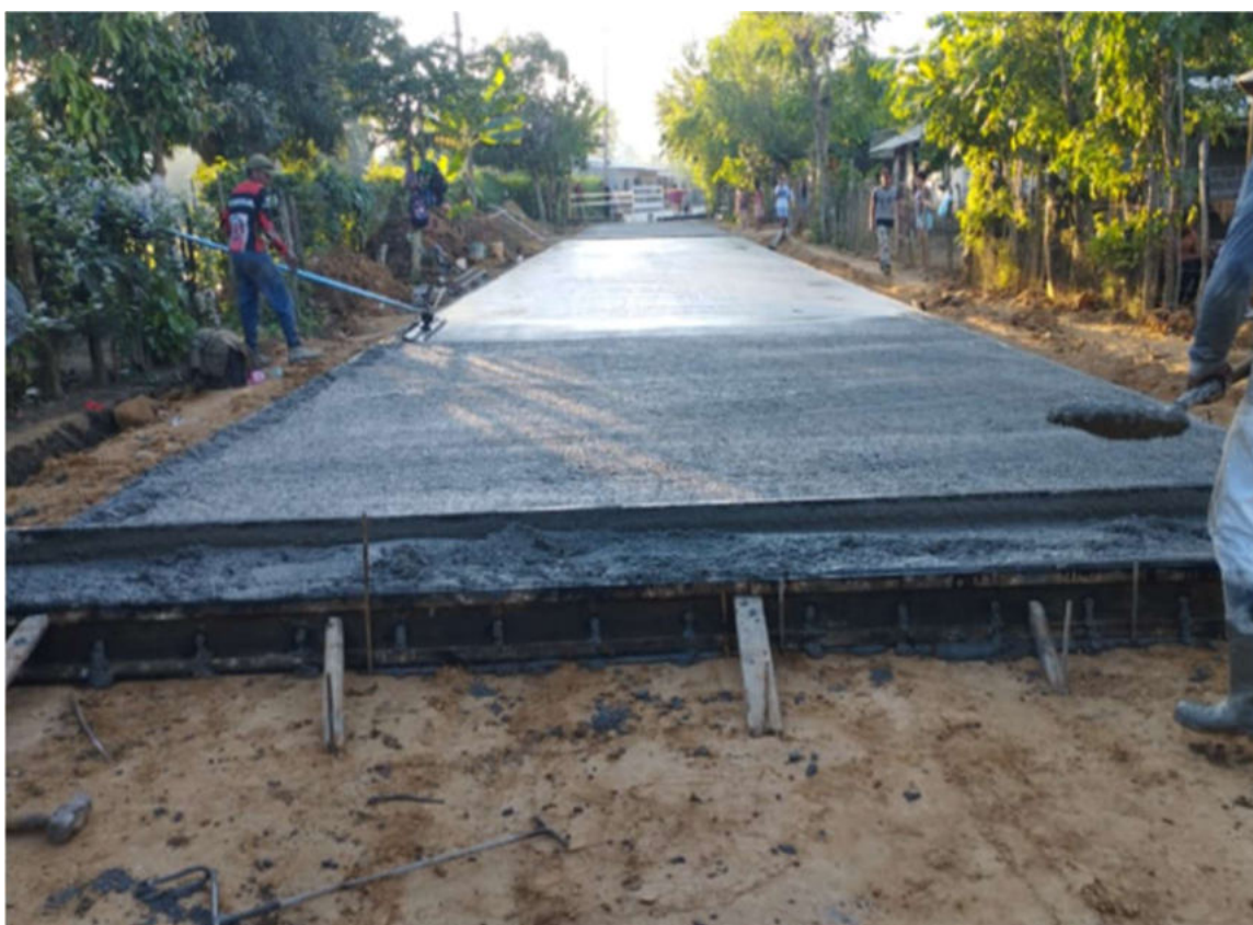
Foto 14. Instalación de pavimento entre el PR 1+250 al PR 1+140 Chuchurubí.
