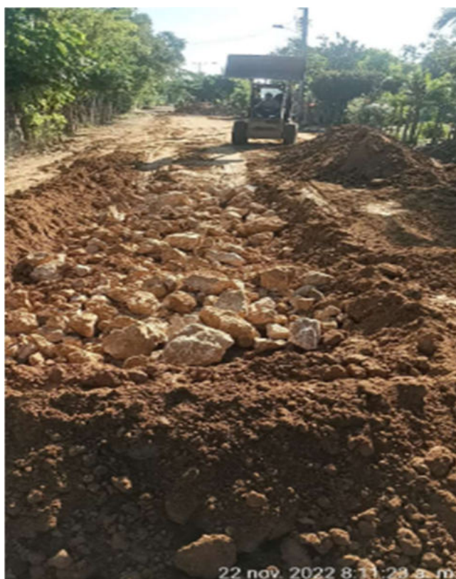
Foto 9. Mejoramiento con piedra rajón entre el PR 1+250 al PR 1+100 Chuchurubí.
