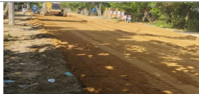
Foto 2. Instalación de subbase del PR 1+230 al PR 1+180, frente chuchurubí
