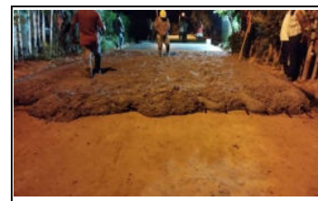
Foto 3. Instalación de concreto para pavimento del PR 1+384 al PR 1+315 en chuchurubí.
