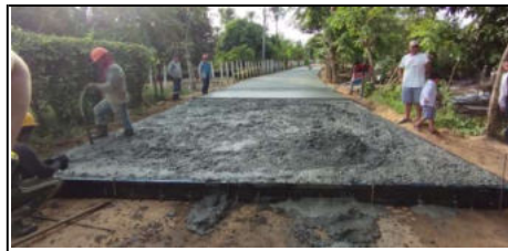
Foto 2. Instalación de concreto del PR 1+450 al PR 1+390
