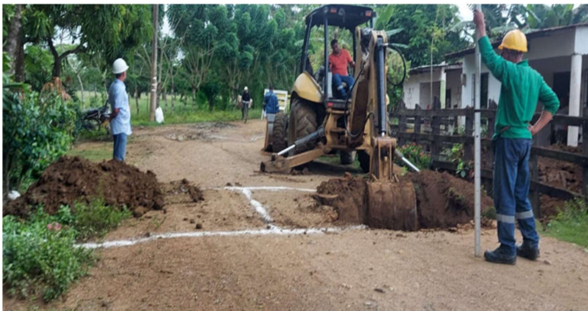
Foto 19. Excavación Box PR 0+922 Media Tapa – Martínez
