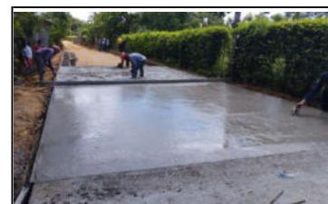
Foto 3. Instalación de concreto del PR 1+390 al PR 1+384
