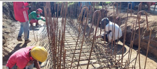
Foto 4. Armado de acero de losa de fondo y muros Box culvert del PR 1+466 del sector media tapa de martínez.
