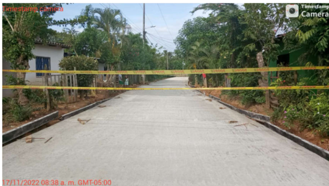
Foto 7. Instalación de pavimento del PR 1+350 al PR 1+250 Chuchurubí.
