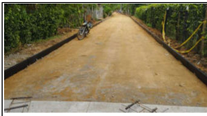
Foto1. Instalación de subbase del PR 1+450 al PR 1+300
