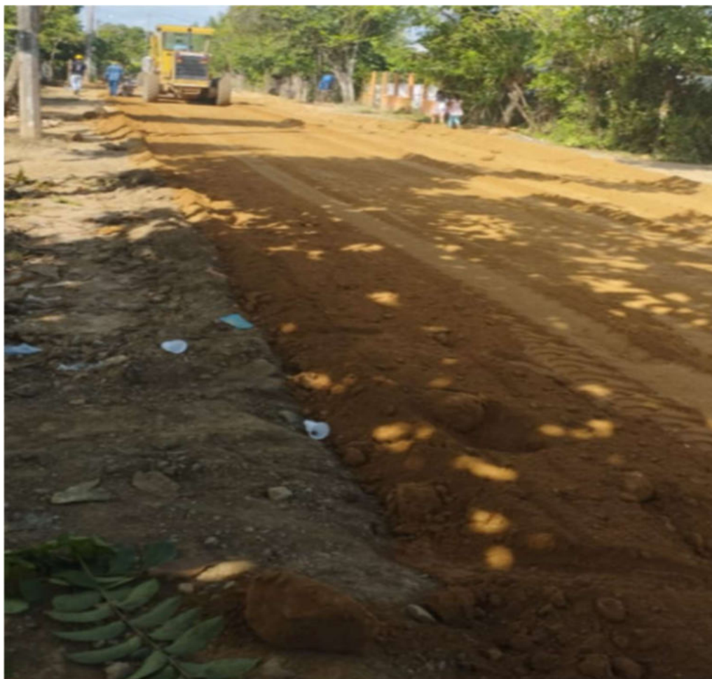
Foto 5. Instalación de subbase del PR 1+350 al PR 1+250 Chuchurubí.
