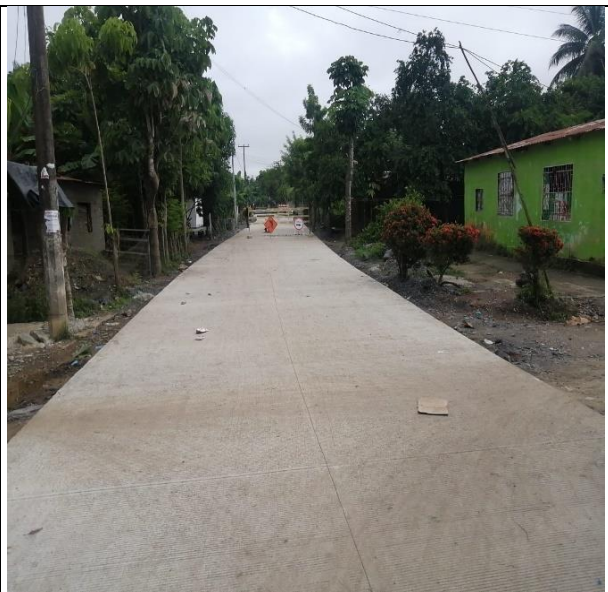
Concreto hidráulico MR38 K2+830
