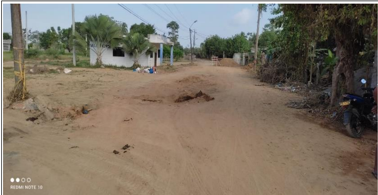
Vía en afirmado regular PR 0+000
