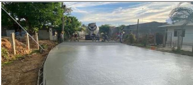
Foto 1. Pavimento hasta el PR 0+000 Martínez - Tramo T5
