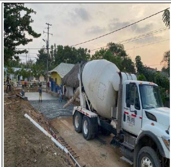
FOTO No.49 Fundida de concreto en tramo T4 entre absc K0+75.1911 a la K0+000
