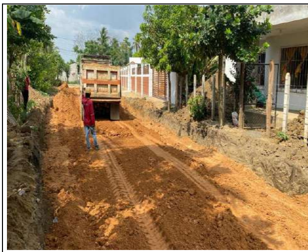
FOTO No. 30 Suministro e extendía de material afirmado Tramo T4 entre absc K0+75.19 a la K0+000
