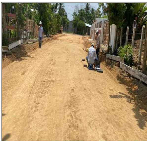
FOTO No. 41 Toma de densidades a capa sub base granular tramo T4 entre absc K0+75.19 la K0+000
