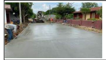
Foto 3. Pavimento hasta el PR 0+190 TRAMO MARTINEZ T5
