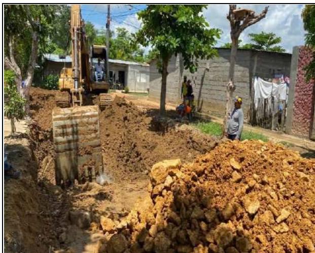
FOTO No. 10 Mejoramientos a subrasante con piedra rajón a tramo A3 20 de julio entre absc K0+445 a la K0+390
