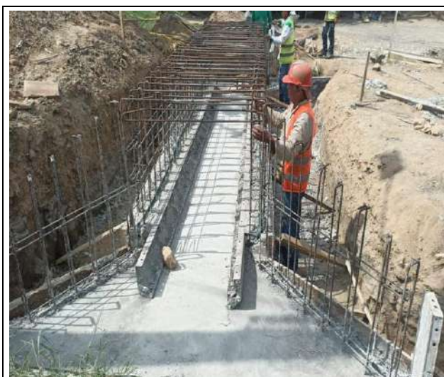
FOTO No. 18 Fundida de losa de fondo box la lucha absc K0+010
