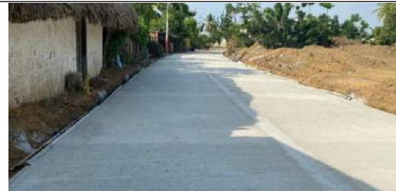
Foto 4. Instalación de Concreto para Pavimento hasta el PR 0+00 Martínez- Tramo T4
