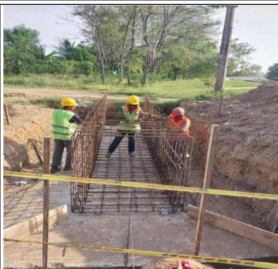
FOTO No. 13 Arme de acero de box la lucha absc K0+010
