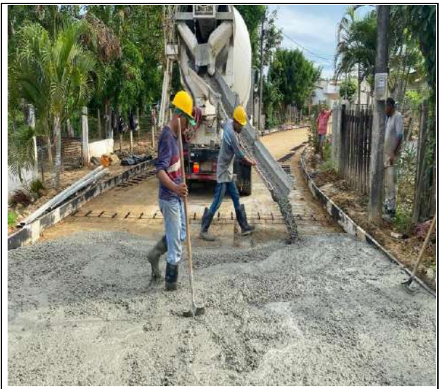
FOTO No. 54 Fundida de concreto en tramo T5 entre absc K0+190 a la K0+000
