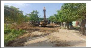
Foto 1. Excavacion hasta el PR 0+330 TRAMO 20 DE JULIO - MARTINEZ
