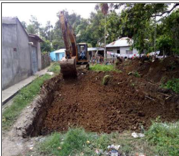
FOTO No. 5 Excavación Tramo A4 20 de julio entre absc K0+410.1 a la K0+390
