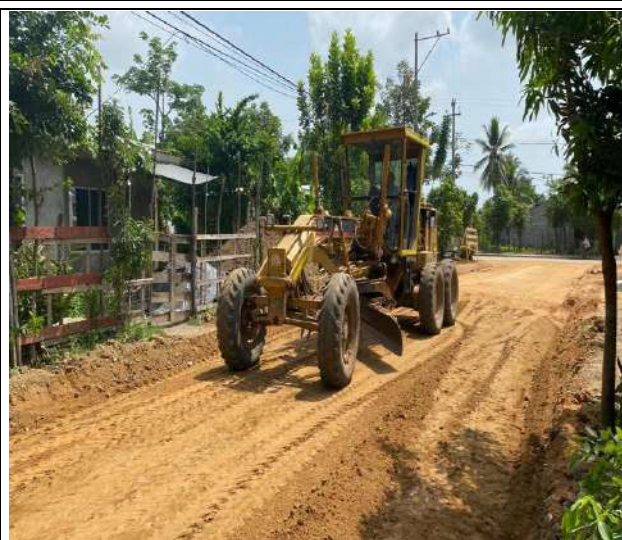
FOTO No. 34 Suministro e instalación de material sub base granular Tramo T4 entre absc K0+75.19 la K0+000
