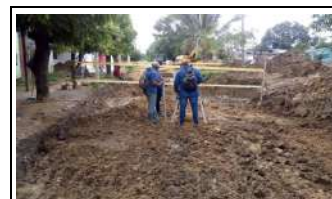
Foto 3. Excavacion Para Mejoramiento con Piedra Rajon hasta el PR 0+403 - PR+0393 TRAMO A4 20 DE JULIO - MARTINEZ
