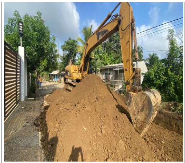
FOTO No. 26 Excavación Mecánica Tramo T4 entre absc K0+75.19 a la K0+000
