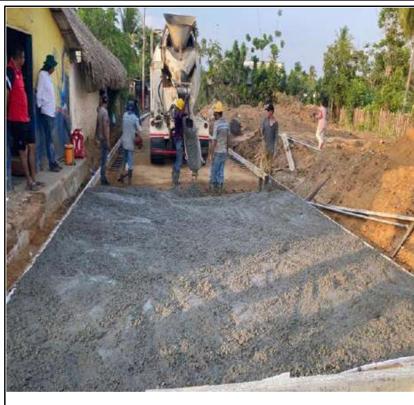
FOTO No.49 Fundida de concreto en tramo T4 entre absc K0+75.1911 a la K0+000
