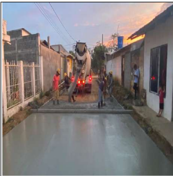
FOTO No. 55 Fundida de concreto en tramo T5 entre absc K0+190 a la K0+000
