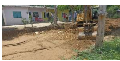
Foto 2. Excavacion Para Mejoramiento con Piedra Rajon hasta el PR 0+455 TRAMO A4 20 DE JULIO - MARTINEZ
