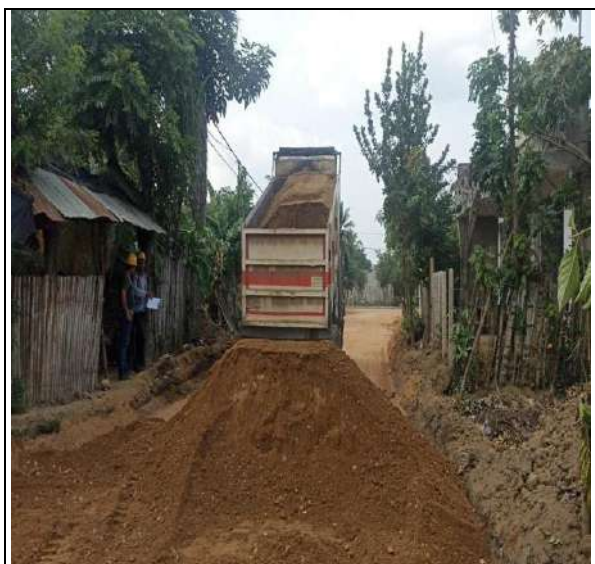
FOTO No. 33 Suministro e instalación de material sub base granular Tramo T4 entre absc K0+75.19 la K0+000
