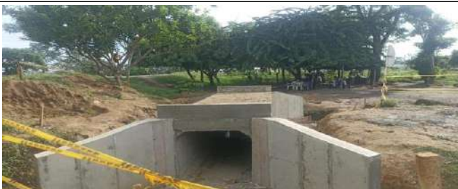
Foto 3. Box - Coulvert PR 0+010 Martínez - Tramo La Lucha
