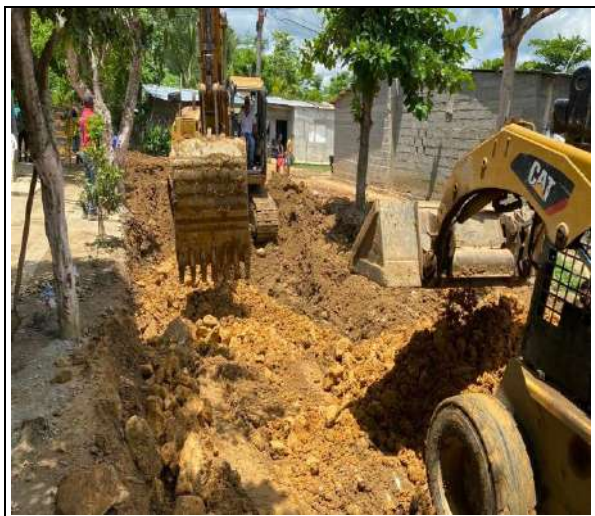
FOTO No. 9 Mejoramientos a subrasante con piedra rajón a tramo A3 20 de julio entre absc K0+445 a la K0+390
