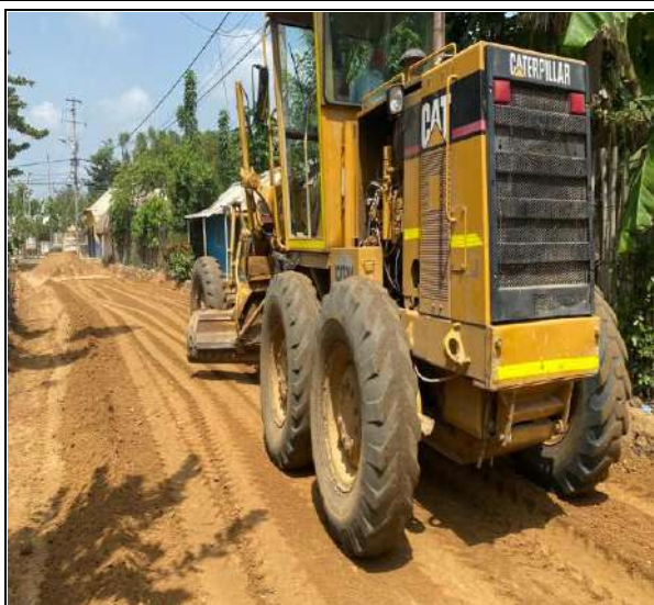
FOTO No. 33 Suministro e instalación de material sub base granular Tramo T4 entre absc K0+75.19 la K0+000
