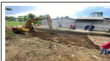
Foto 1. Excavacion Para Mejoramiento con Piedra Rajon hasta el PR 0+380 TRAMO A4 20 DE JULIO - MARTINEZ
