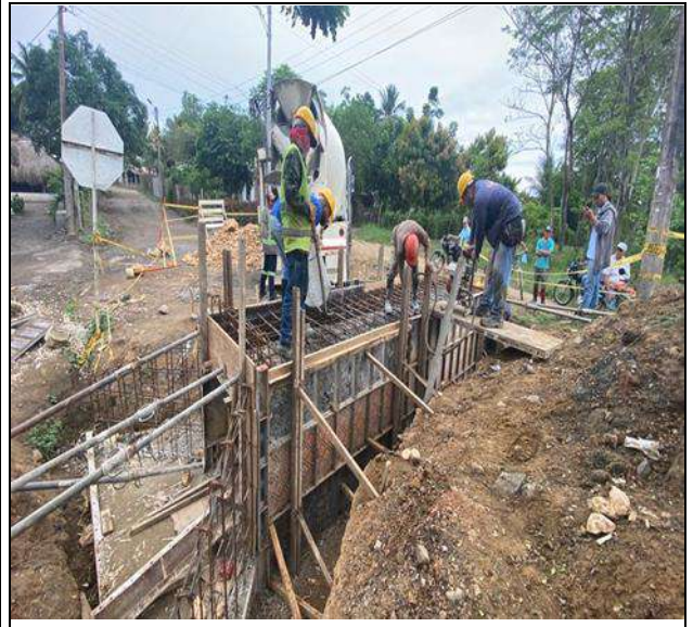
FOTO No. 22 Fundida de Concreto de muros y losa box la lucha absc K0+010
