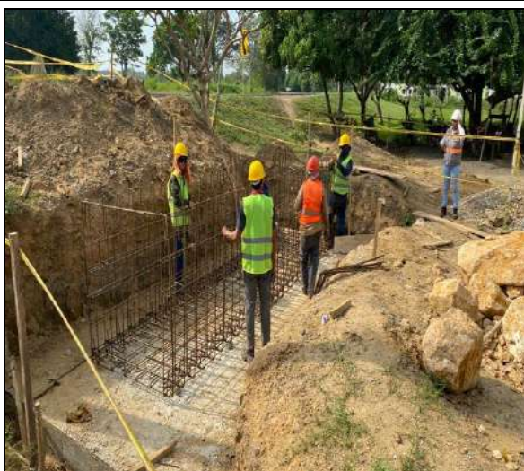
FOTO No. 13 Arme de acero de box la lucha absc K0+010
