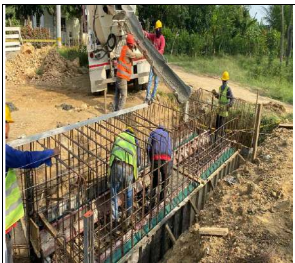
FOTO No. 17 Fundida de losa de fondo box la lucha absc K0+010
