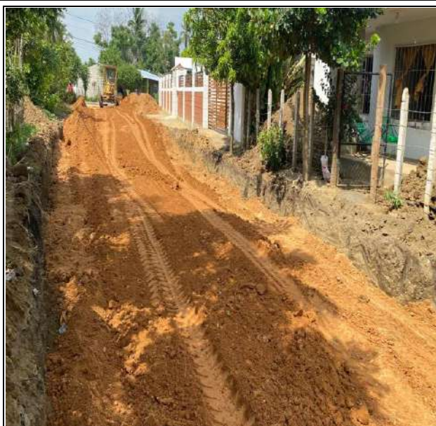
FOTO No. 30 Suministro e extendía de material afirmado Tramo T4 entre absc K0+75.19 a la K0+000
