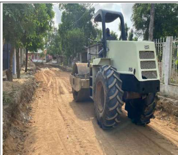
FOTO No. 38 Compactación de capa sub base granular tramo T4 entre absc K0+75.19 la K0+000
