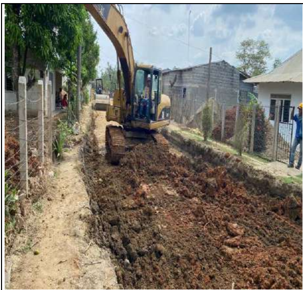
FOTO No. 25 Excavación Mecánica Tramo T4 entre absc K0+75.19 a la K0+000
