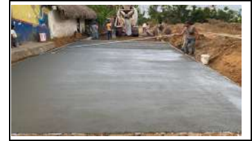
Foto 3. Pavimento hasta el PR 000 TRAMO MARTINEZ T4
