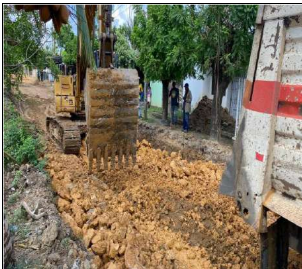
FOTO No. 9 Mejoramientos a subrasante con piedra rajón a tramo A3 20 de julio entre absc K0+445 a la K0+390
