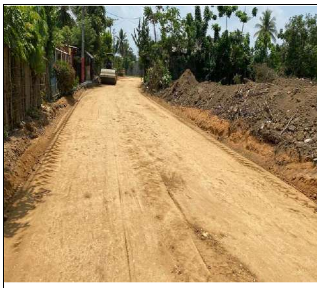
FOTO No. 40 Compactación de capa sub base granular tramo T4 entre absc K0+75.19 la K0+000
