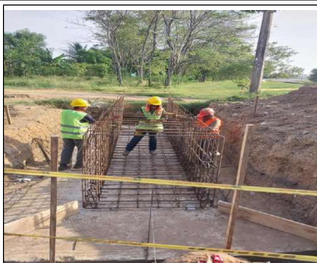
FOTO No. 14 Arme de acero de box la lucha absc K0+010
