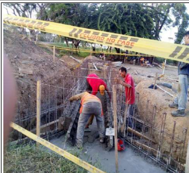
FOTO No. 18 Fundida de losa de fondo box la lucha absc K0+010
