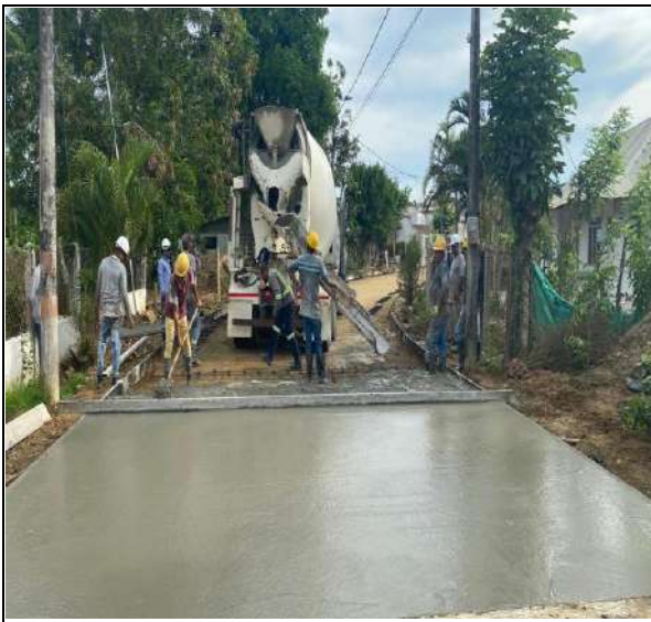
FOTO No.53 Fundida de concreto en tramo T5 entre absc K0+190 a la K0+000
