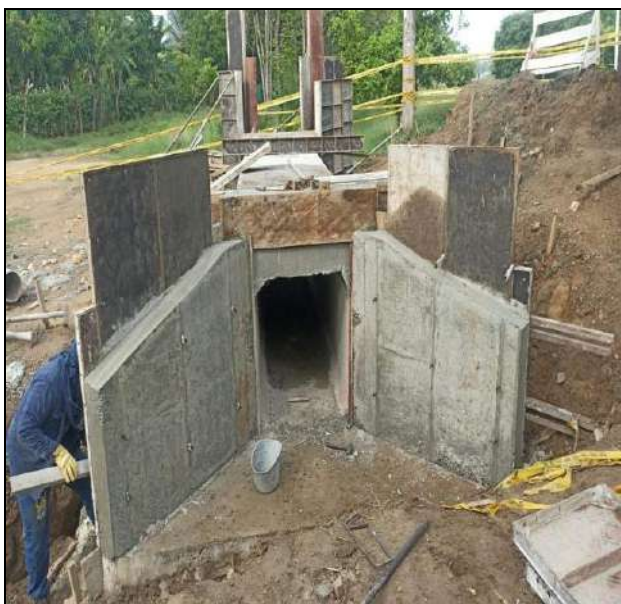
FOTO No. 21 Fundida de Concreto de muros y losa box la lucha absc K0+010
