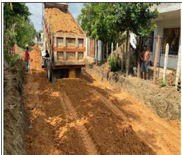
FOTO No. 29 Suministro e extendía de material afirmado Tramo T4 entre absc K0+75.19 a la K0+000
