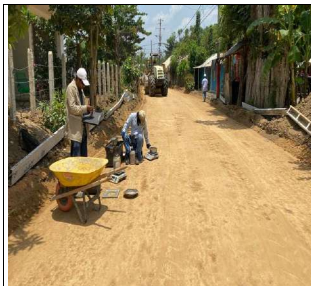
FOTO No. 42 Toma de densidades a capa sub base granular tramo T4 entre absc K0+75.19 la K0+000
