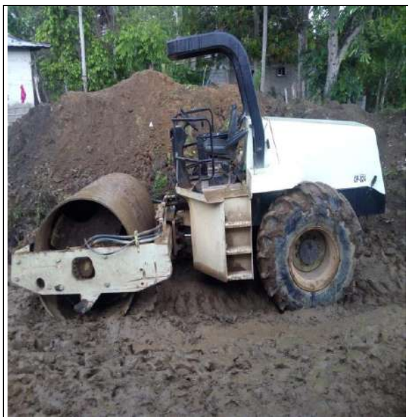
FOTO No. 7 Compactación a subrasante Tramo A4 20 de julio
