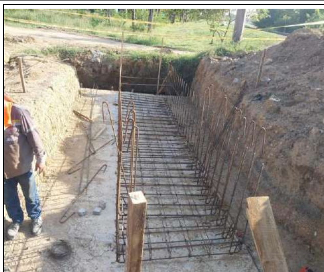
FOTO No. 14 Arme de acero de box la lucha absc K0+010
