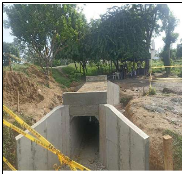
FOTO No. 22 Fundida de Concreto de muros y losa box la lucha absc K0+010
