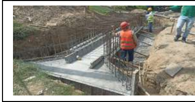
Foto 2. Fundida de Concreto de losa de fondo, soleras y dentellon PR 0+010 BOX COULVERT - LA LUCHA
