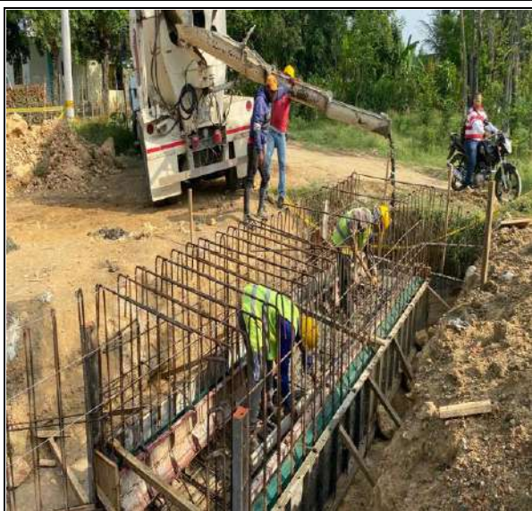
FOTO No. 17 Fundida de losa de fondo box la lucha absc K0+010
