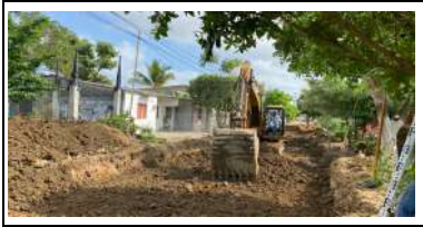
Foto 1. Excavacion hasta el PR 0+330 TRAMO 20 DE JULIO - MARTINEZ
