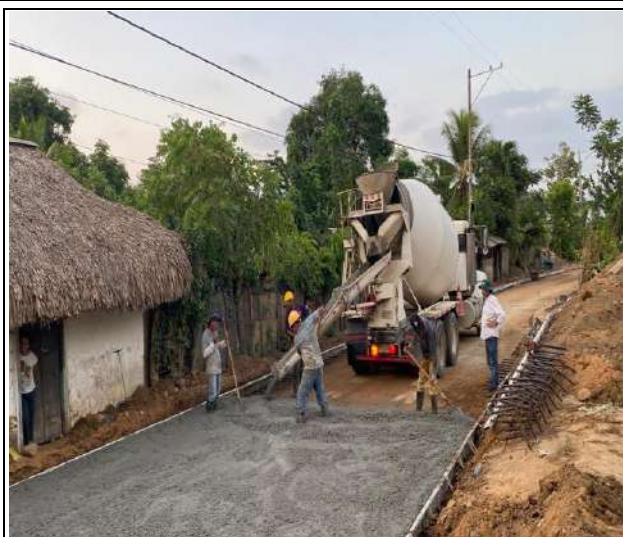
FOTO No. 50 Fundida de concreto en tramo T4 entre absc K0+75.1911 a la K0+000
