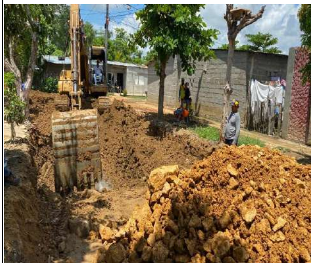
FOTO No. 10 Mejoramientos a subrasante con piedra rajón a tramo A3 20 de julio entre absc K0+445 a la K0+390
