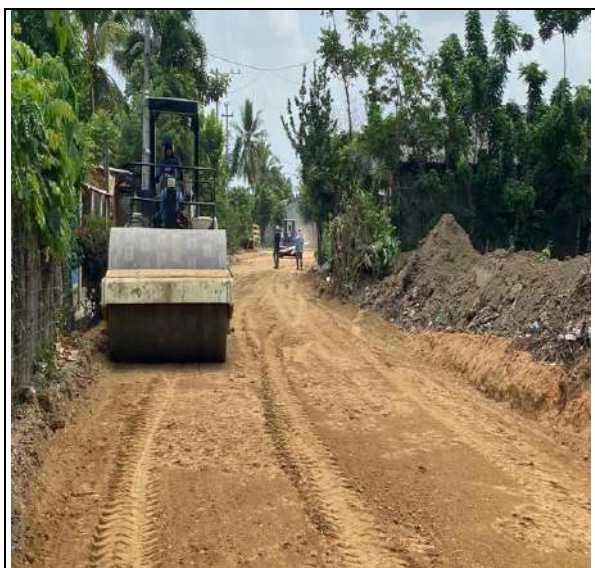
FOTO No. 39 Compactacion de capa sub base granular entre absc K0+75.19 a la K0+000
