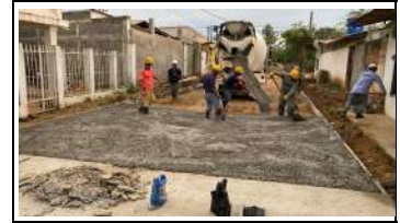
Foto 3. Se finalizo Pavimento hasta el PR 000 TRAMO MARTINEZ T5
