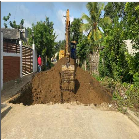
FOTO No. 25 Excavación Mecánica Tramo T4 entre absc K0+75.19 a la K0+000
