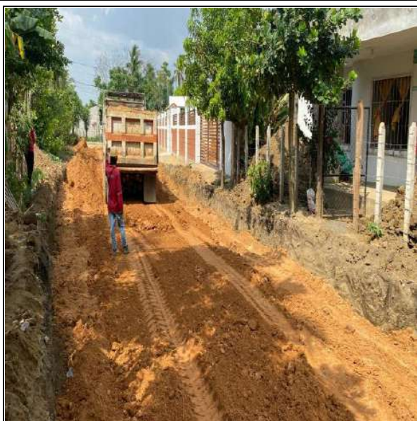
FOTO No. 29 Suministro e extendía de material afirmado Tramo T4 entre absc K0+75.19 a la K0+000
