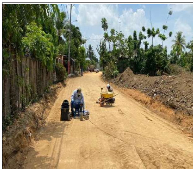
FOTO No. 42 Toma de densidades a capa sub base granular tramo T4 entre absc K0+75.19 la K0+000
