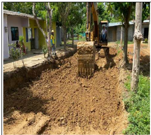
FOTO No. 3 Excavación Tramo A3 20 de julio entre absc K0+445 a la K0+380
