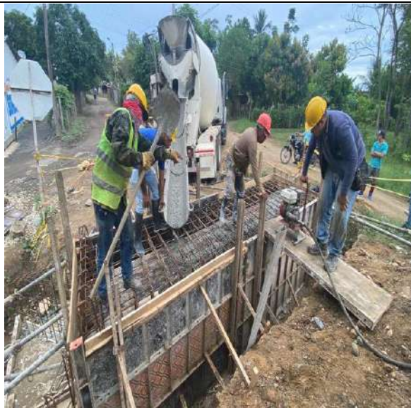
FOTO No. 21 Fundida de Concreto de muros y losa box la lucha absc K0+010
