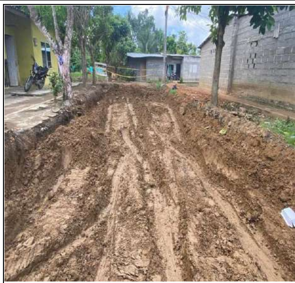
FOTO No. 1 Excavación Tramo A3 20 de julio entre absc K0+445 a la K0+380
