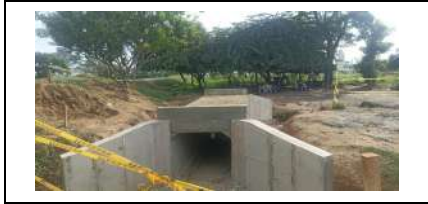
Foto 2. Box terminado, PR 0+010 BOX COULVERT - LA LUCHA
