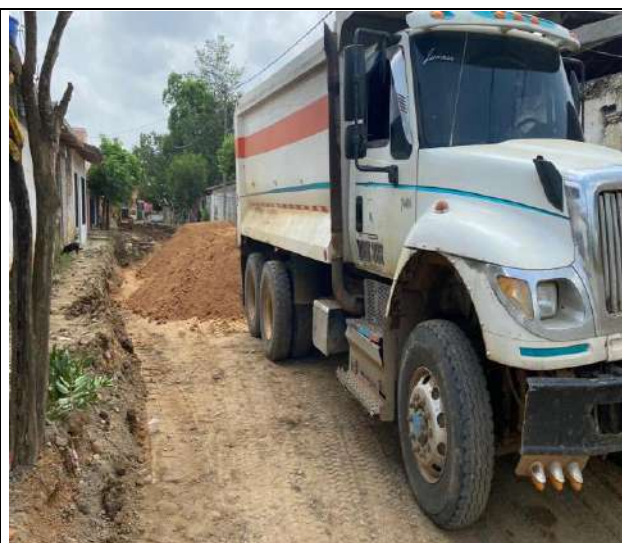
FOTO No. 34 Suministro e instalación de material sub base granular Tramo T4 entre absc K0+75.19 la K0+000
