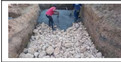
Foto 2. Fundida de Concreto ciclopeo y solado PR 0+010 BOX COULVERT - LA LUCHA
