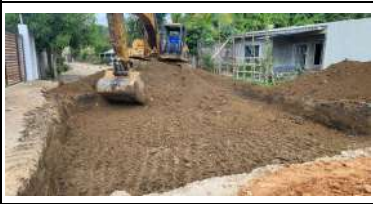
Foto 1. Excavacion hasta el PR 0+010 TRAMO T4 MARTINEZ
