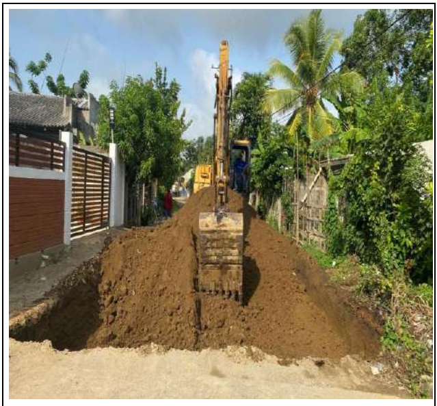
FOTO No. 26 Excavación Mecánica Tramo T4 entre absc K0+75.19 a la K0+000
