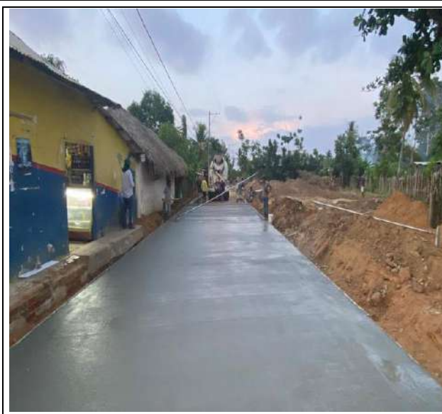
FOTO No. 50 Fundida de concreto en tramo T4 entre absc K0+75.1911 a la K0+000
