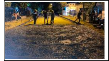
Foto 3. Pavimento hasta el PR 090 TRAMO MARTINEZ T5
