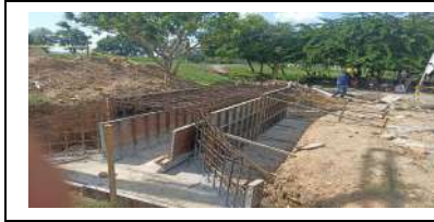
Foto 2. Encofre de muros y losa superior, PR 0+010 BOX COULVERT - LA LUCHA
