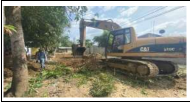
Foto 1. Excavacion hasta el PR 0+440 TRAMO 20 DE JULIO - MARTINEZ
