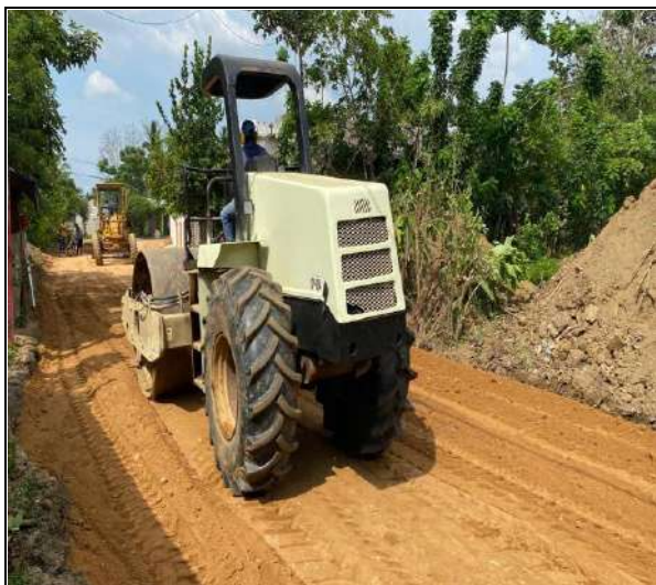
FOTO No. 37 Compactación de capa Afirmado tramo T4 entre absc K0+75.19 la K0+000
