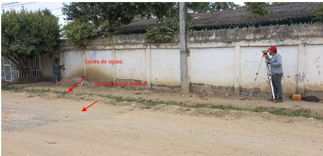
Fig. 3 Verificación punto más bajo y salida de aguas.
