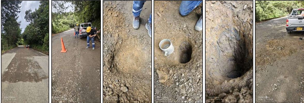
Ilustración 7. Apique No. 3 PR85+350.
