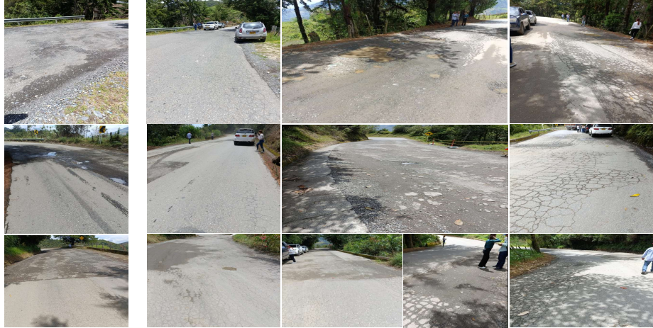
VISITA INICIAL ENTRE PR85+400 Y PR 95+400
