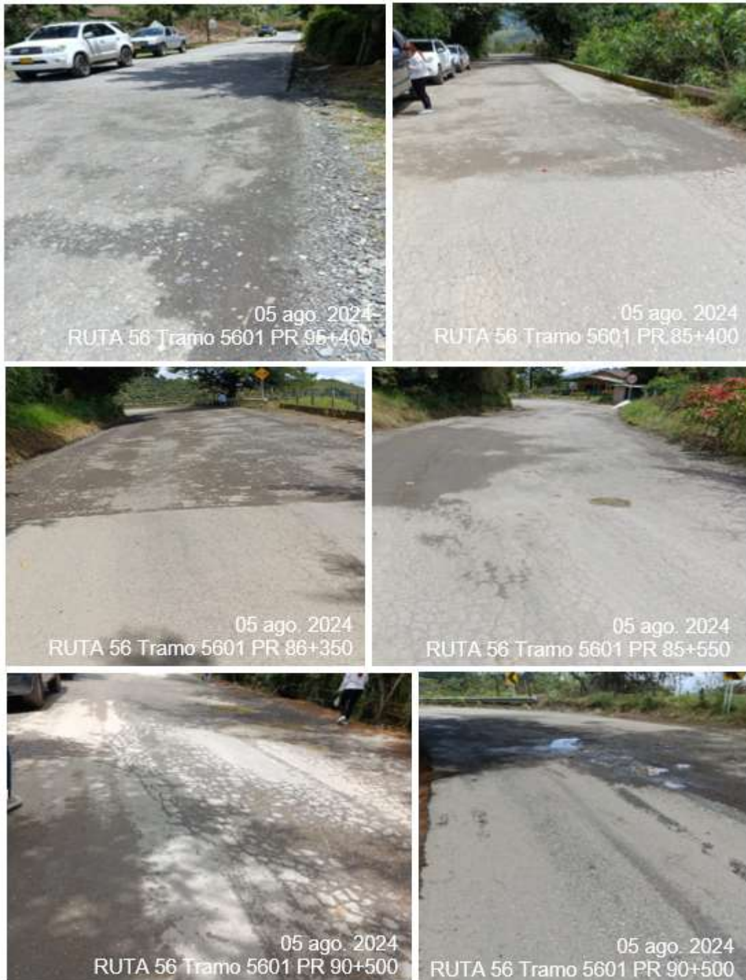
Ilustración 4. Estado inicial de la vía.
