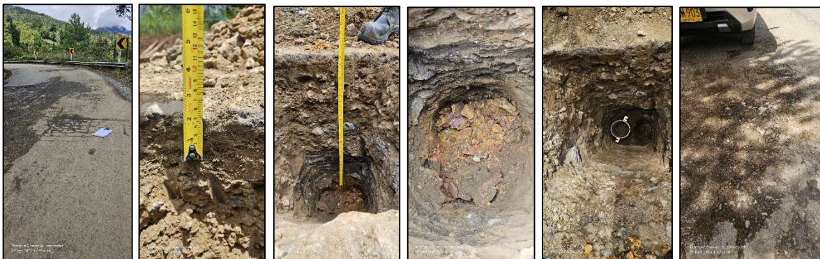
Ilustración 6. Apique No. 2 PR87+830.
