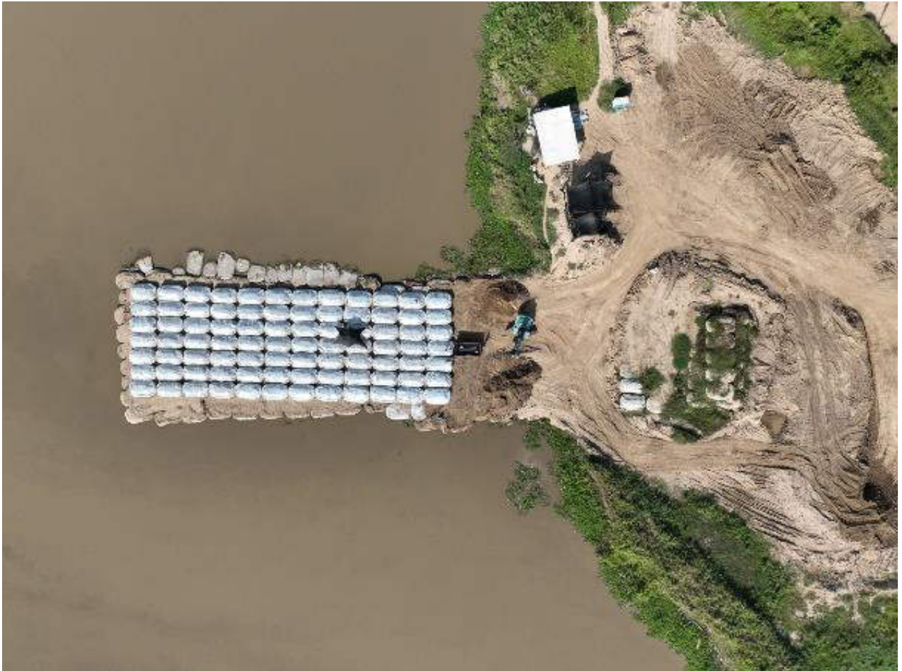
Fotografía No. 3. Fotografías Capturadas en la visita de Campo Espolón No. 3 Fuente: Visita de Campo, noviembre 11 de 2023
