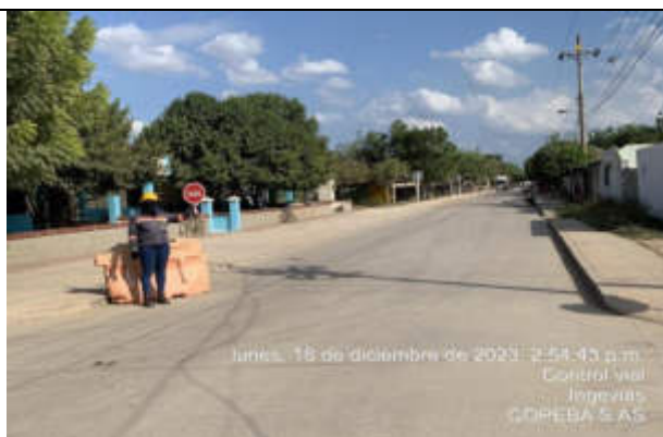
Control vial implementado para recorrido de transporte de material lote2.
