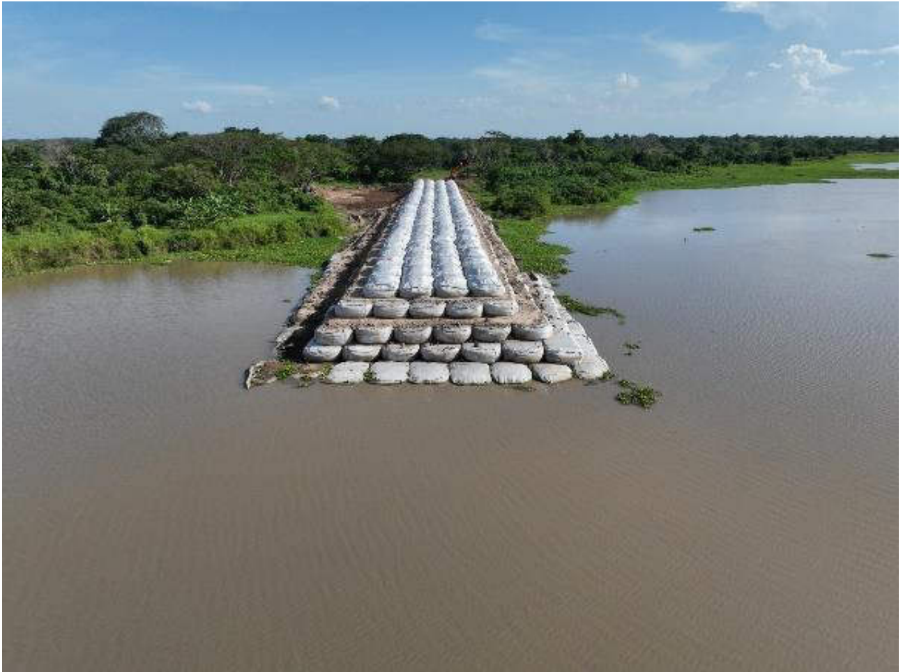
Fotografía No. 1. Fotografías Capturadas en la visita de Campo Espolón No. 1 Fuente: Visita de Campo, noviembre 11 de 2023
