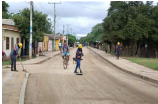
Limpieza sobre vías utilizadas para transporte de material.
