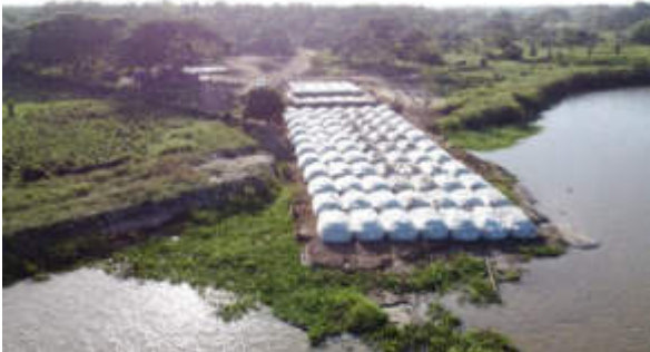
Fotos 3 y 4 Obra de Protección de orilla No. 2
