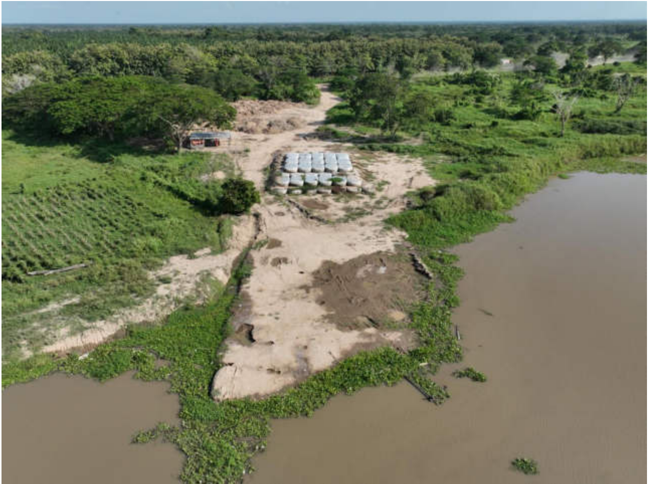
Fotografía No. 2. Fotografías Capturadas en la visita de Campo Espolón No. 2 Fuente: Visita de Campo, noviembre 11 de 2023
