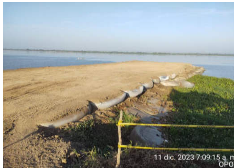
Foto 6: Lote 1 OPO #3 - VISTA POSTERIOR
