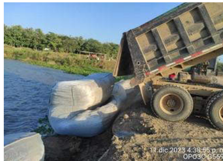
Foto 8: Lote 1 OPO #3-COSIDO DE GEOCONTENEDORES
