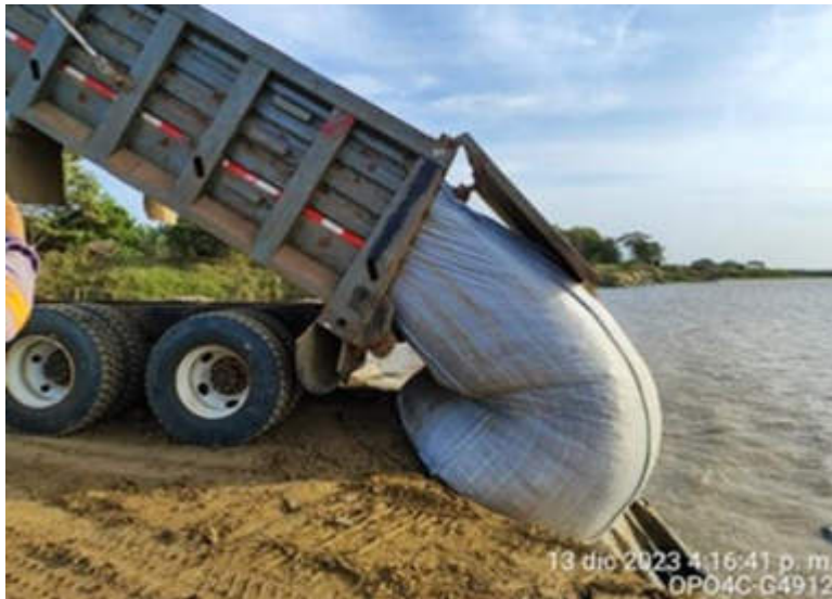
Foto 11: Lote 2 OPO #4-LANZADO DE GEOCONTENEDOR
