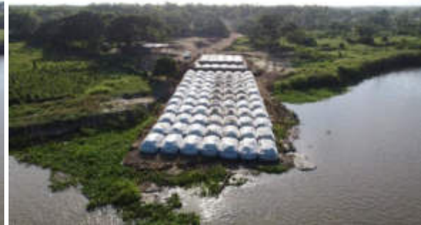
Fotos 3 y 4 Obra de Protección de orilla No. 2
