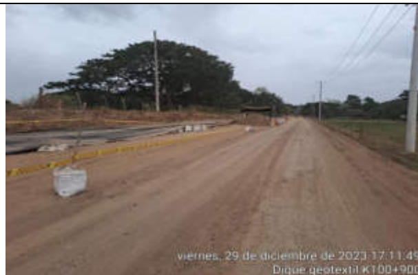
Señalización y demarcación de zonas de trabajo lote 2.
