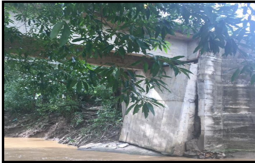
Imagen 5. Puente existente via Tierralta, K0+275
