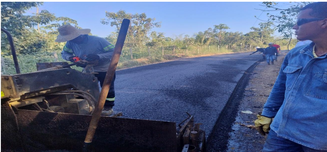
Ventoeo realizado en la Colocación de la MD-19, con la intención de mejorar la Segregación.
