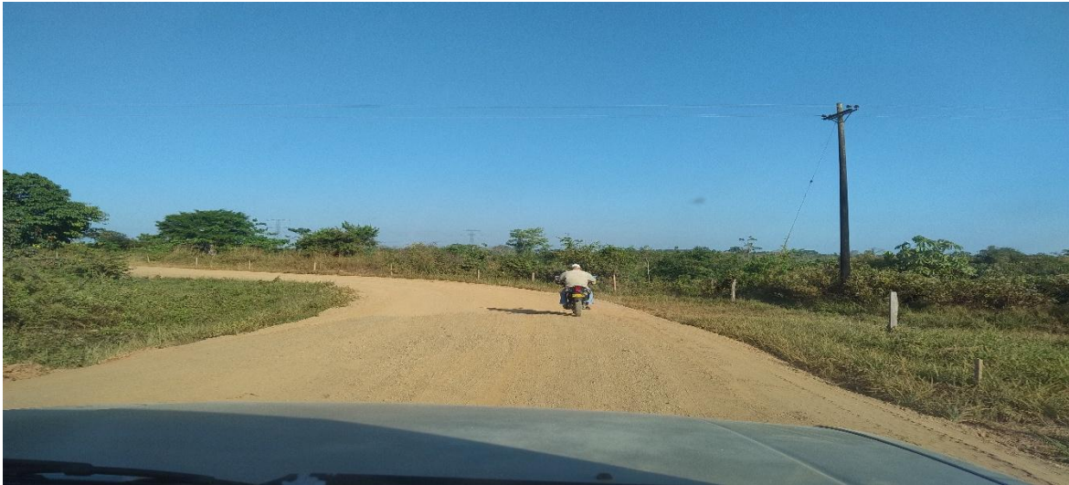
Final de la Colocación de la Subbase Granular (2.930 ml)
