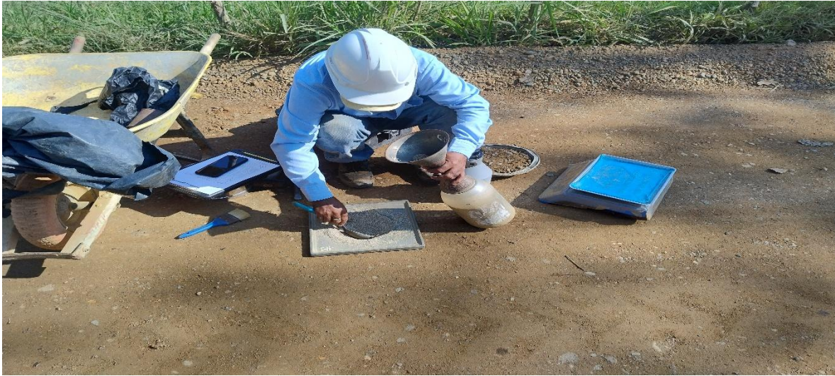
Toma de Densidades sobre la Subbase Granular
