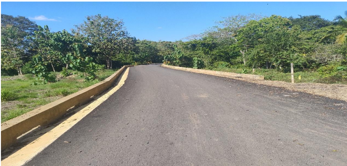
K0+500, Vía con Cunetas Bordillos y Drenaje.
