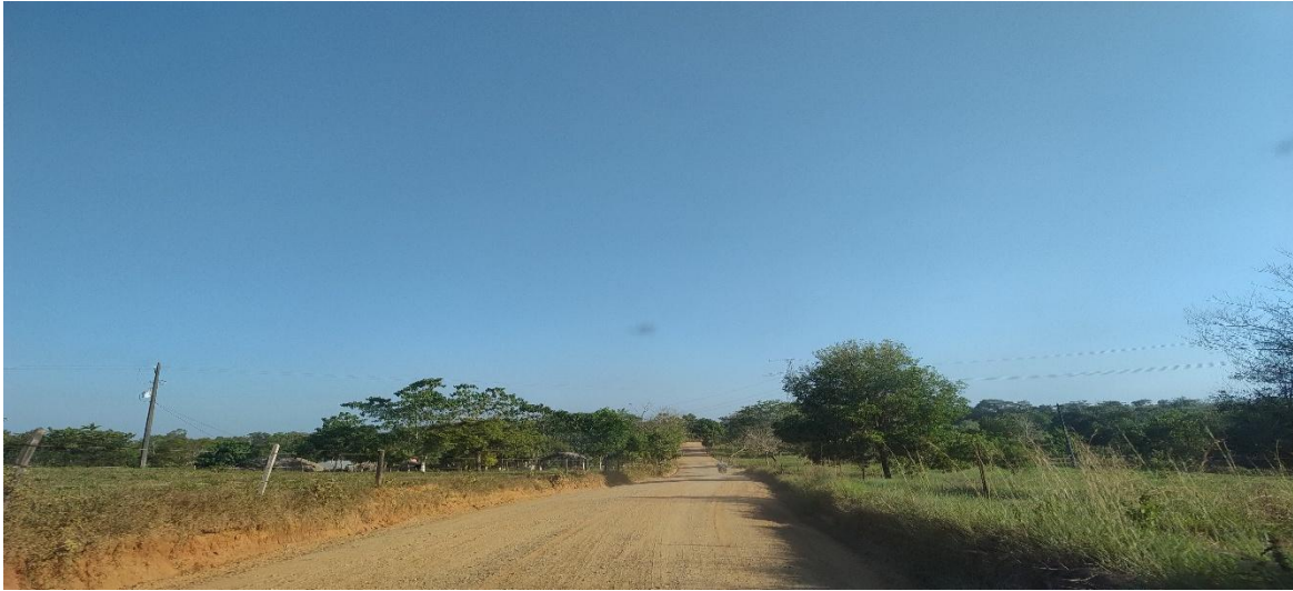
Base Granular en su cota terminada.
