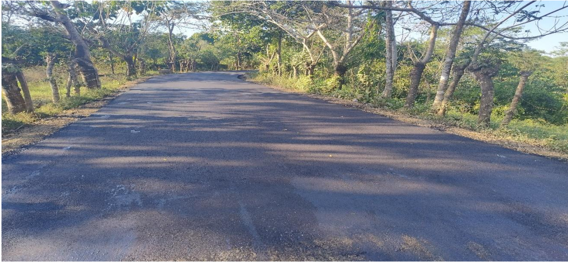
Zona de Junta donde se observan 2 jornadas de trabajo (inicio de la Jornada el día de la visita)
