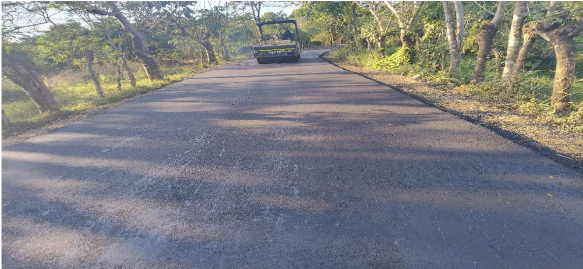
Proceso de Densificación adicional para mejorar el acabado Superficial (Sellado)
