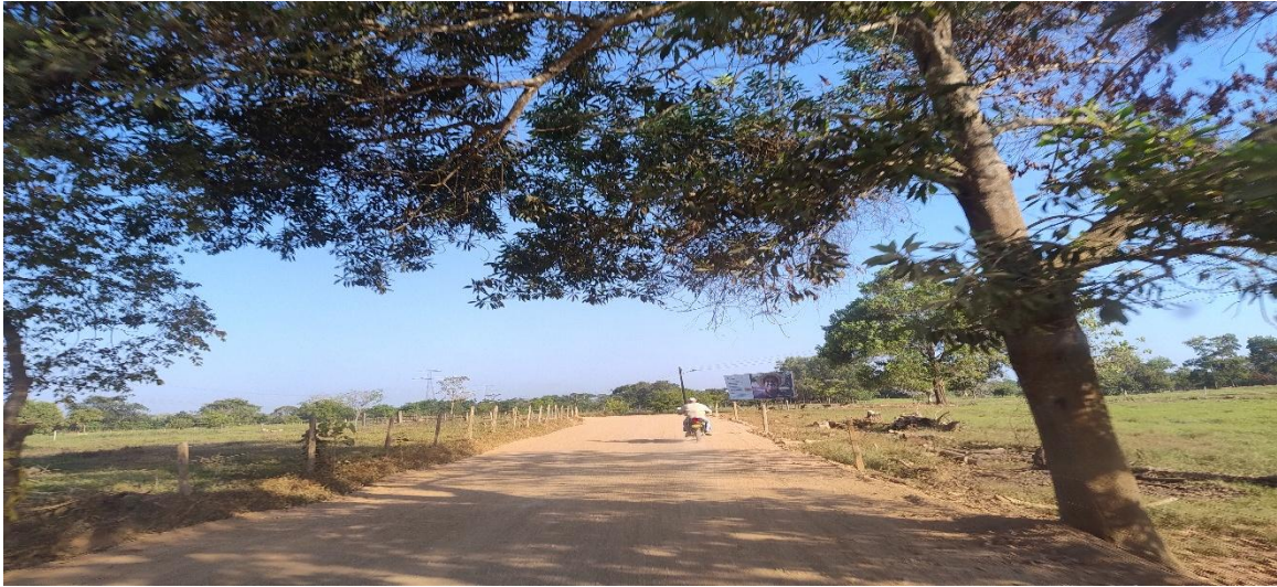
Inicio del Tramo No 2 Base Granular Cereada, próximamente para ser Imprimada.
