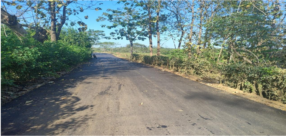
K1+000, Zona pendiente de la construcción de Berma Cunetas y mejora de las Zonas Laterales.
