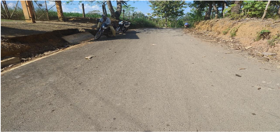
Inicio de la Colocación de la Carpeta Asfáltica.
