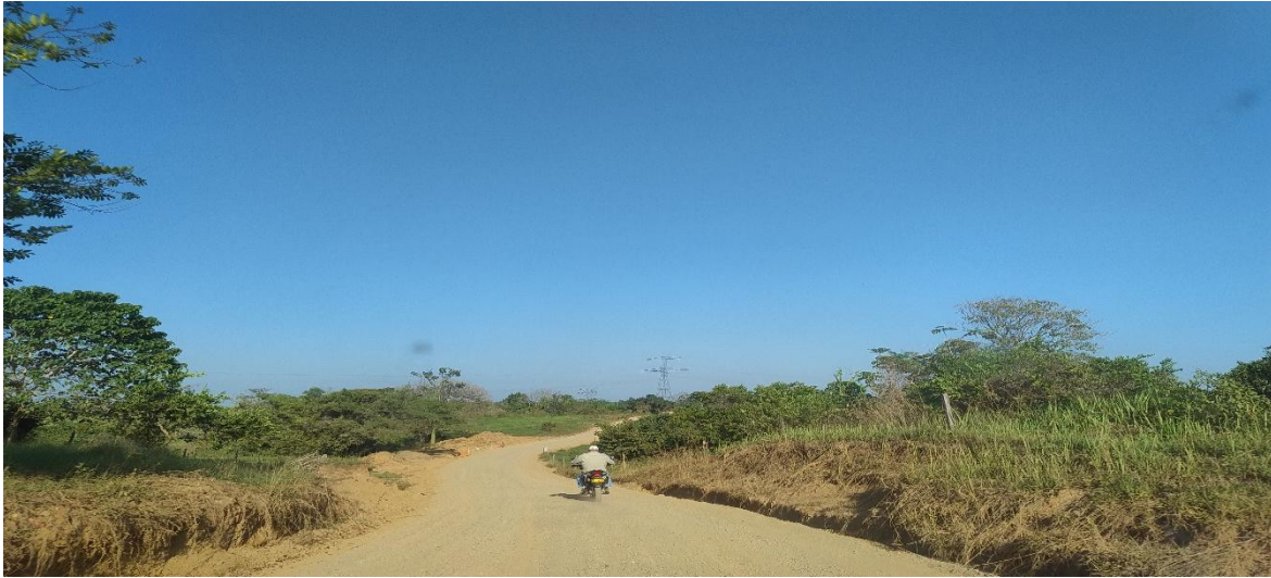
Zona aun en Subbase Granular, lista para la colocación de la Base Granular faltante.
