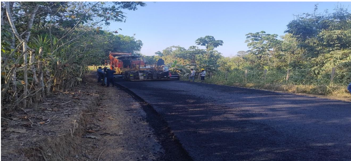
Proceso constructivo de Extensión y colocación de la MD-19
