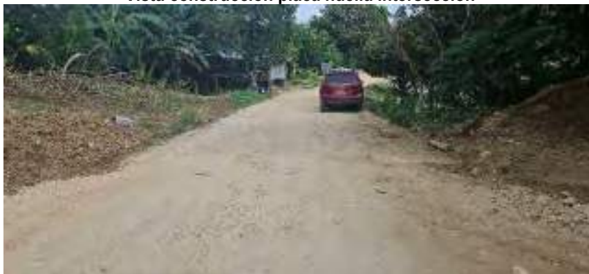
Vista estado placa huella construida
