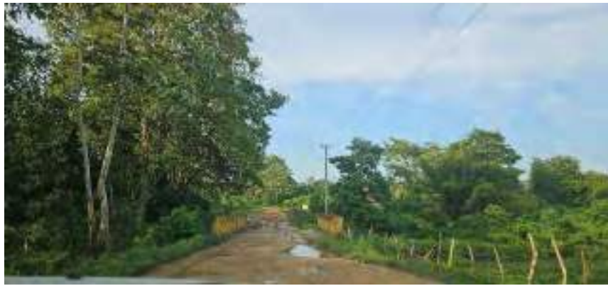
Vista estado corredor placa huella
