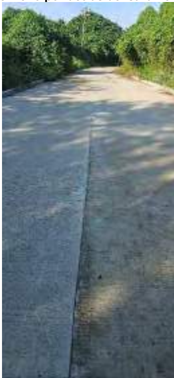
Vista doble corte en junta longitudinal
