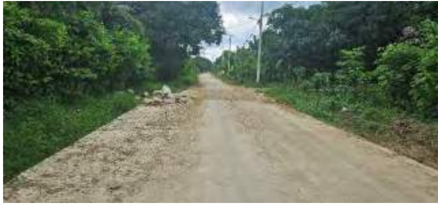
Vista estado pavimento rígido construido
