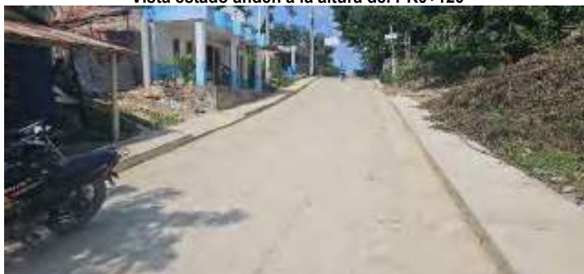
Vista estado placa huella construida
