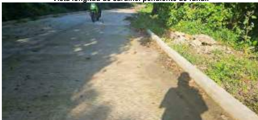
Vista estado de la estructura de pavimento a la altura del PR0+130
