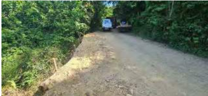
Vista sitio con reducido ancho para la construcción de la placa huella
