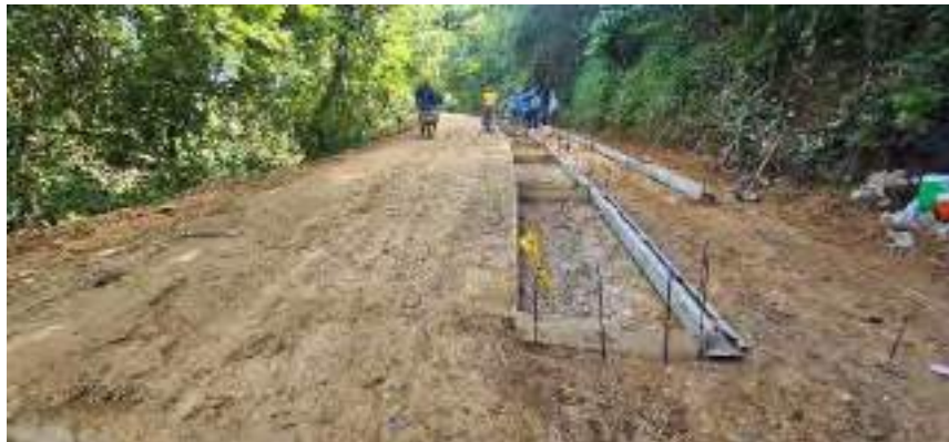
Vista estado construcción placa huella
