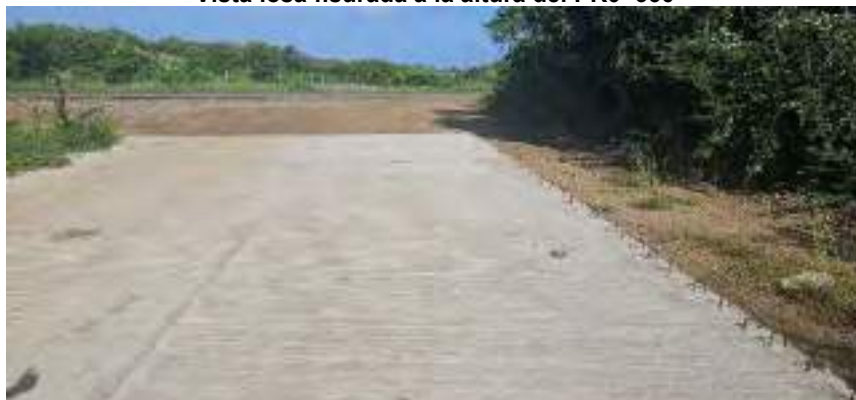
Vista final del tramo empalme a la vía pavimentada
