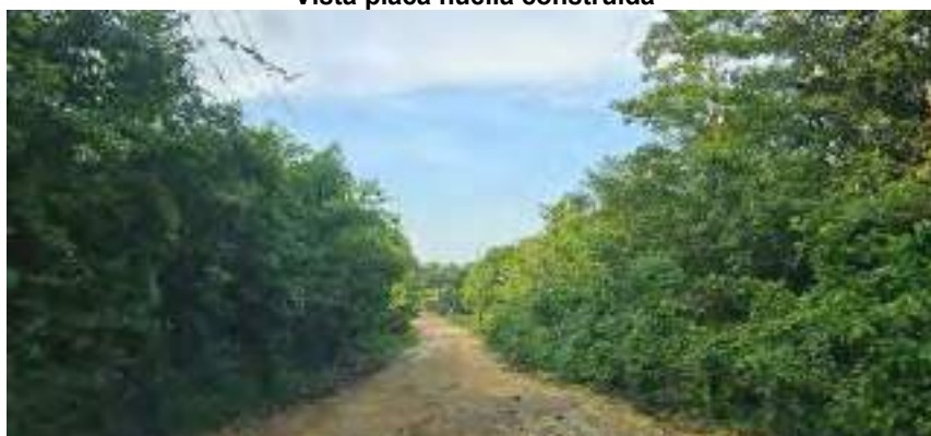
Vista corredor placa huella conformado
