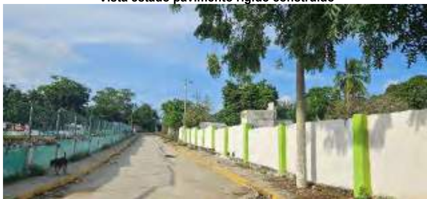
Vista estado pavimento rígido construido sobre la carrera 11
