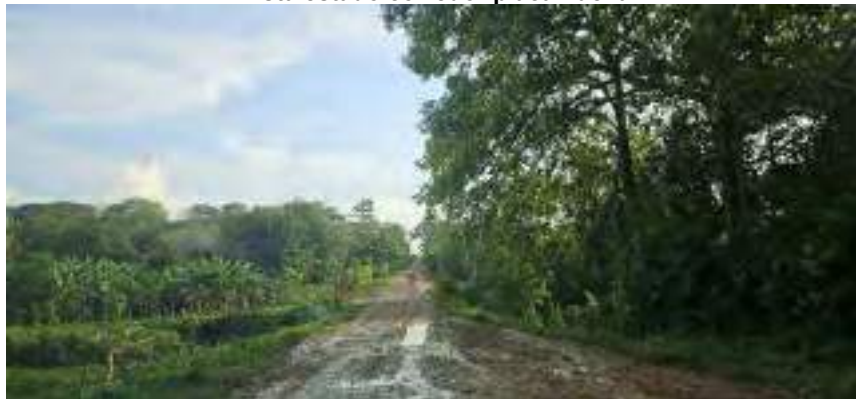
Vista estado corredor placa huella
