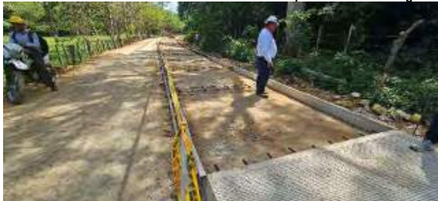
Vista instalación canastillas carril derecho San Juan De Nepomuceno – San Agustín
