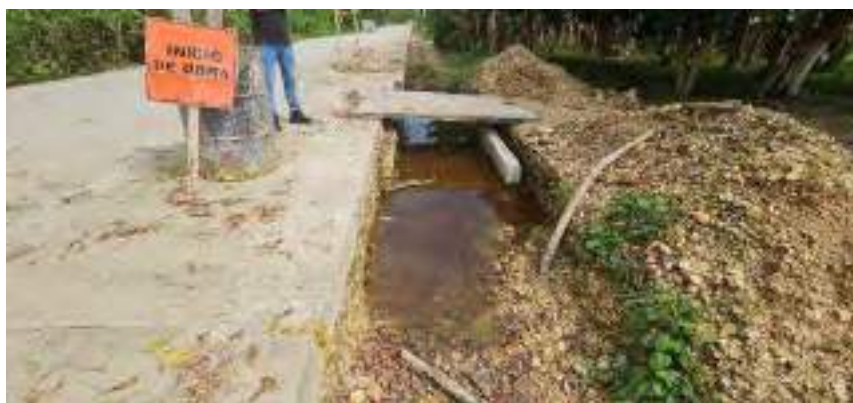
Vista construcción de acceso
