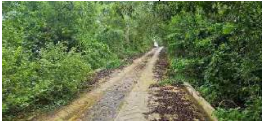
Vista estado construcción placa huella
