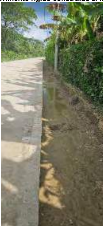
Vista cuneta longitudinal en tierra
