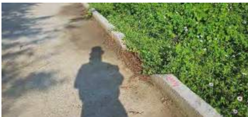
Vista ventana para el descole de agua de escorrentía a la altura del PR0+270
