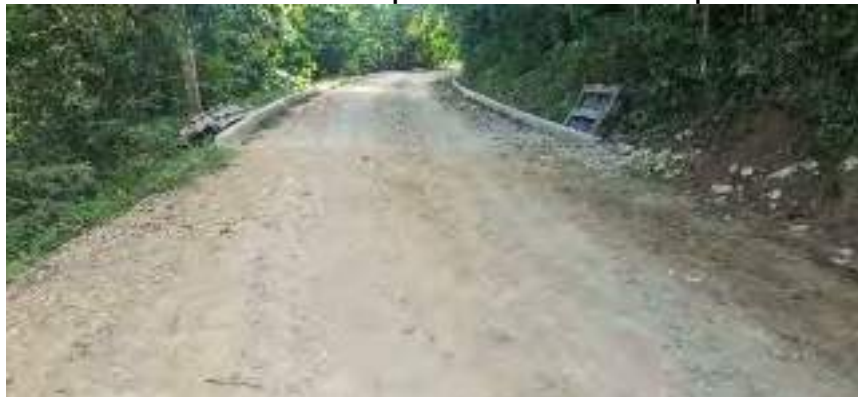
Vista estado placa huella construida
