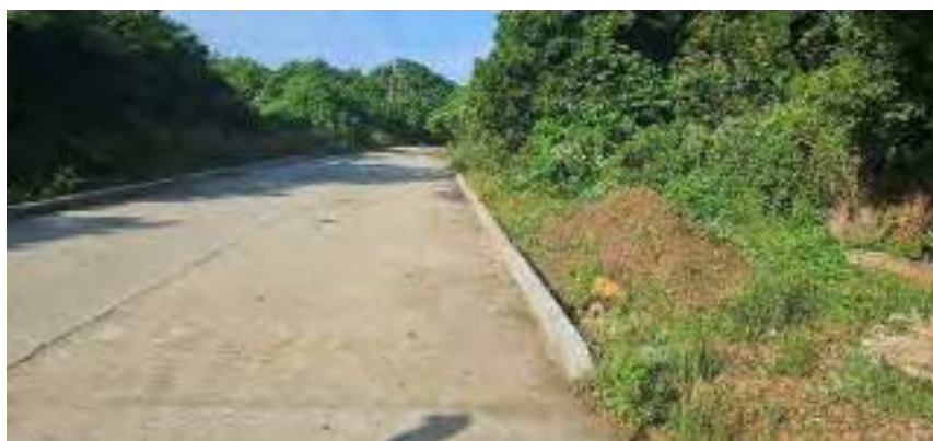
Vista falta realizar el lleno por detrás del sardinel y su conformación
