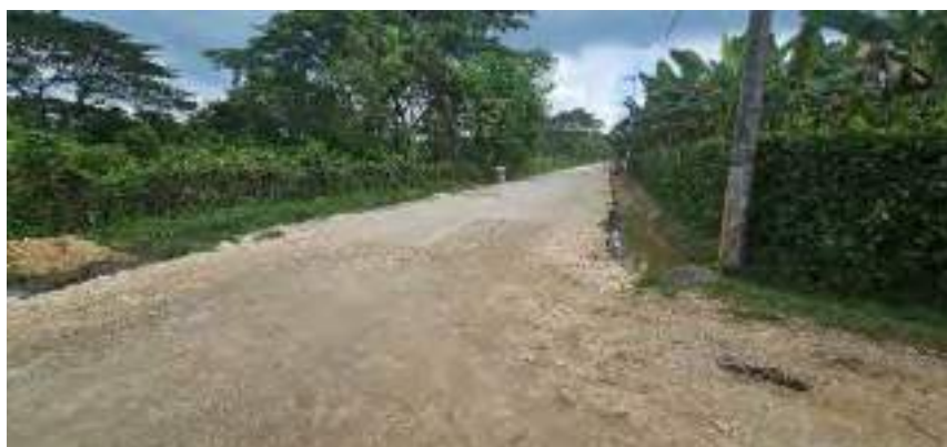
Vista estado pavimento rígido construido al inicio tramo PR0
