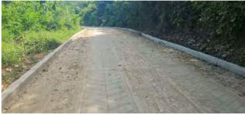
Vista estado placa huella construida
