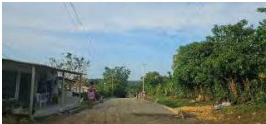
Vista placa huella construida
