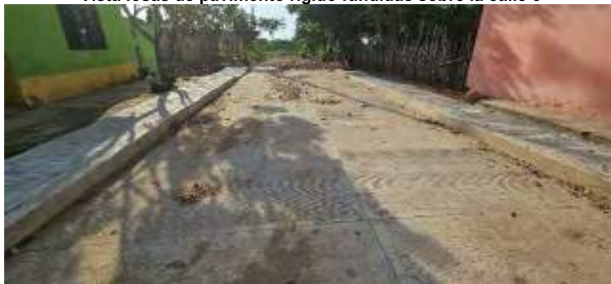
Vista losas de pavimento rígido fundidas sobre la calle 6
