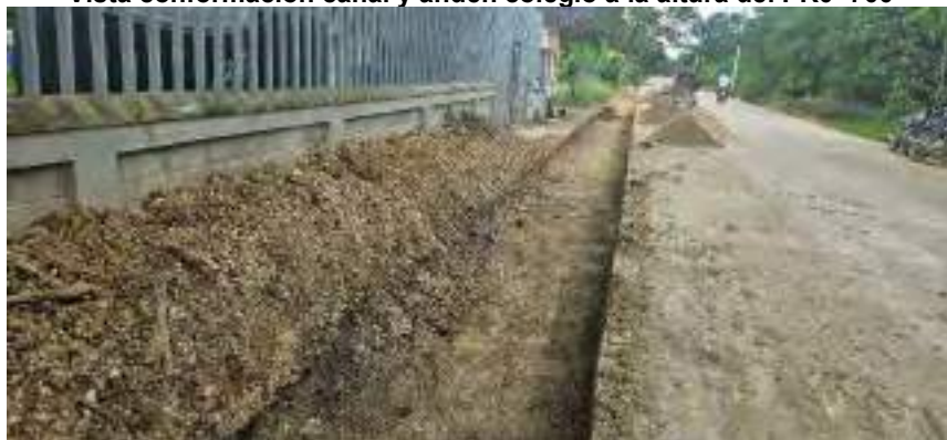
Vista conformación canal y andén colegio a la altura del PR0+700
