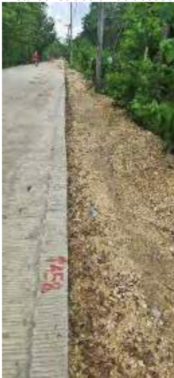
Vista estado conformación del canal longitudinal a la altura del PR0+458
