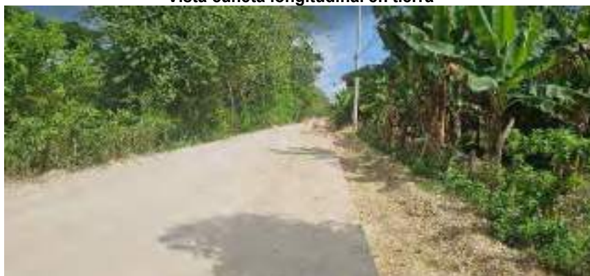
Vista estado pavimento rígido construido
