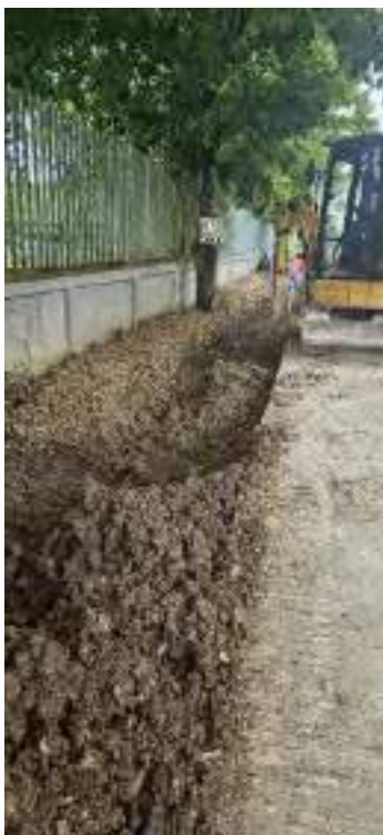
Vista conformación canal y andén colegio a la altura del PR0+700
