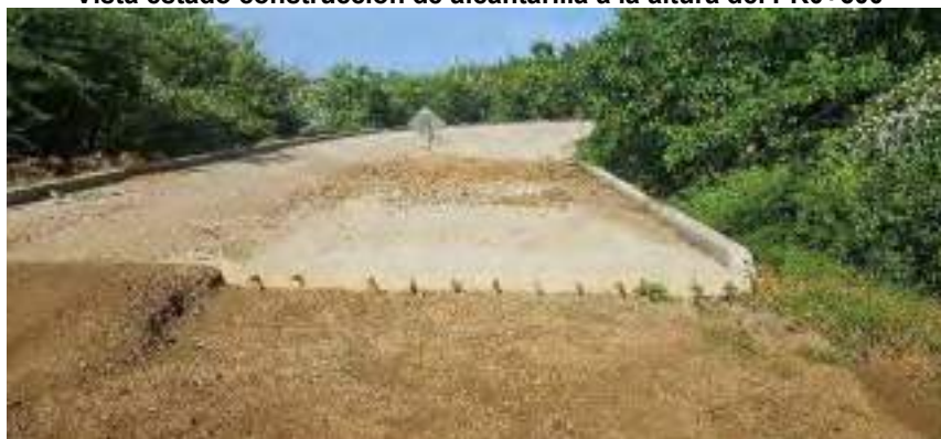
Vista estado barras de transferencia a la altura del PR0+600
