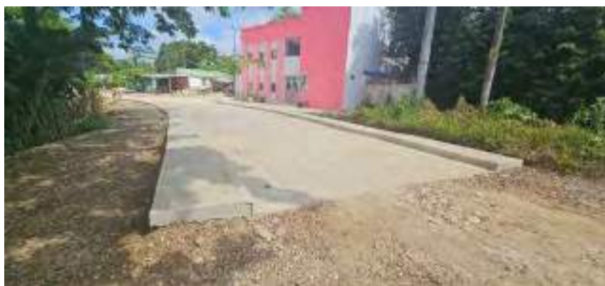
Vista estado placa huella construida
