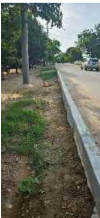
Vista estado zonas de andenes pendientes de construir
