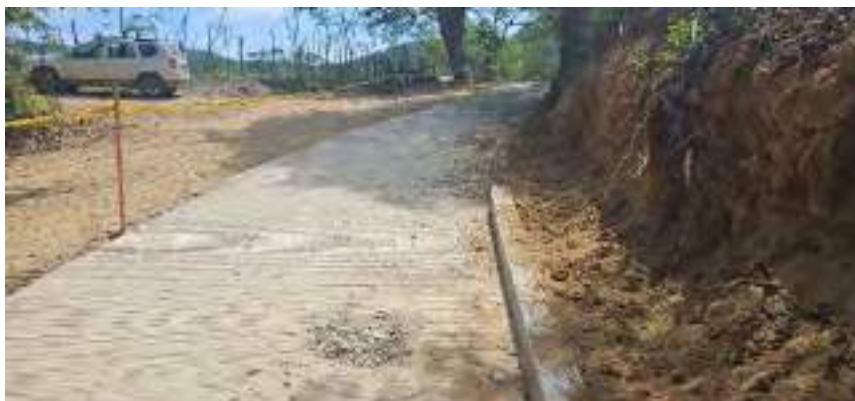
Vista construcción carril derecho San Juan De Nepomuceno – San Agustín
