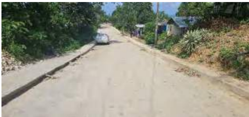
Vista estado placa huella construida
