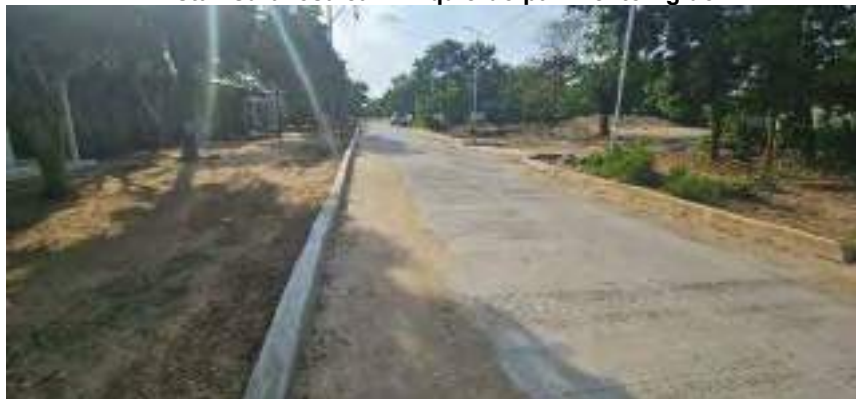
Vista estado zonas de andenes pendientes de construir
