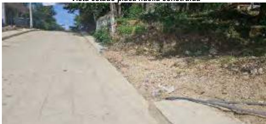
Vista estado acceso a la altura del PR0+163
