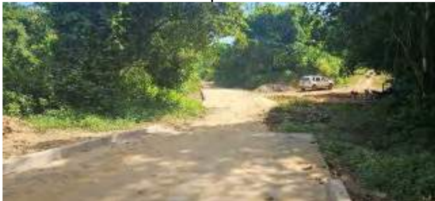
Vista sitio pendiente por construir batea para el cruce del agua
