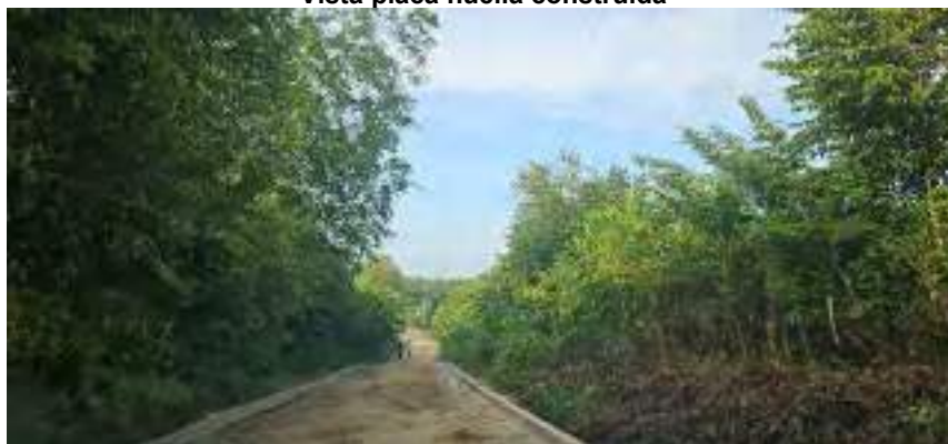
Vista placa huella construida
