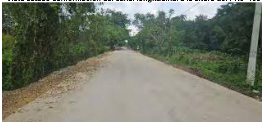
Vista estado pavimento rígido construido
