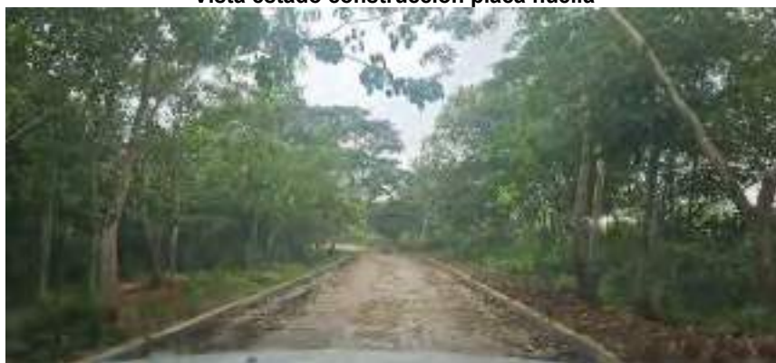
Vista estado construcción placa huella
