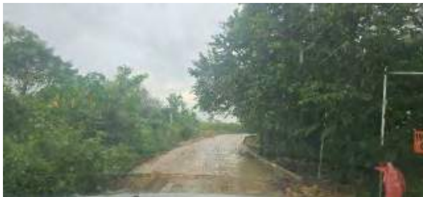
Vista estado construcción placa huella
