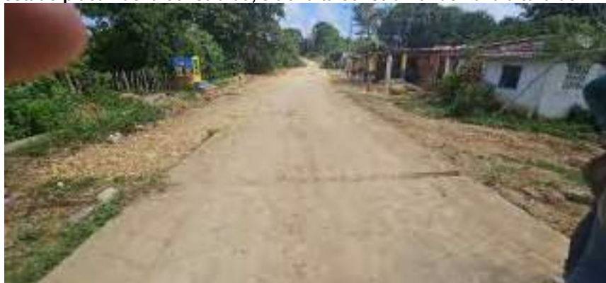
Vista estado placa huella construida
