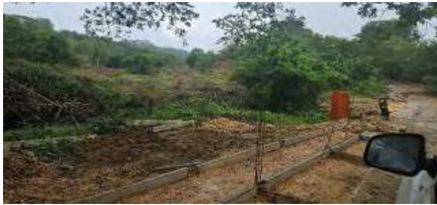
Vista estado construcción placa huella
