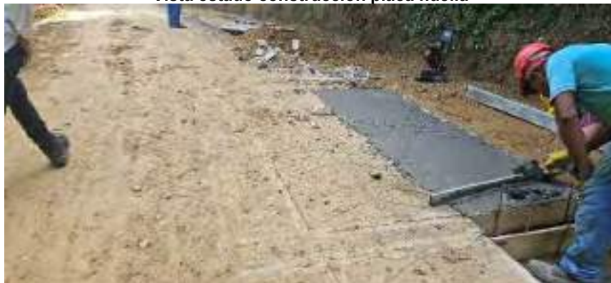
Vista estado construcción placa huella
