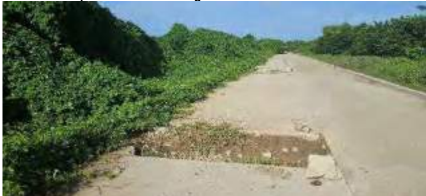
Vista reparación de losas demoliendo el tercio a la altura del PR0+460
