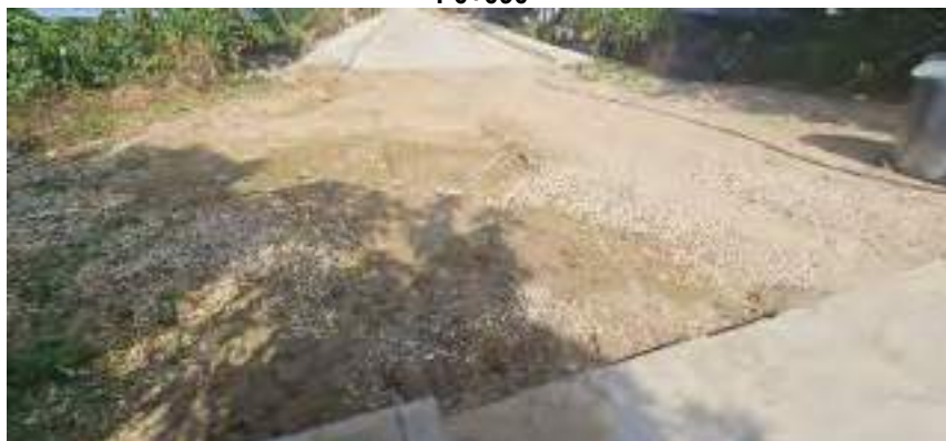
Vista pendiente por construir placas huellas zona de manejo de aguas esorrentía a la altura del P0+090
