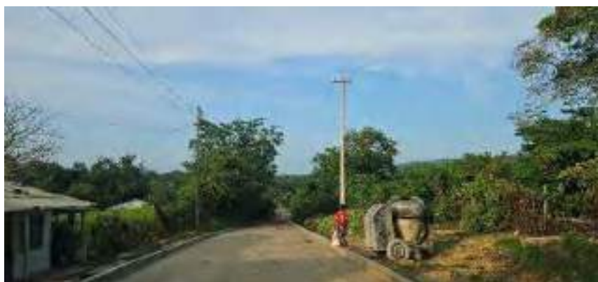
Vista placa huella construida
