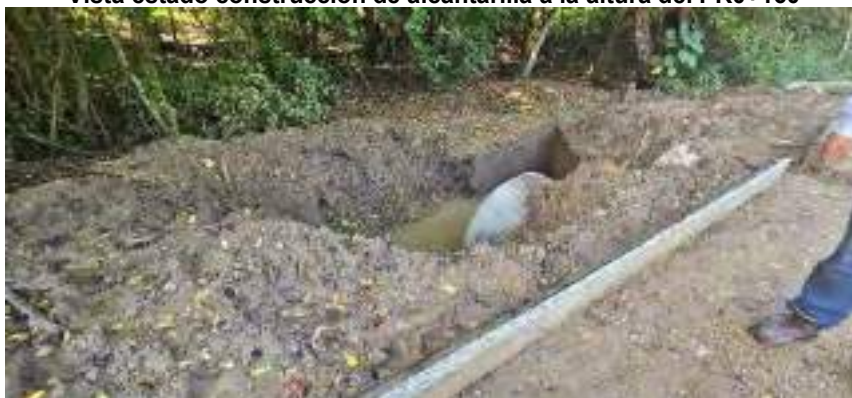
Vista estado construcción de alcantarilla a la altura del PR0+160
