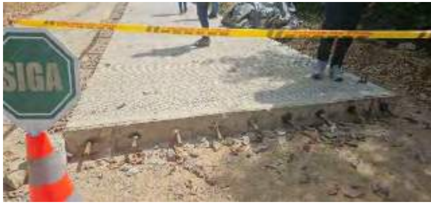
Vista instalación dovelas carril derecho San Juan De Nepomuceno – San Agustín
