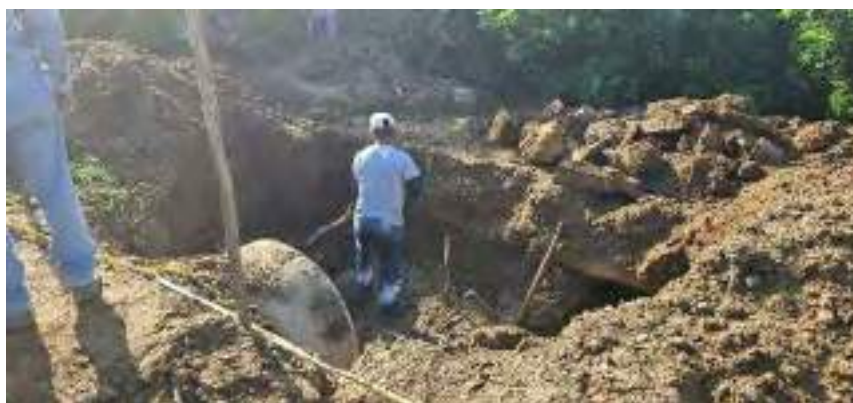
Vista estado construcción de alcantarilla a la altura del PR0+600
