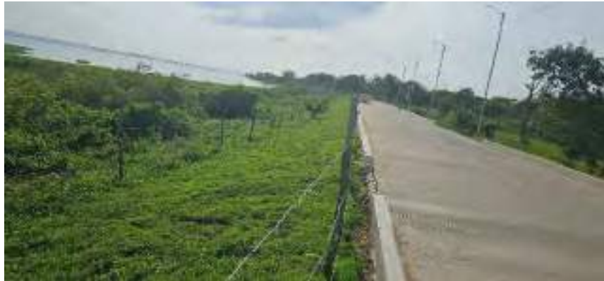
Vista estado del talud empedrado
