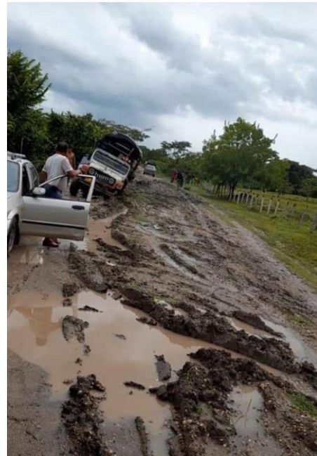
Fotografía 5. Tramo de la vía en terreno entre las abscisas k6+500 y k6+700
