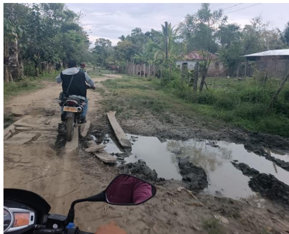
Fotografía 3. Tramo de la vía en terreno entre las abscisas K5+300 Y K5+400
