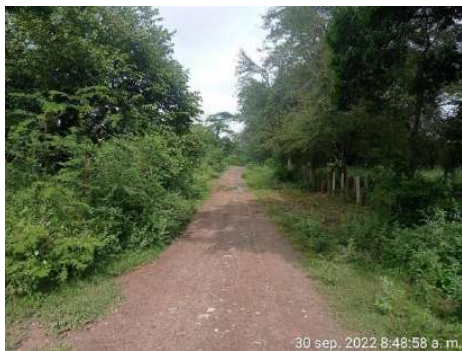
Fotografía 1 Estado actual de la vía. Contrato 104-2022
